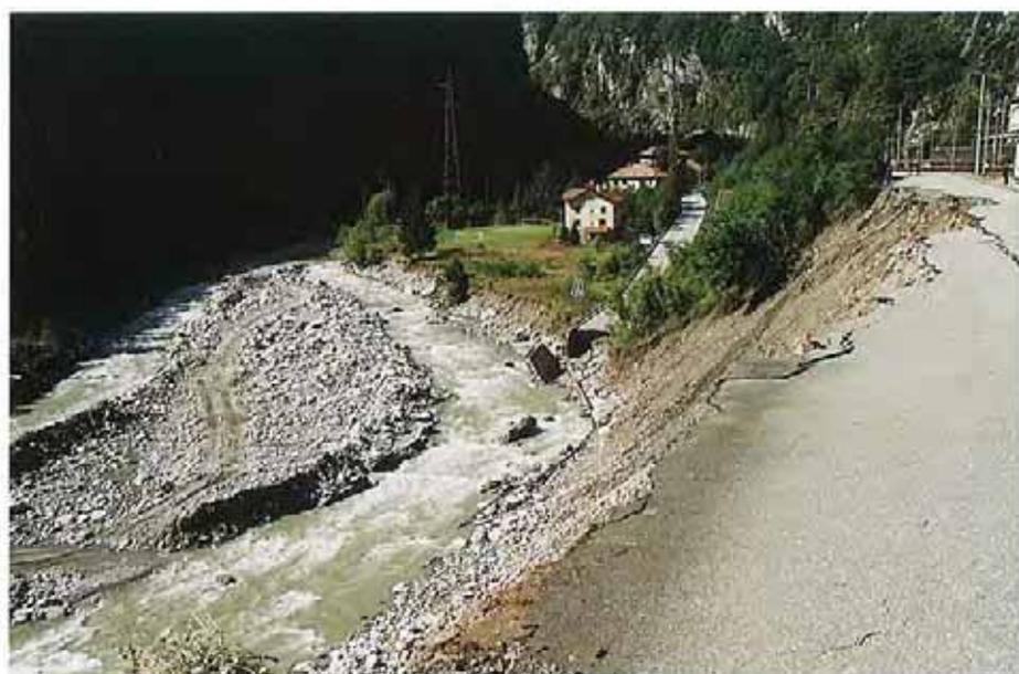
FOTO 1 - Trasquera (VB), località stazione di Iselle. L'erosione laterale del T. Diveria ha asportato le opere di difesa idraulica (di cui si intravedono i resti verso il margine inferiore sinistro della foto) ed il corpo stradale della S.S. 33, intaccando il rilevato ferroviario e la strada di accesso alla stazione (in primo piano).
