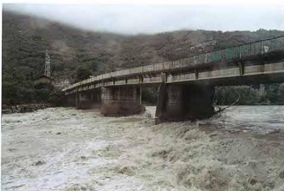
FOTO 18 - Ponte di Quassolo (TO): pila scalzata per accentuata erosione di fondo.
