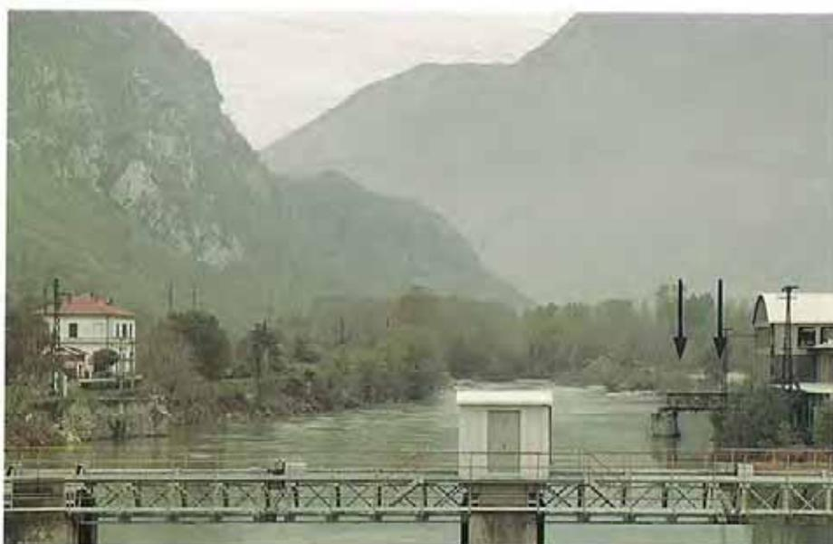
FOTO 17 - Quincinetto (TO): in secondo piano si osserva (indicata dalle frecce) la struttura restante del ponte crollato durante la piena.
