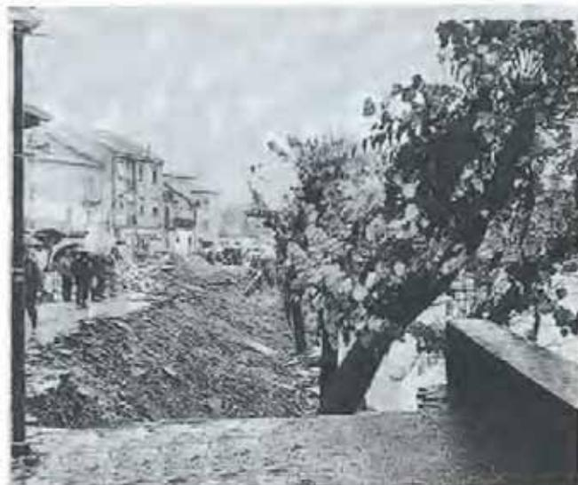
Fig. 88. Nizza Monferrato. Parte del muro arginale lungo Via F. Cirio asportato dal T. Belbo (foto da "La Nuova Provincia", 11-11-1994).
