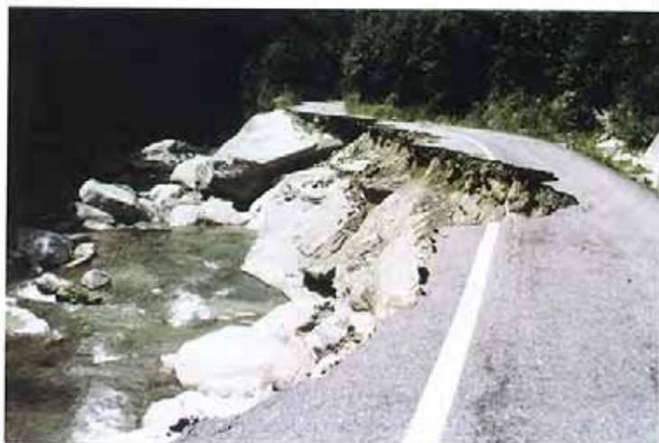
**Fig. 15.** *Torrente Casotto. Ripresa dei gravissimi danni sofferti dalla strada provinciale di fondovalle a seguito delle violente erosioni spondali.*
