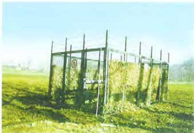
Fig. 20. Comune di Asti. Torrente Borbore. Centralina del metanodotto alluvionata presso Revignano; l'altezza dell'acqua superava 1.5 m.
