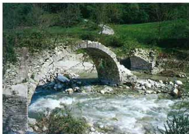
**Fig. 13.** Torrente Corsaglia, località Ponte Soprano. I resti dell'antico manufatto dopo il passaggio della piena del 5 novembre 1994.
