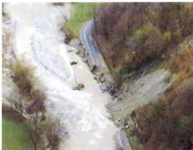
**Fig. 11.** Comune di Frabosa Soprana, località Corsaglia. L'immagine, tratta da ripresa aerea, mostra la strada provinciale di fondovalle asportata da erosione laterale del torrente Corsaglia. Il processo ha ulteriormente riattivato il movimento franoso di versante già presente a monte del manufatto.
