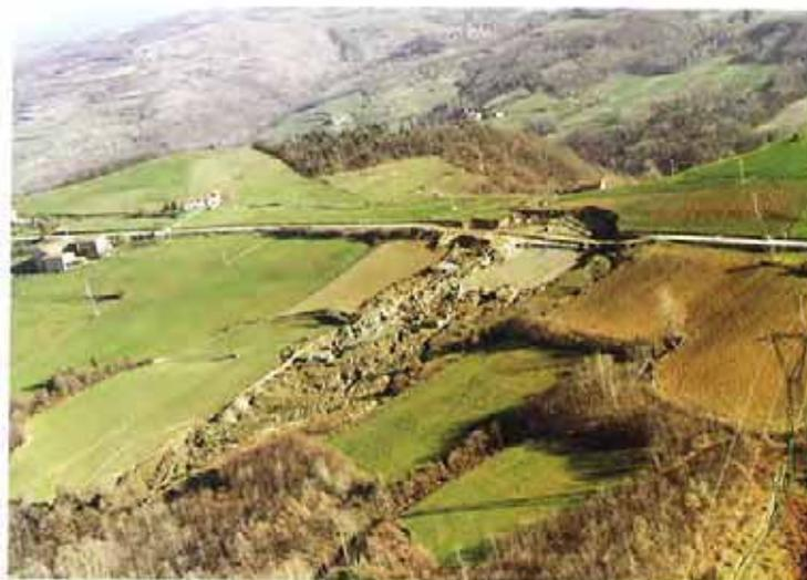
**Fig. 5.** Comune di Murazzano, località C. Bruciata. Lo spettacolare scivolamento planare che ha interrotto la strada statale tra Murazzano e Bossolasco, può essere preso come esempio di un processo evoluto.
