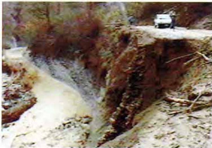
Fig. 1. Rio Bovina, Comune di Ceva. L'eccezionale livello raggiunto dall'acqua ha provocato profonde erosioni laterali e gravi danni alla rete stradale.
