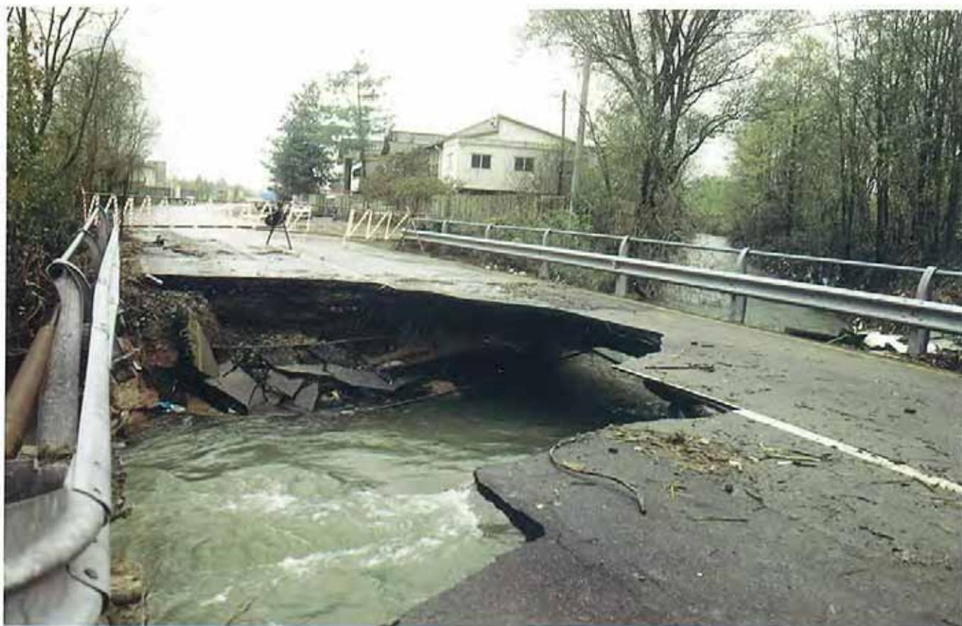
Fig. 24. Comune di Volpiano. Ripresa da Est dell'attraversamento sul t. Bendola, lungo la strada statale tra Volpiano e Leini, gravemente danneggiato dalle acque di piena del torrente.
