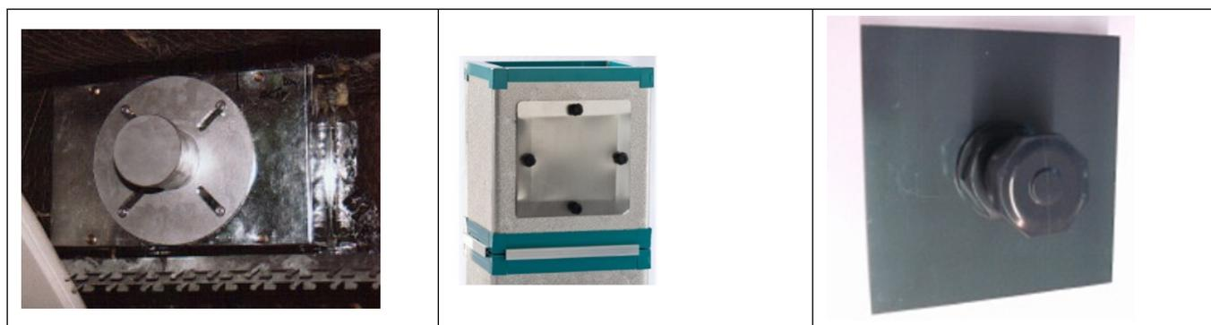
**Figura 8. Sportelli e punti di ispezione lungo le canalizzazioni**
