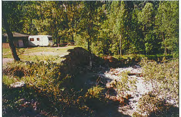
Figura 90 - Vinadio. Erosione di sponda del T. Neirassa presso il campeggio. (VD61)
