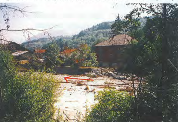
Figura 38 - Oulx, sponda destra a monte dell'abitato. (VS39)
