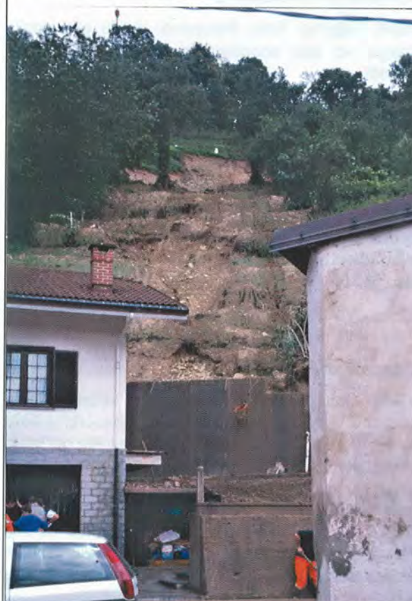
Figura 112 - Peveragno. Edificio posto alla base del versante investito da una frana. (VJ12)
