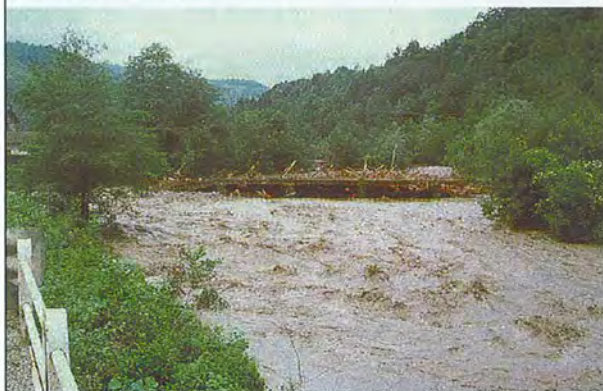
Figura 72 - Melle. Il ponte presso il capoluogo crollato alle ore 11:00 del giorno 13. (VV30)
