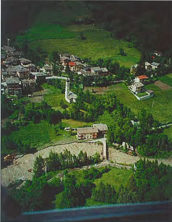
Figura 81 - Prazzo. Due edifici in sponda sinistra minacciati da erosioni del Maira. (VM09)
