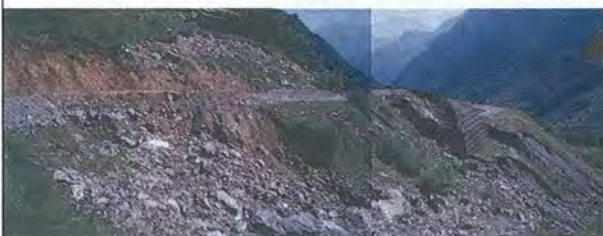
Figura 99 - Entracque. Strada valle del Gesso della Rovina: attraversamento del rio Laitus (VG02)
