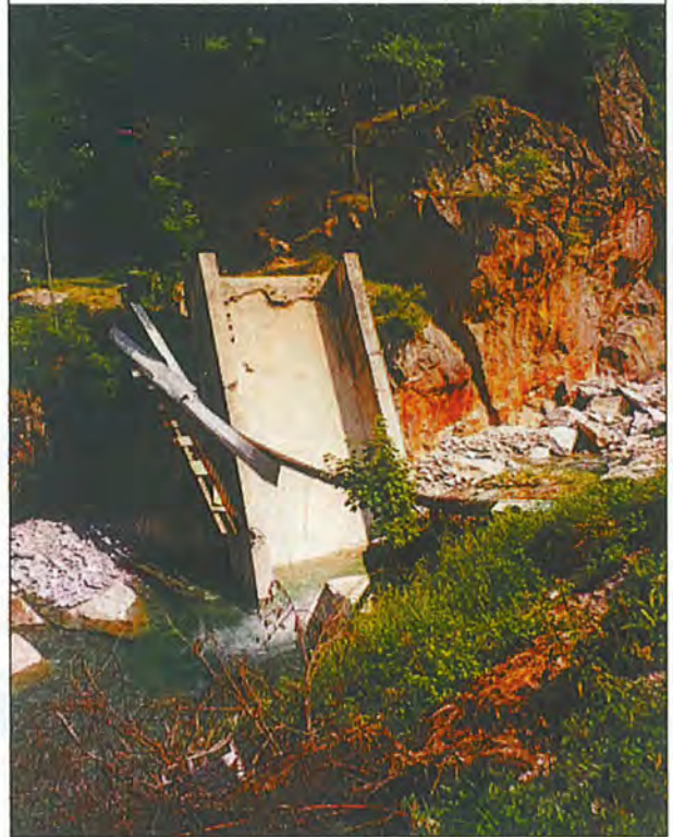
Figura 86 - Vinadio. Loc Pianche, ponte sul rio Corborant. (VD28)
