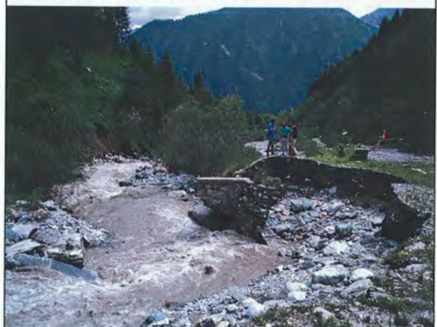
Figura 78 - Acceglio. Briglia asportata e aggirata dal rio Mollasco in destra idrografica. (VM02)
