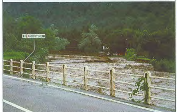
Figura 73 - Melle. Cedimento del ponte sul Varaita di accesso al campeggio. (VV31)
