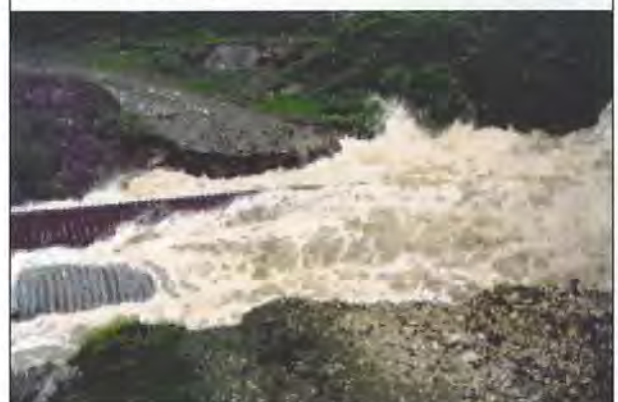
Figura 53 - Crissolo; guado di Riundin sul F. Po. Deflusso verso sinistra. (VP02)
