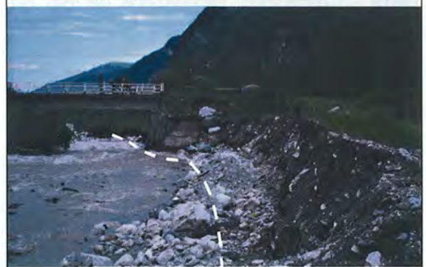
Danni per erosione al ponte per la fraz. Frere e asportazione della pista di fondo (linea bianca).
