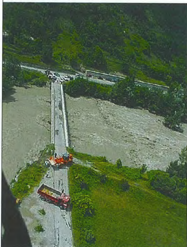
Figura 94 - Moiola. Ponte di loc. S. Membotto, ripresa del 13/6, ore 14.26. (VD96)
