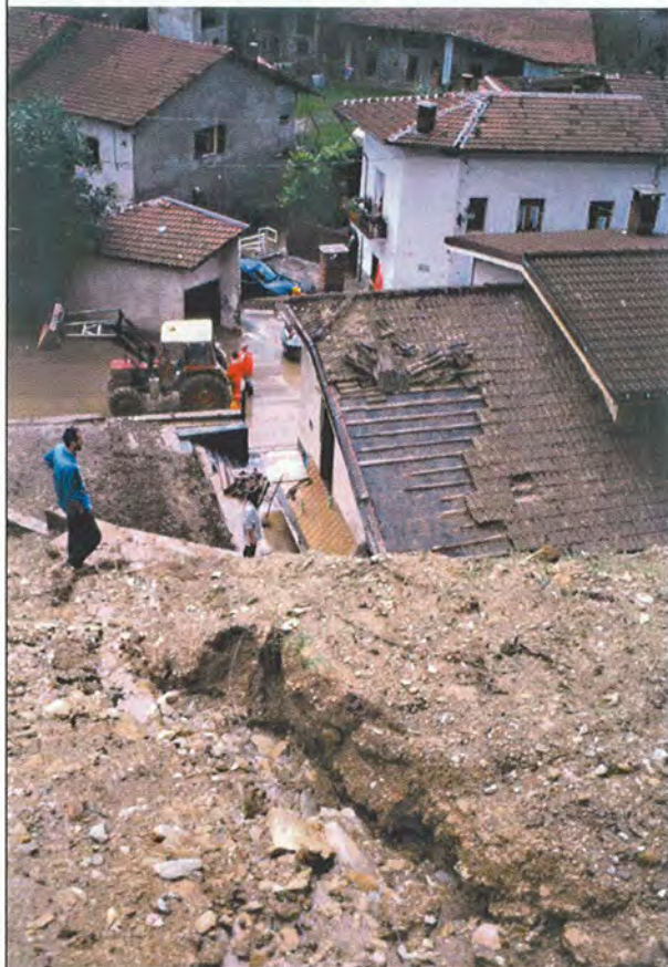
Figura 113 - Peveragno. Edificio danneggiato da una colata detritica. (VJ12)
