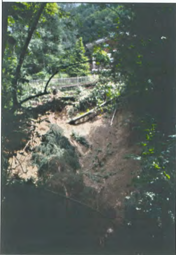
Figura 111 - Boves. Strada comunale minacciata da una frana superficiale. (VJ10)
