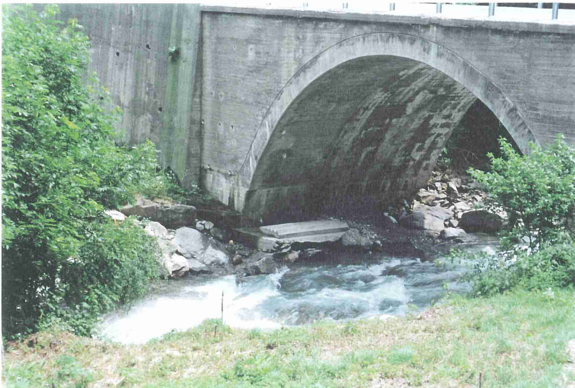
Foto 21d - Torrente Germanasca - Comune di Praly – Località Gardiola Fenomeni erosivi a valle del ponte sulla SP 169, in sinistra idrografica.
