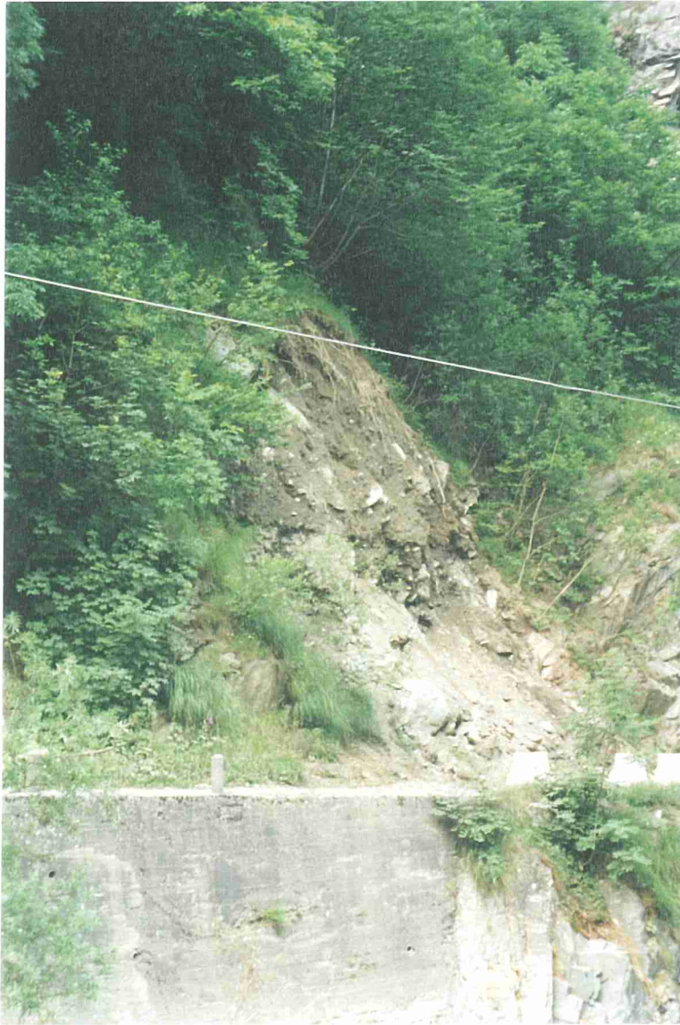
Foto 2e - Torrente Pellice - Comune di Bobbio Pellice Lungo la SP 161 frana della coltre superficiale circa a quota 1023 m sul versante sinistro.
