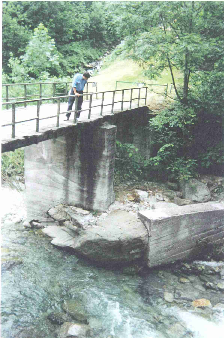
Foto 21f - Torrente Ghicciard – Bobbio Pellice – Comba dei Carbonieri. Ponte sul T. Ghicciard per Frazione Lautaret: restringimento della sezione d'alveo e occlusione di una luce del ponte in sponda destra.
