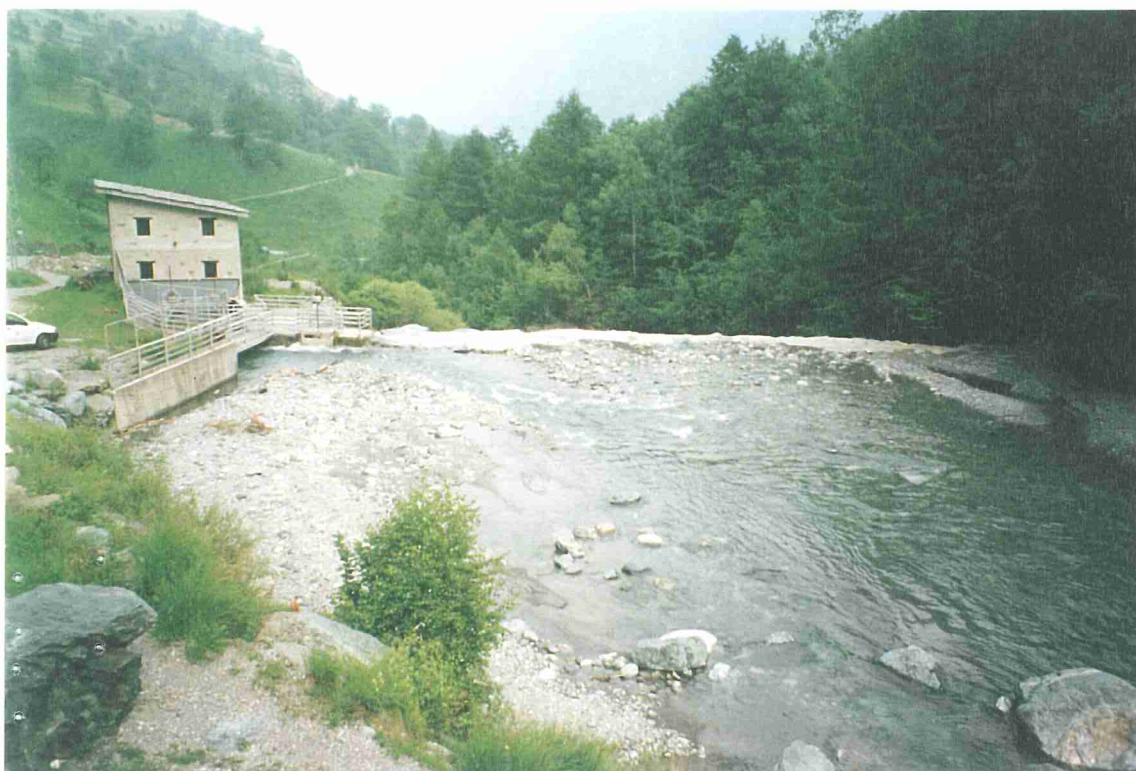
Foto 4e – Torrente Pellice - Comune di Bobbio Pellice. Piccolo Bacino idroelettrico ubicato a quota 1063 m lungo il corso del T. Pellice completamente riempito dal materiale trasportato dalla piena.
