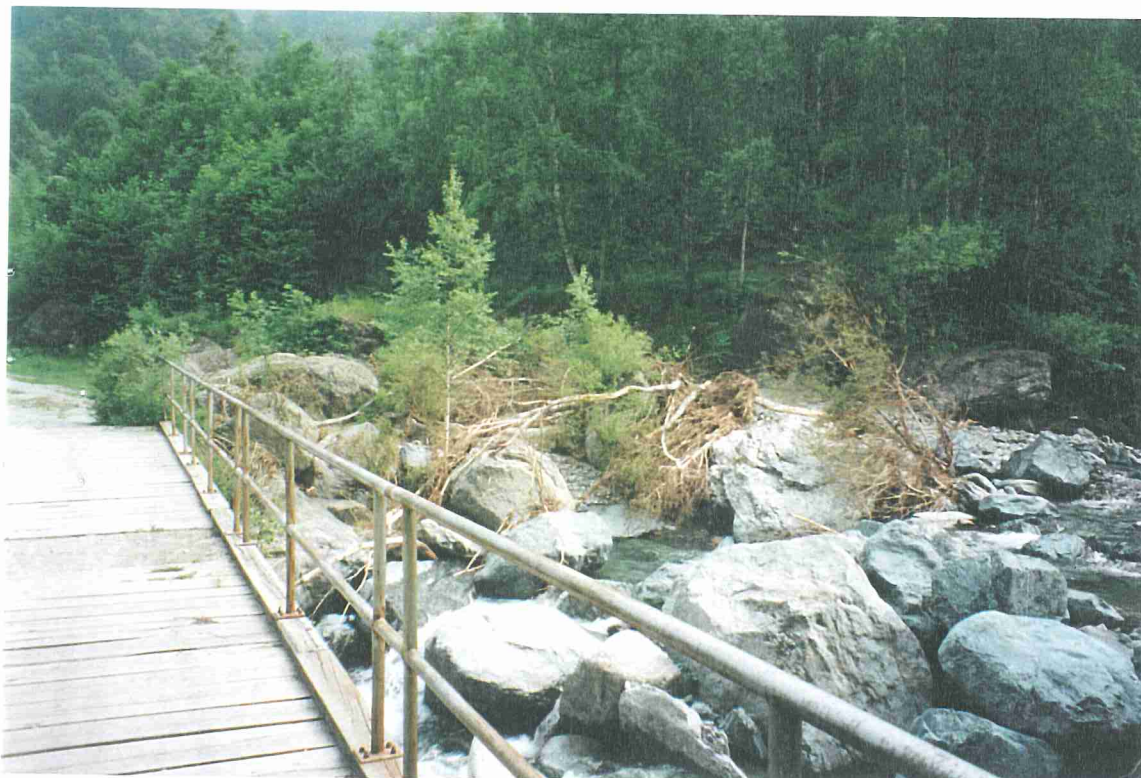
Foto 3e – Torrente Pellice - Comune di Bobbio Pellice. Trasporto di grandi blocchi nel Torrente Pellice con riattivazione di canali abbandonati in destra e sinistra a monte del ponte a servizio della strada sterrata per la Frazione La Selletta.
