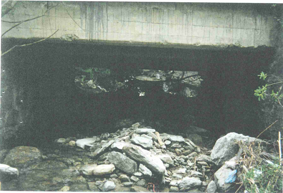
Foto 18f - Torrente Ghicciard – Bobbio Pellice – Comba dei Carbonieri. Strada per il Rifugio Barbara Lowrie a quota 963 m s.l.m. (in prossimità di Frazione Carbonieri): parziale occlusione della luce dell'attraversamento di un rio minore sul versante sinistro a servizio della strada.
