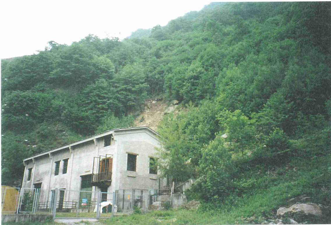
Foto 6e – Torrente Pellice - Comune di Bobbio Pellice. Poco a valle di località Molbec, alle spalle della centrale idroelettrica, frana innescatasi nella coltre di copertura.
