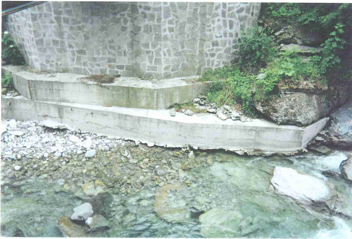
Foto 23f - Torrente Ghicciard – Bobbio Pellice – Comba dei Carbonieri. Ponte sul T. Ghicciard: sottoscalzamento della spalla destra presso la Centrale Idroelettrica di Località Perla.
