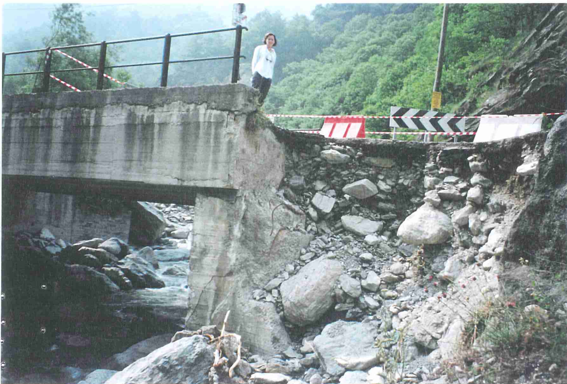
Foto 24d - Torrente Pellice - Comune di Bobbio Pellice – Località Malbec Fenomeni erosivi da ruscellamento concentrato, a valle del ponte sulla SP 161, in sponda sinistra.
