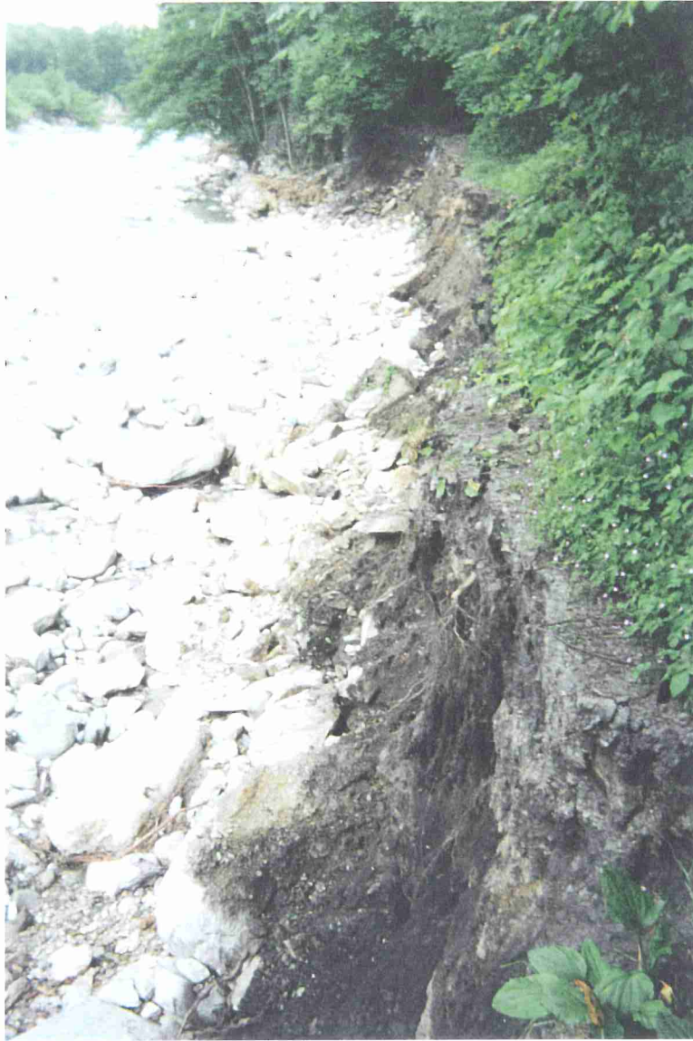
Foto 9 f - Torrente Pellice – Comune di Villar Pellice. Erosione in sponda destra del T. Pellice, a valle del ponte di Villar Pellice, per un tratto di circa 300 m con asportazione della sovrastante strada sterrata per un tratto di circa 30 m.
