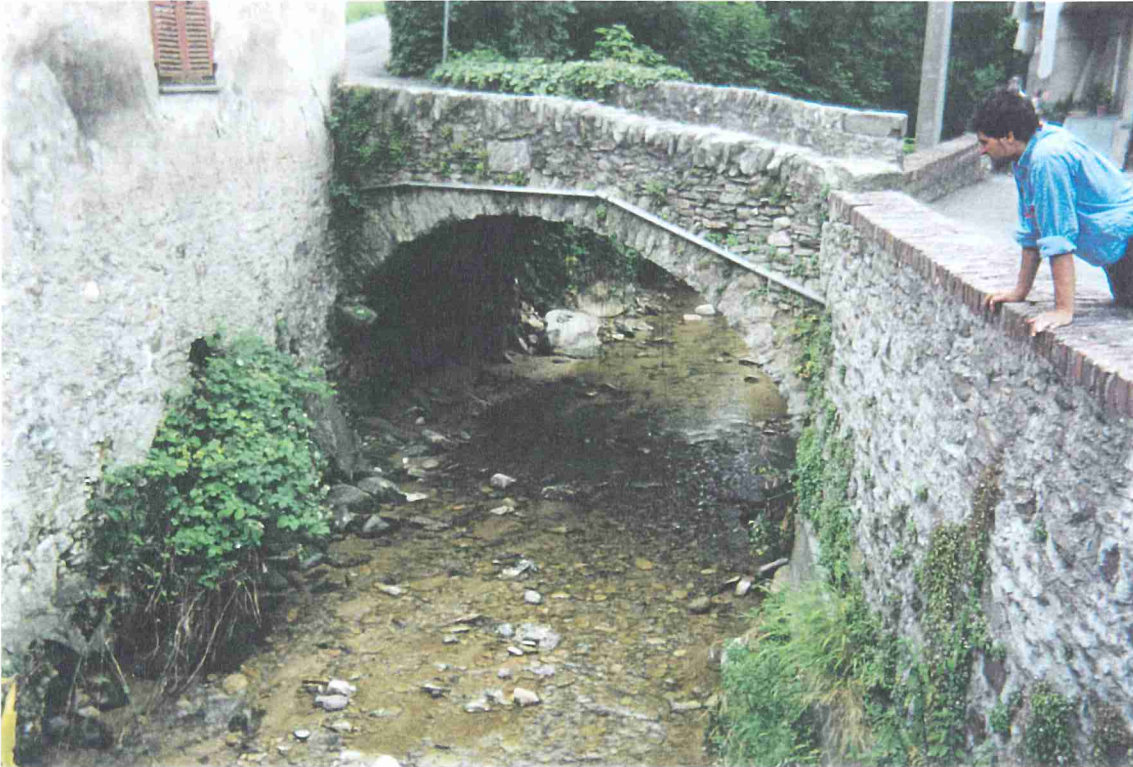
Foto 7 f – Comune di Bibiana . Ponte sul canale tombato che attraversa il paese. Leggera sottoescavazione della spalla destra.
