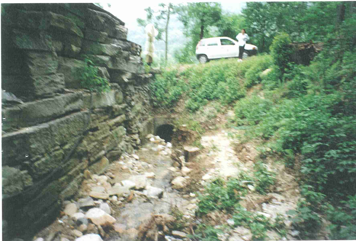
Foto 9e -Torrente Luserna – Comune di Luserna S.Giovanni. In corrispondenza di località Maddalena, sul versante sinistro, un rio minore, tributario del T. Luserna, è stato deviato e tombato. Si nota il notevole restringimento della sezione d'alveo.
