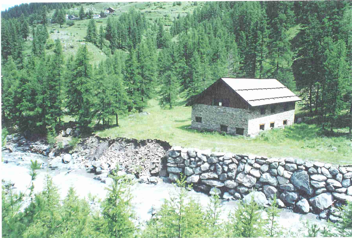
Foto 24c - Torrente Ripa - Comune di Sauze di Cesana – Val Argentera La piena ha asportato in destra idrografica, un tratto di scogliera (circa 15 m di lunghezza) presso la Centrale Idroelettrica in località Giudigiai.
