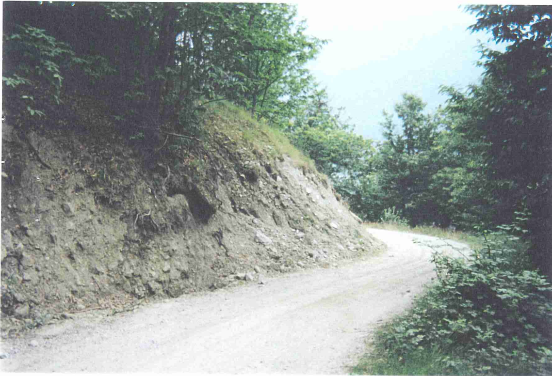
Foto 15f - Torrente Ghicciard – Bobbio Pellice – Comba dei Carbonieri. Strada per il Rifugio Barbara Lowrie in corrispondenza di Località Perla: piccole frane di scivolamento ed erosioni sulla scarpata di monte in prossimità dell'abitato Perla.
