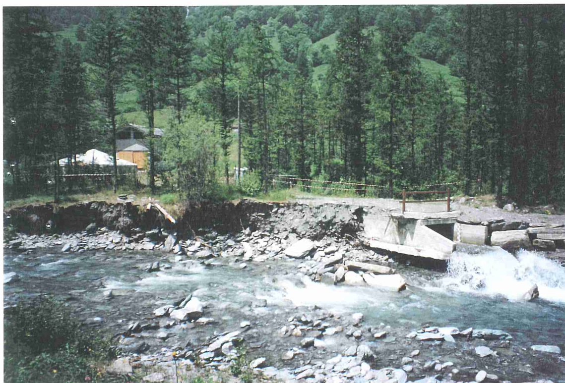
Foto 9d - Torrente Germanasca - Comune di Praly – Località Ghigo Poco a valle di frazione Pomieri l'erosione spondale in sinistra, presso un campeggio, ha scalzato lo scatolare di attraversamento di un affluente di sinistra.
