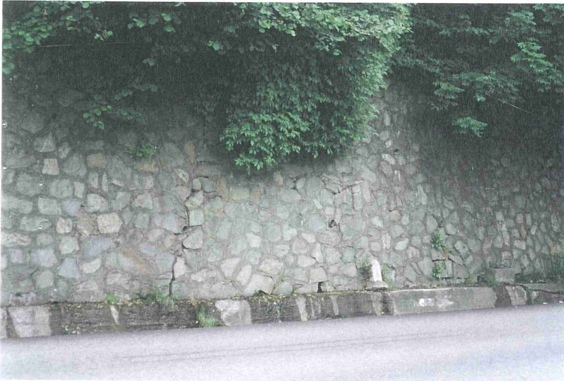
Foto 23d - Torrente Chisone - Comune di San Germano Chisone – Lungo la SS 23, in prossimità del ponte sulla SP 168 un muro in muratura presenta evidenti crepe.
