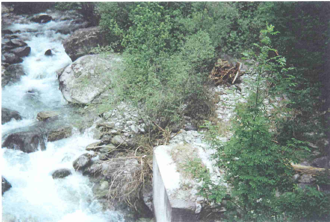
Foto 20f - Torrente Ghicciard – Bobbio Pellice – Comba dei Carbonieri. Ponte sul T. Ghicciard per Frazione Lautaret: muro sottoscalzato in sponda sinistra a valle del ponte.
