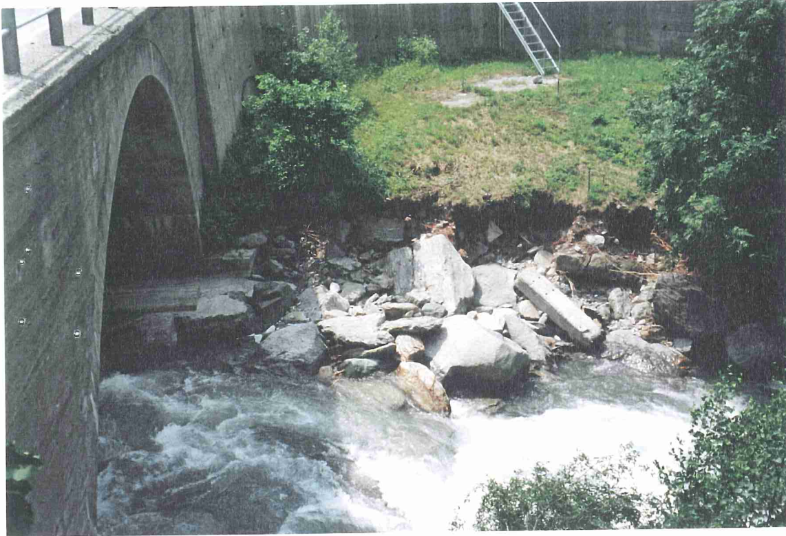
Foto 21d - Torrente Germanasca - Comune di Praly – Località Gardiola Fenomeni erosivi a valle del ponte sulla SP 169, in sinistra idrografica.
