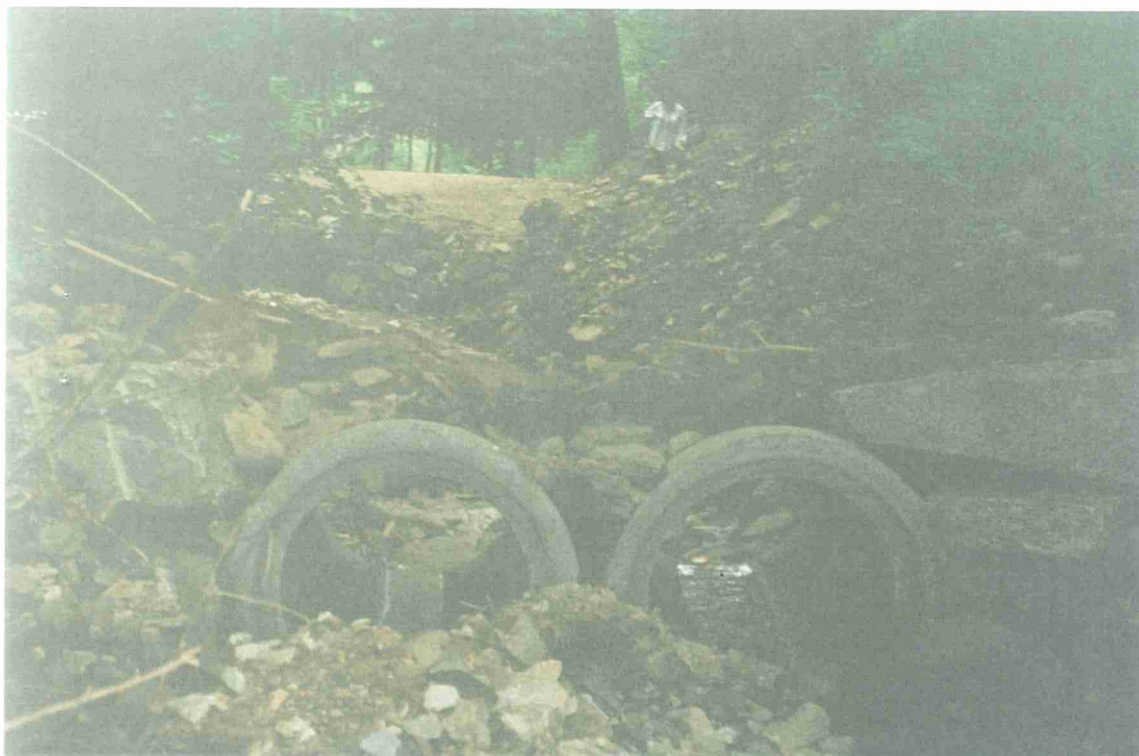
Foto 14e - Torrente Luserna– Comune di Lucerna S. Giovanni. Restringimento della sezione d'alveo lungo un rio minore al limite orientale della Frazione Fenoglia.
