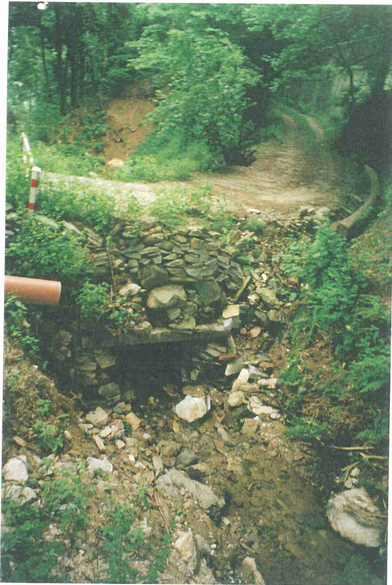
Foto 12e - Torrente Luserna – Comune di Luserna S. Giovanni. Restringimento della sezione d'alveo lungo un Rio minore al limite occidentale della Frazione Fenoglia.
