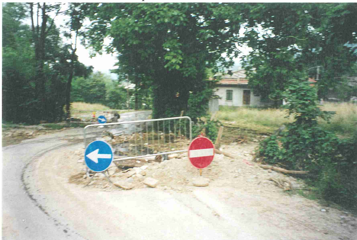
Foto 8e – Torrente Luserna - Comune di Bobbio Pellice. In corrispondenza di Località Maddalena, sul versante sinistro, un rio minore tributario del T. Luserna, è stato deviato e tombato: sulla strada si notano le voragini e i danni a seguito dell'aumento della pressione dell'acqua.
