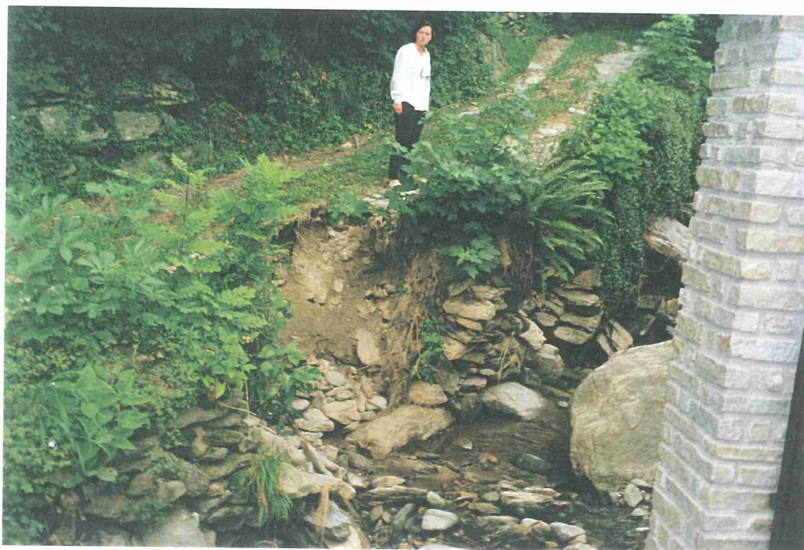
Foto 15e – Torrente Luserna – Comune di Lucerna S. Giovanni. Al limite occidentale della frazione Fenoglia, il rio minore confluyente del T. Luserna ha causato erosioni in sponda destra, in corrispondenza delle case.
