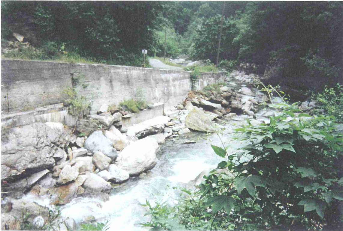
Foto 20f - Torrente Ghicciard – Bobbio Pellice – Comba dei Carbonieri. Ponte sul T. Ghicciard per Frazione Lautaret: muro sottoscalzato in sponda sinistra a valle del ponte.
