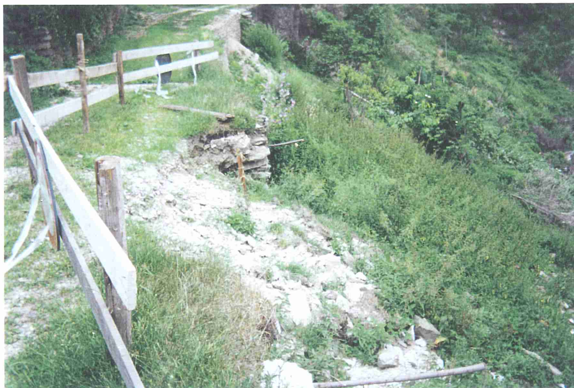
Foto 13f - Torrente Pellice – Villar Pellice. Lungo la SP 258 al km 3 + 250, tra Frazione Bodeina e Frazione Comba, piccole riattivazioni sulla superficie di una frana già presente.
