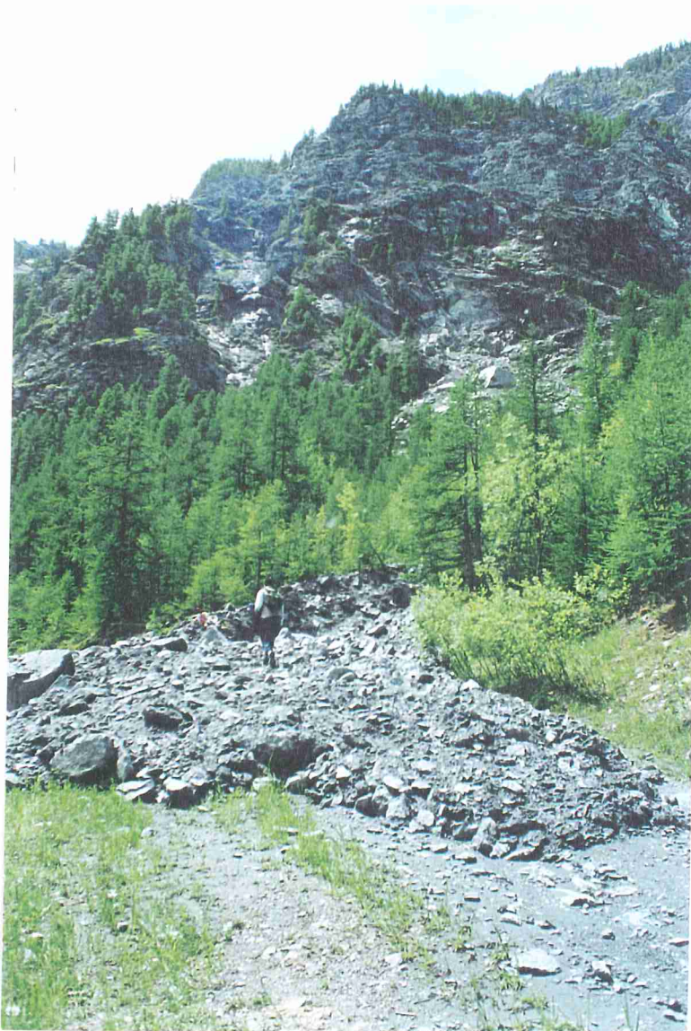
Foto 28c - Torrente Ripa - Comune di Sauze di Cesana – Val Argentera Immediatamente a monte della briglia selettiva, una colata detritica torrentizia ha ostruito la strada ex militare, trasportando blocchi anche di \Phi maggiore di 1,0 m.
