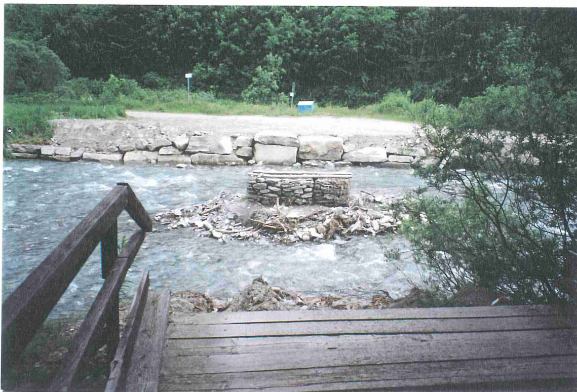
Foto 17d - Torrente Germanasca - Comune di Praly – Località Cugno A monte dell'area pic-nic (in sinistra alveo) esisteva un ponte in legno che è stato danneggiato e il cui impalcato è stato tirato a secco sulle sponde.
