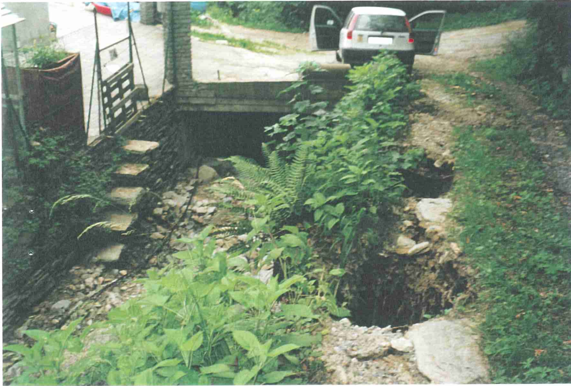
Foto 16e - Torrente Luserna– Comune di Lucerna S. Giovanni. Al limite occidentale della frazione Fenoglia, il rio minore confluyente del T. Luserna ha causato un'erosione in sponda destra in corrispondenza delle case.
