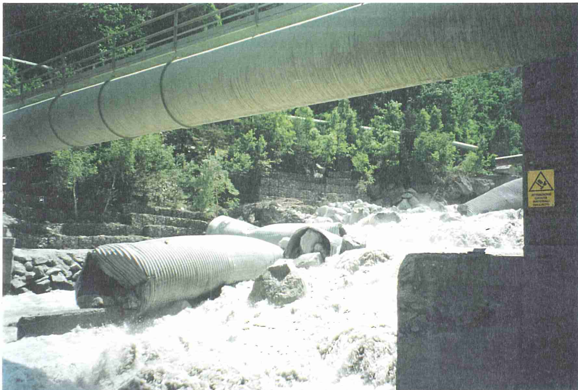
Foto 16b - Fiume Dora Riparia - Comune di Salbertrand – Località Serre La Voute Gli effetti della piena della Dora nel cantiere della Comunità Montana Alta Val Susa in corrispondenza della condotta forzata AEM presso località Sapè: Finsider trascinati in alveo a valle del cantiere; al centro della foto è visibile un breve tratto (circa 4 m) in destra idrografica di gabbionate distrutte.
