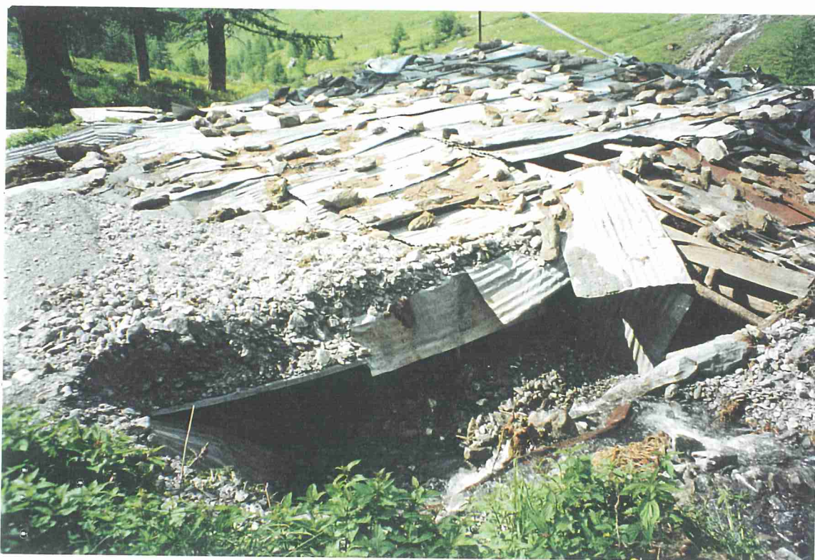
Foto 8b - Torrente Thuras - Comune di Cesana T.se – Località Berengie Caserme riattate per uso agricolo presso ponte Ciatagnera.
