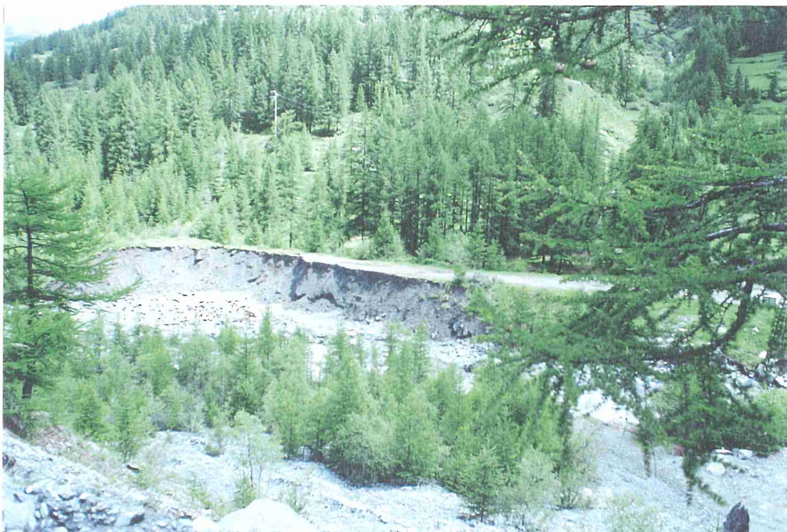
Foto 19c - Torrente Ripa - Comune di Sauze di Cesana- Val Argentera Erosione in sponda destra (tratto lungo circa 50 m) a valle del Ponte Terribile.
