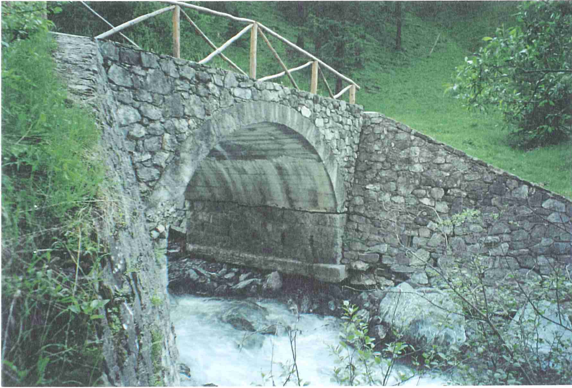
Foto 10b - Torrente Thuras - Comune di Cesana T.se – Località Argano Ai piedi di Cima Alberon (quota 1740 m) spalla sinistra del ponte vista da valle; sottoescavazione e lesione della spalla e del muro d'ala della stessa.
