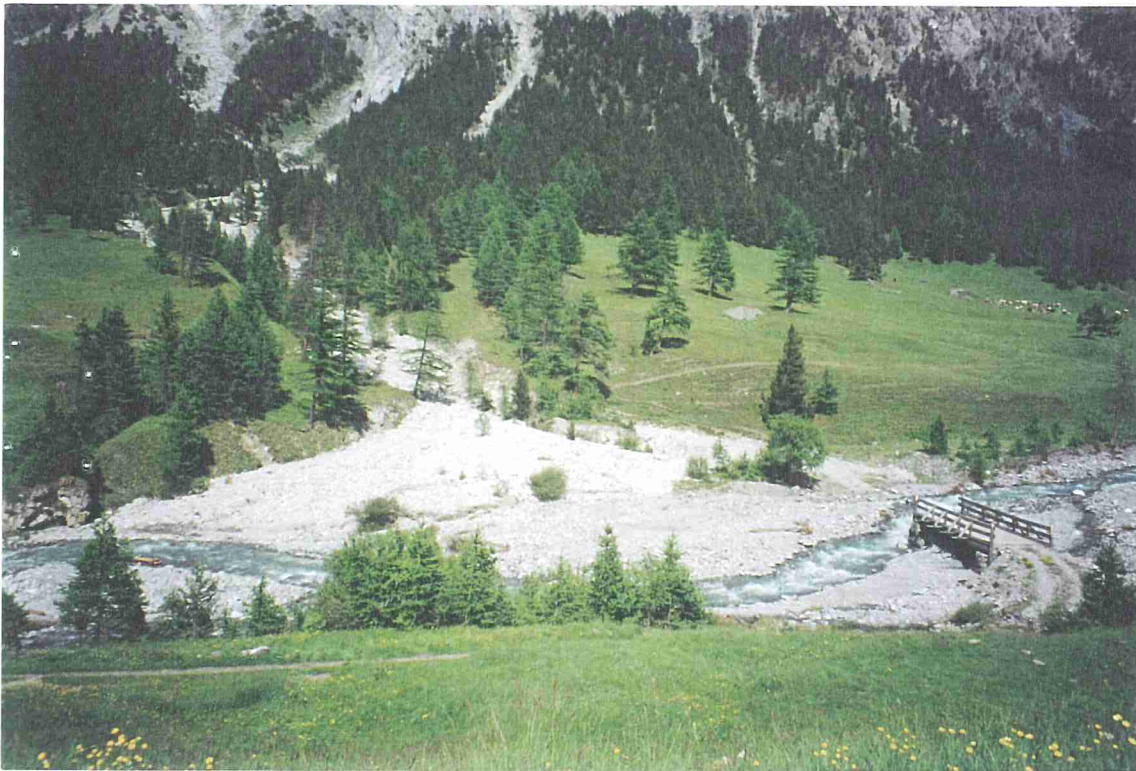
Foto 25a - Torrente Thuras - Comune di Cesana T.se – Località Thuras Il ponte nuovo a monte di Thuras è stato realizzato ai piedi di un conoide attivo (di un affluente di destra), la cui unghia è, attualmente, delimitata dalle acque del Torrente Thuras.
