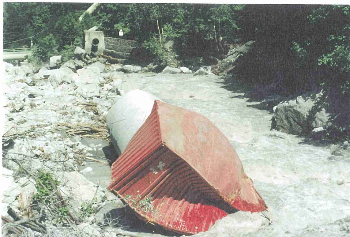
Foto 18b - Fiume Dora Riparia - Comune di Salbertrand – Località Serre La Voute Gli effetti della piena della Dora nel cantiere della Comunità Montana Alta Val Susa a monte della condotta forzata AEM presso località Sapè, Finsider e container trascinati in alveo a valle del cantiere; nella parte alta della foto sono visibili due brevi tratti (circa 4 m ognuno) di gabbionate distrutte, ubicate in destra idrografica.
