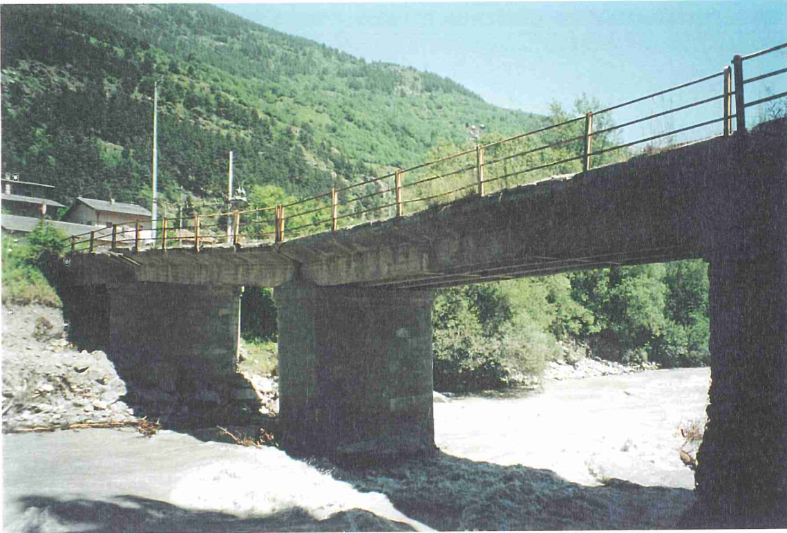
Foto 14b - Fiume Dora Riparia - Comune di Salbertrand - Concentrico Ponte Martinetto Vecchio, cedimento di circa 0,6 m della pila centrale (scalzata e ruotata) e deposito in sponda sinistra. A monte della pila centrale accumulo di legname.
