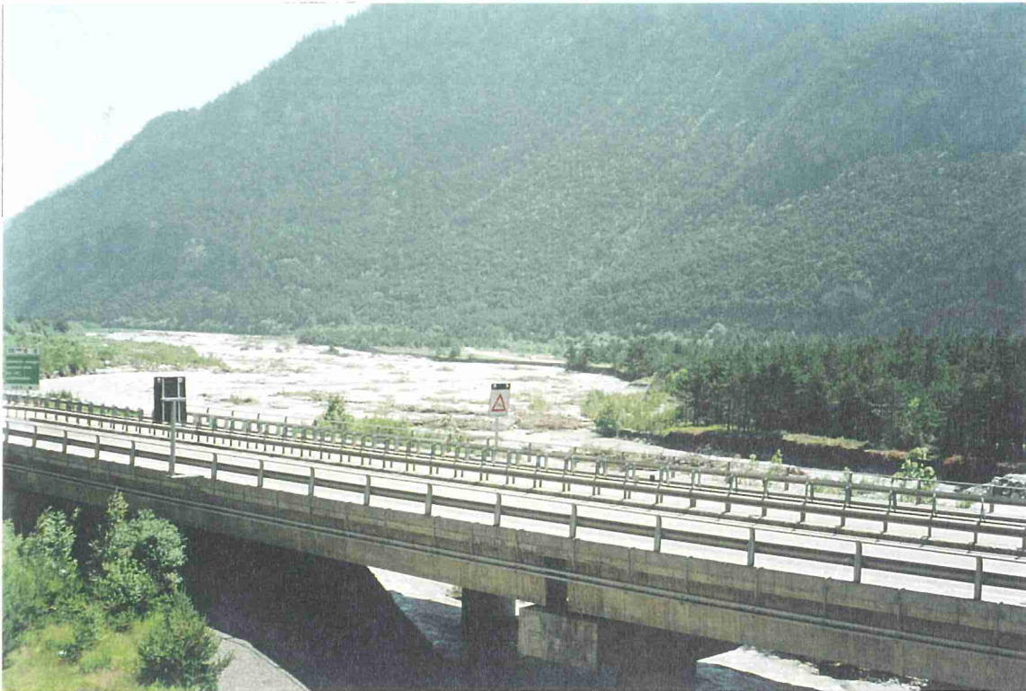
Foto 11b - Fiume Dora Riparia - Comune di Oulx – Località Pont Ventoux Presso il confine con il Comune di Salbertrand: in primo piano il ponte autostradale, in secondo piano l'alveo della Dora a valle del ponte di grande ampiezza e con le evidenze di un cospicuo trasporto solido. In destra idrografica evidenza di erosione di sponda per un tratto lungo circa 60 m.
