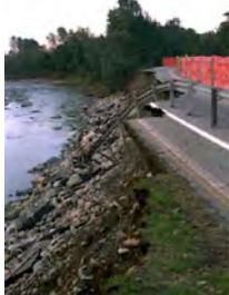
*Stura di Lanzo. Asportazione della sede stradale della S.P. a causa dell'accentuata erosione in sponda destra*
