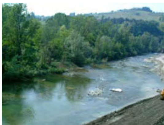
Località Geirino. Vista del torrente Stura a valle del ponte S. Paolo; visibili alcune erosioni di sponda
