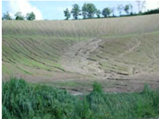
Strada provinciale n. 38 nei pressi della Cascina. Nuova. Frana per mobilitazione della copertura superficiale
