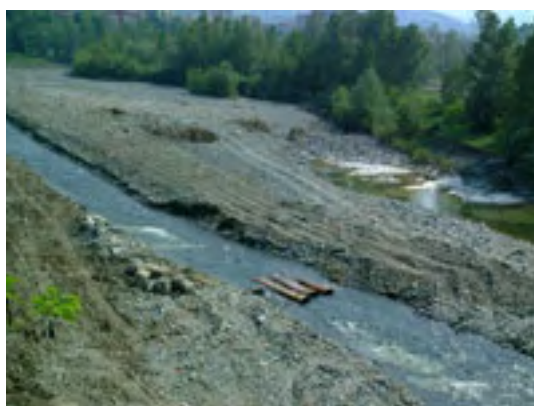
Località Geirino. Vista del torrente Stura a monte del ponte S. Paolo; visibili alcune erosioni di sponda e la messa a nudo delle marne provocata dall'erosione di fondo
