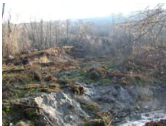
Unghia del movimento franoso (colamento lento) in località ex discarica RSU Piantini. Il materiale franato invade l'alveo del torrente Tiasca e alimenta il trasporto solido del corso d'acqua. (foto Luigi Andrea Bedoni, novembre 2002)
