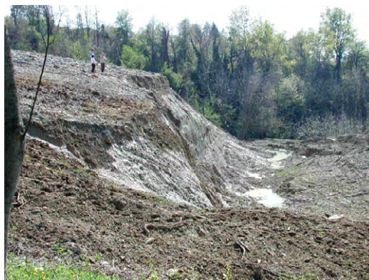
Località Barili - Vista laterale della scarpata di frana
