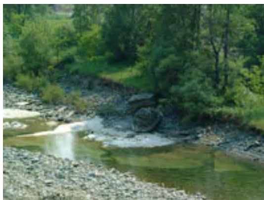
Località Girino – Particolare del torrente Stura a monte del ponte S. Paolo; visibile la messa a nudo delle marne provocata dall'erosione di fondo
