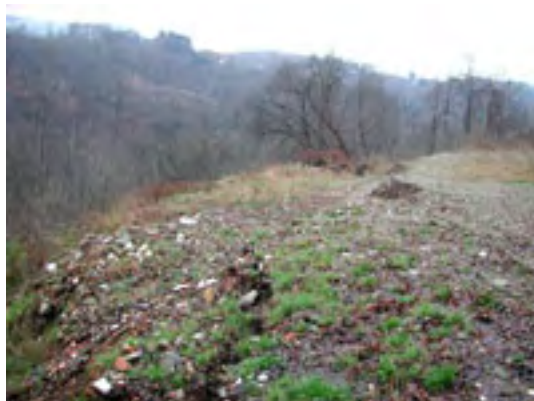
Ex discarica di RSU in località Piantini - Coronamento del movimento franoso attivo che coinvolge lo scarico su pendio. (foto Luigi Andrea Bedoni novembre 2002)
