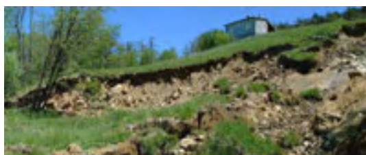
Capanne di Marcarolo - Colata della coltre detritica superficiale: vista da valle; visibile anche l'ex scuola
