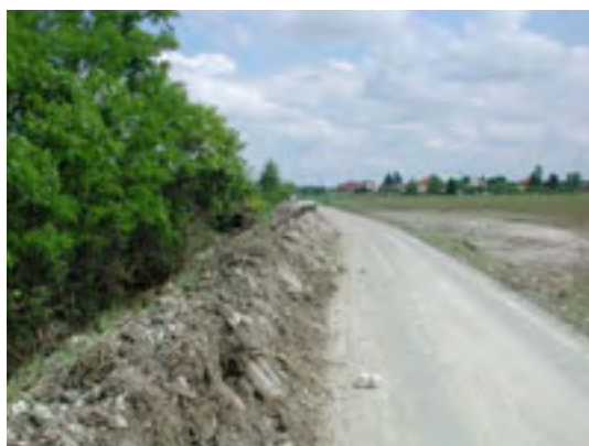
Torrente Gattola - Strada comunale Bassotti. Intervento di arginatura provvisoria a protezione della strada
