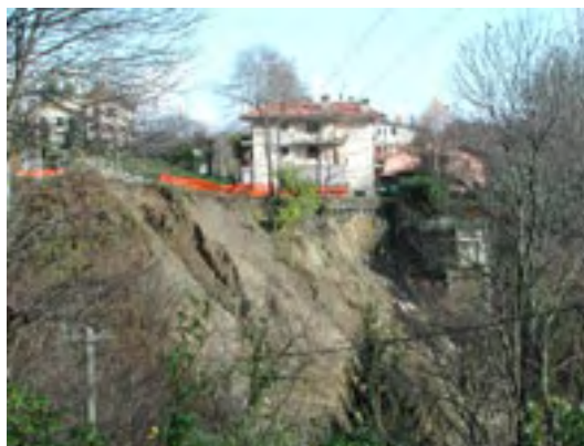
Movimento franoso sulla sponda sinistra del torrente Erno minaccia edifici di recente costruzione. (foto Luigi Andrea Bedoni, novembre 2002)
