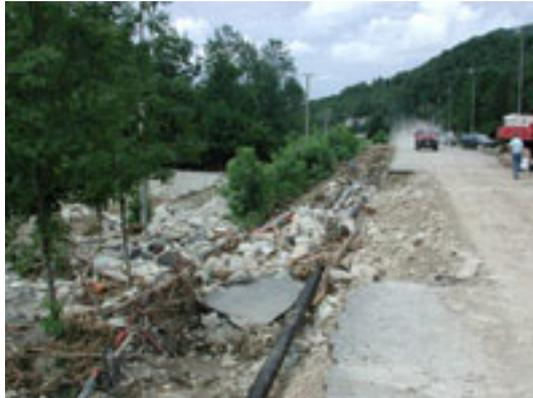
*Le acque di esondazione, in rientro verso l'alveo, hanno reso necessario, in emergenza, creare un varco artificiale attraverso il rilevato stradale*
