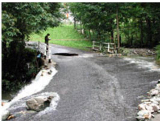
*Località. Monfort – Cedimento del piano viario per erosione torrentizia*
