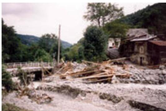
*Valle Colla – Ponte sul torrente Colla sormontato e danneggiato presso Tetto La Tana ([I\\_mz025](#))*
