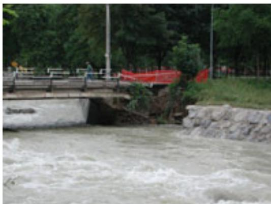
*Erosione all'accesso in sponda sinistra del ponte “superiore” sul torrente Pesio*
