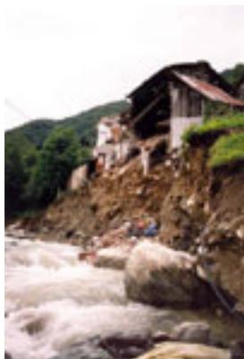
*Valle Colla – Edificio distrutto a causa della migrazione laterale del torrente per ostruzione di un ponte e conseguente erosione della scarpata ([I\\_mz013](#))*
