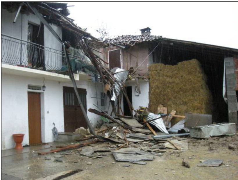
Frana Comune di Revello
