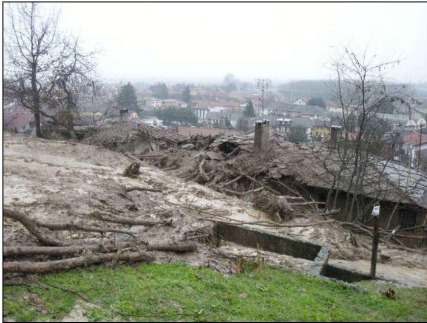
Frana Comune di Revello
