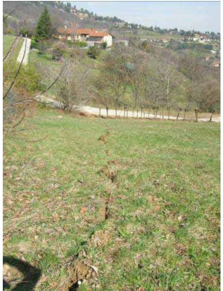
Pecetto Torinese via Ciattalina, a sinistra la strada lesionata, a destra la frattura che segna la spalla sinistra della frana
