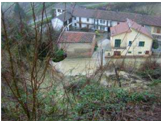
Montaldo Scarampi – Frana su SP in prossimità del cimitero - Edifici interessati dalla frana.
