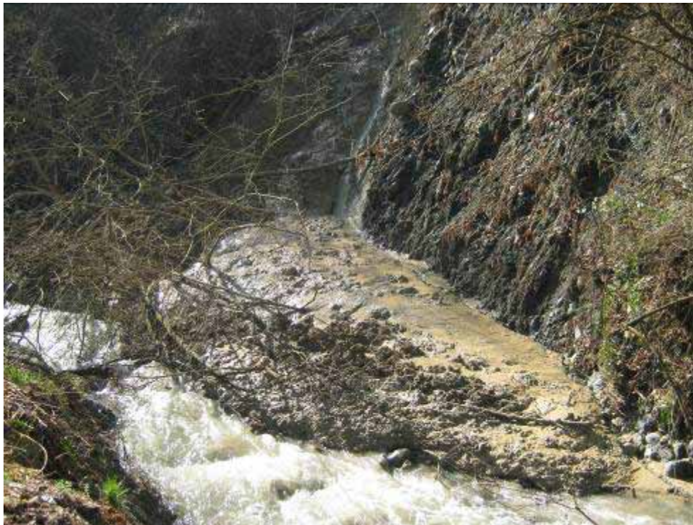
Castiglione T.se, Strada Rivodora 26. Parziale ostruzione del rio Rivodora.
