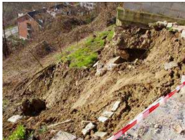
San Raffaele Cimena. Foto a sx: edificio (bianco, in alto) di via Fasella a valle del quale si sviluppato il fenomeno franoso. Foto a dx: coronamento del fenomeno con parziale scalzamento del muro di cinta e del cortile, a valle dell'edificio.
