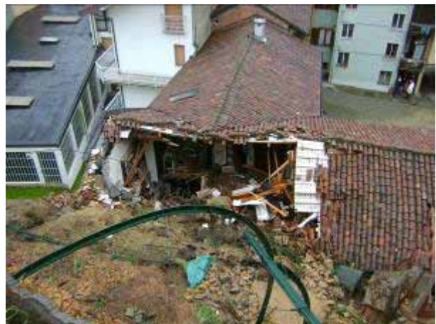
Castelnuovo Don Bosco - crollo del muro storico e danni all'edificio sottostante.
