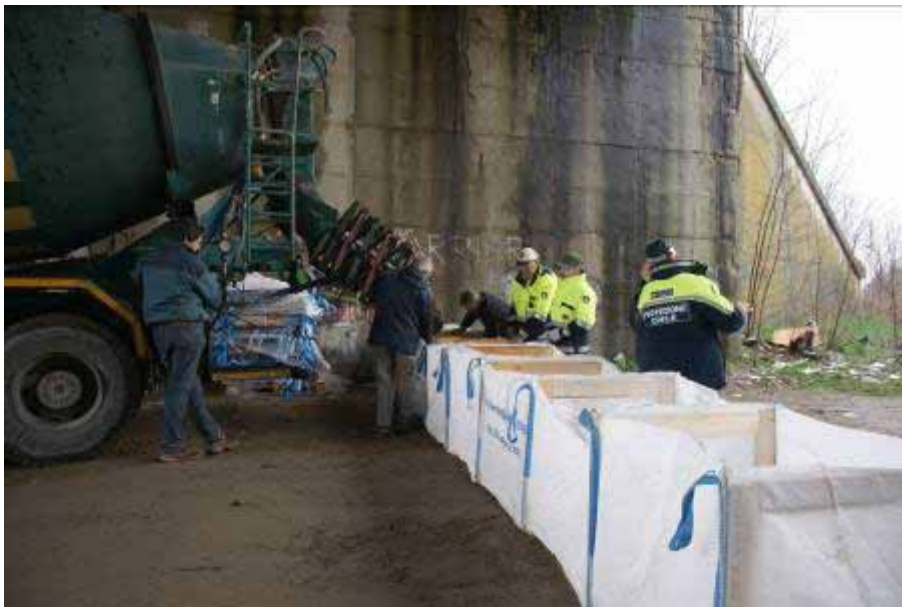
Posa di barriera big-bag a chiusura fornice tangenziale
