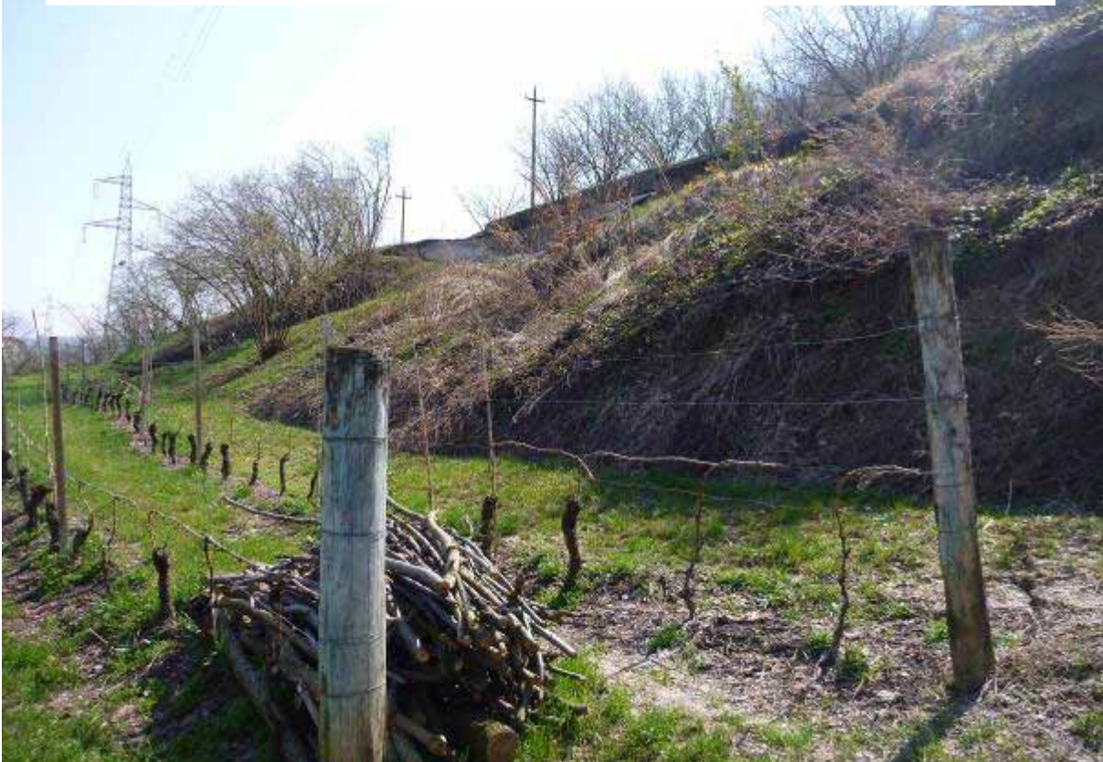
Vista da monte e da valle del tratto di strada comunale franata a causa di un movimento planare di cui al punto 2
