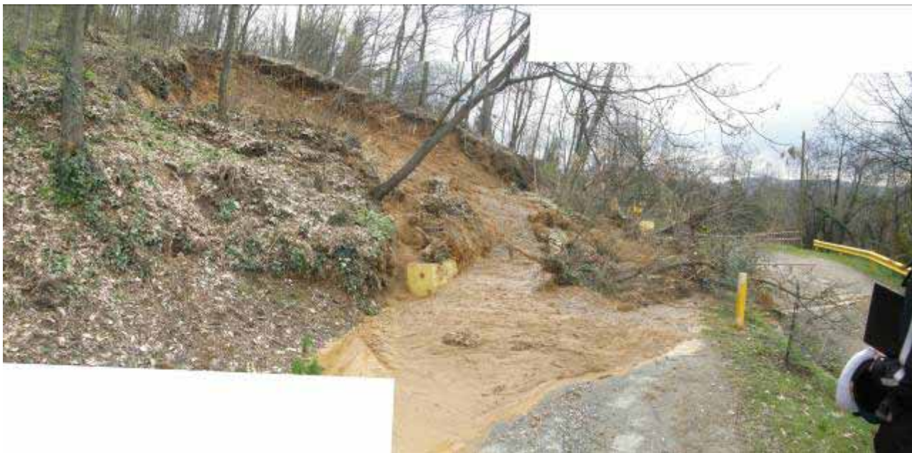
Torino, Città dei Ragazzi, scivolamento rotazionale e strada danneggiata
