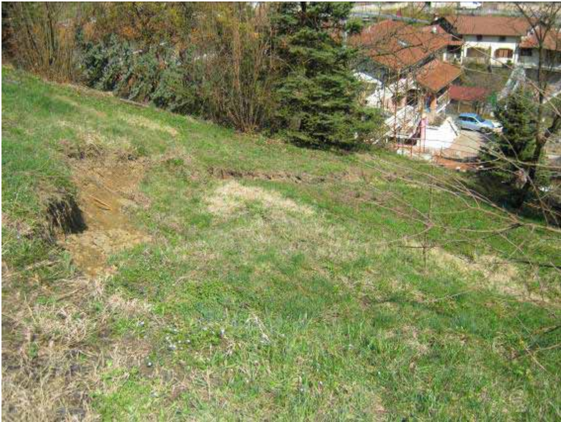
San Sebastiano Po (Borgata Saronella). Fratture lungo il versante e (in alto a dx) edificio di via Viani 5.
