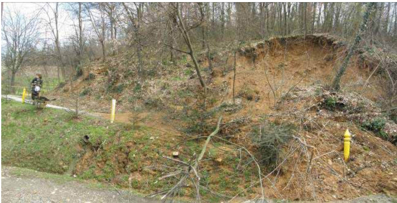
Torino, Città dei Ragazzi, scivolamento rotazionale e strada danneggiata
