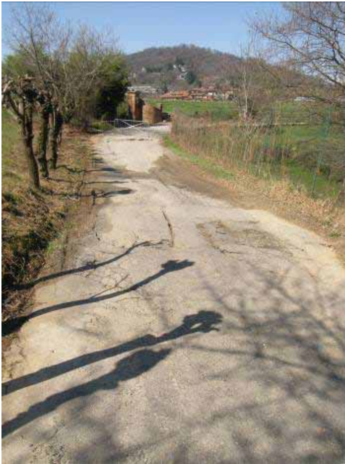
Pecetto Torinese via Ciattalina, a sinistra la strada lesionata, a destra la frattura che segna la spalla sinistra della frana
