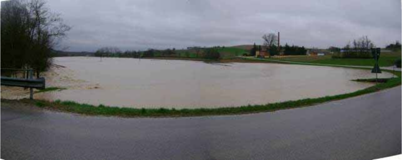
Frinco, Località Molinassi. Allagamenti causati dal Torrente Versa.
