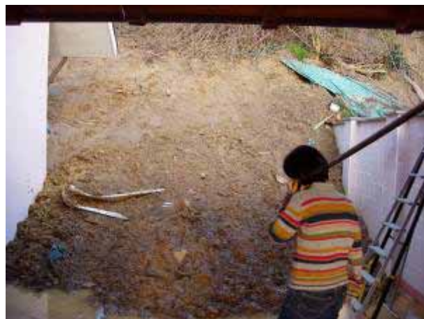
San Raffaele Cimena, edificio di via Chivasso 138 A. Porticato raggiunto dalla colata di fango. Il muro di cinta è completamente coperto dall'accumulo.
