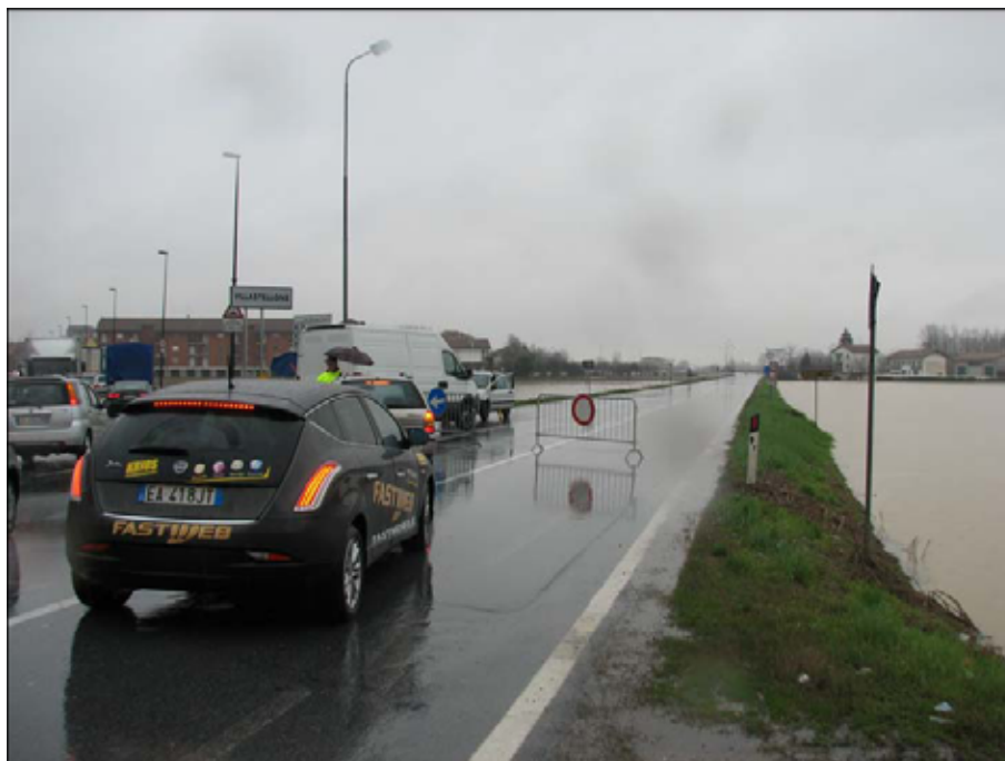
Allagamenti a Villastellone alla confluenza tra Bealera dei Mulini e Rio Stellone con interruzione della viabilità (ex. S.S. 393 di Villastellone, zona impianti sportivi).
