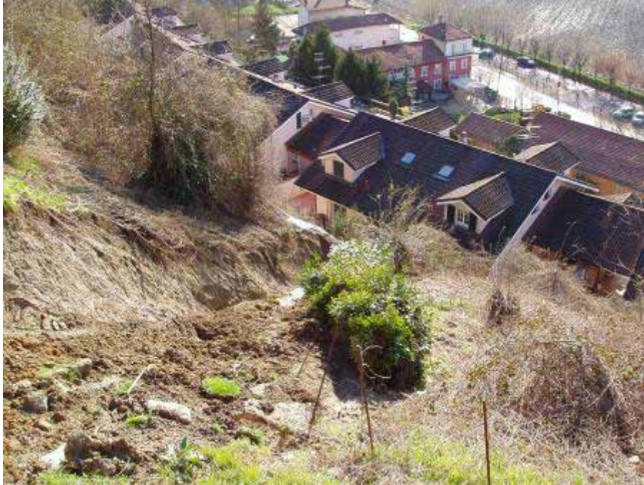
Fenomeno franoso che ha interessato il versante tra via Fasella e Via Chivasso (visto verso valle).
