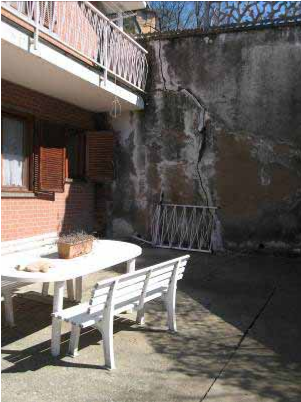
San Raffaele Cimena, via Trotta. A sx: muraglione lesionato a tergo del cortile; a dx: frattura riscontrata sul versante adiacente, a valle della strada provinciale.
