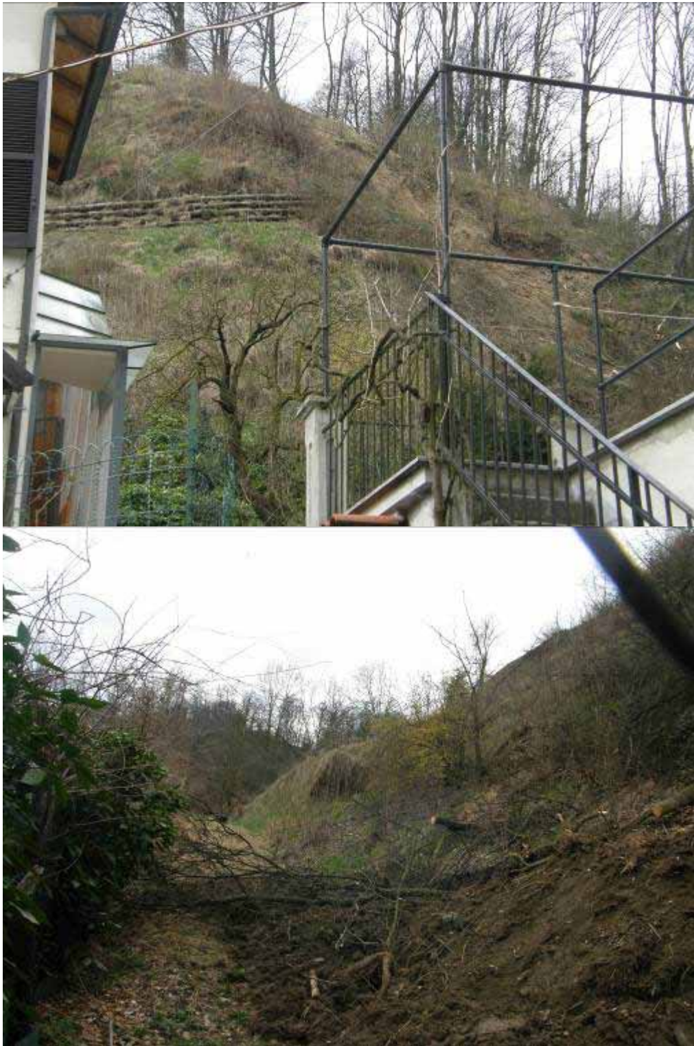
In alto: a sinistra gli interventi di sistemazione del 2008 (?); a destra il coronamento e la traccia della frana . In basso: banchettone in terra armata (?) a difesa delle abitazioni.
