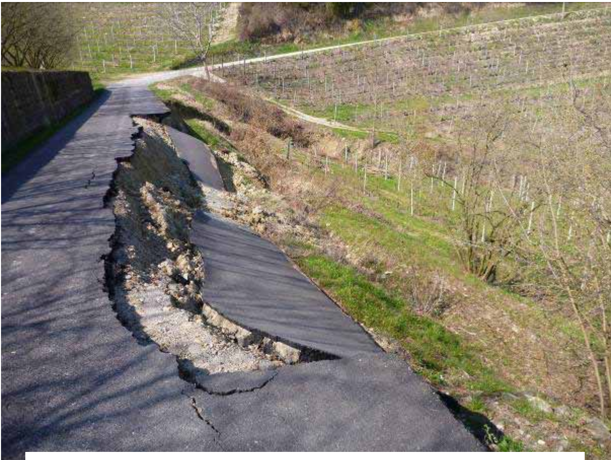
Vista da monte e da valle del tratto di strada comunale franata a causa di un movimento planare di cui al punto 2
