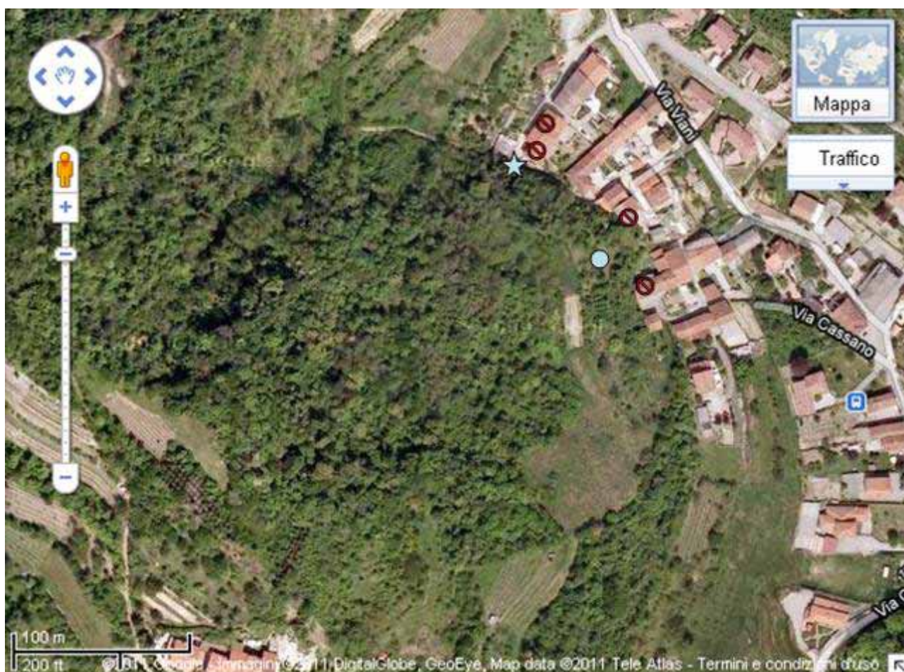
San Sabastiano Po, località Saroncella – Via Viani. Colata detritica (★) e fratture del terreno (○) riscontrate a seguito dell'evento meteo-pluviometrico del 15-16 marzo 2011. Edifici sgomberati (⊘)
