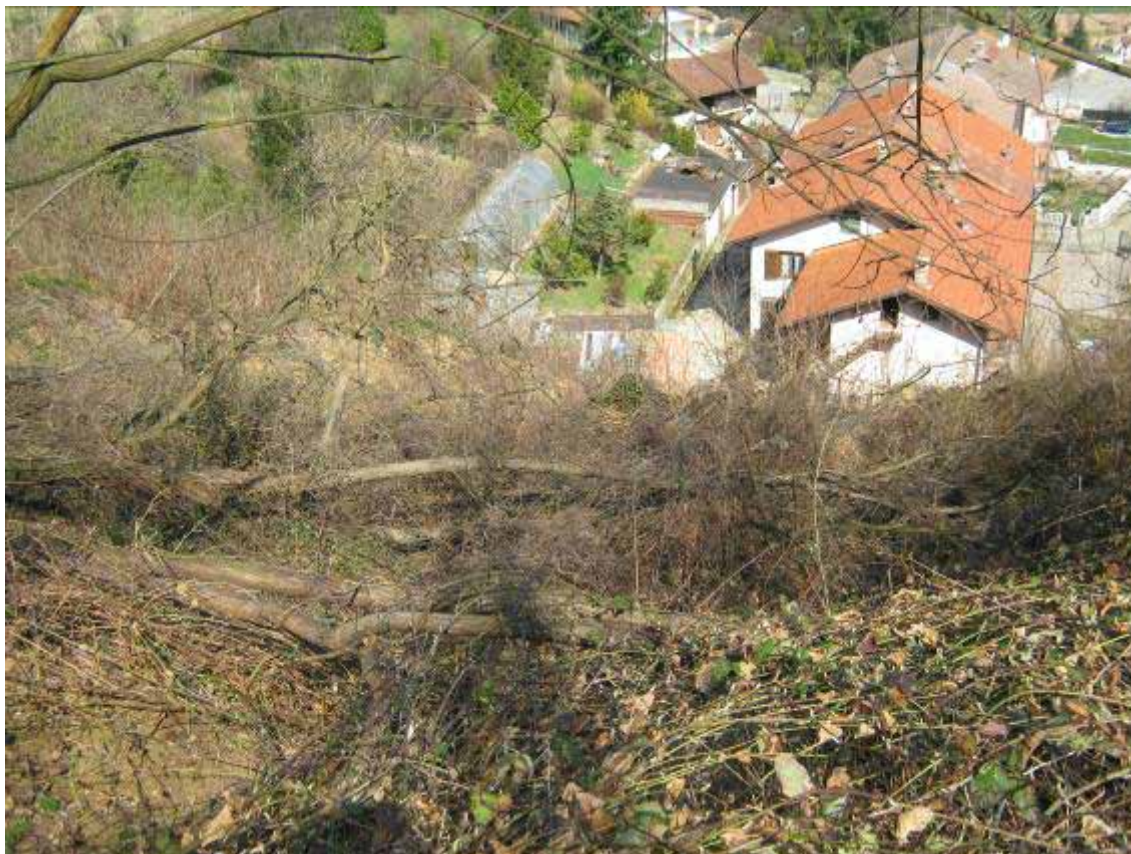
San Sebastiano Po (via Viani 13). Zona di distacco. A valle (in alto a dx), l'edificio parzialmente coinvolto
