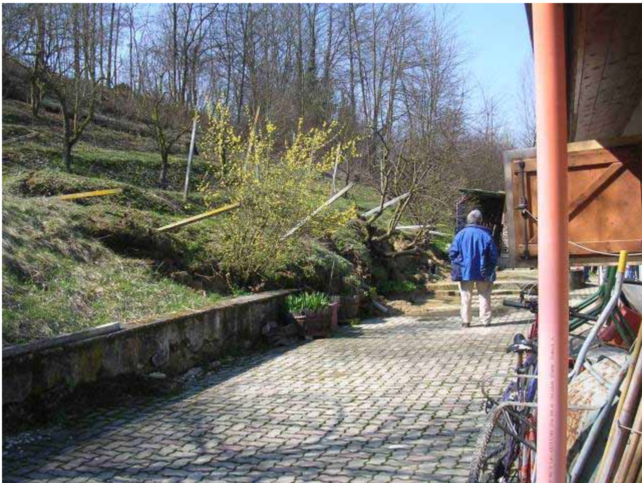
Movimento franoso in località Vallesogno
