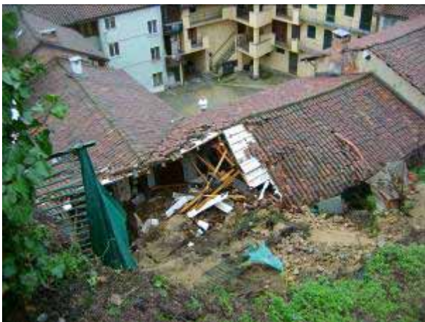
Castelnuovo Don Bosco - crollo del muro storico e danni all'edificio sottostante.
