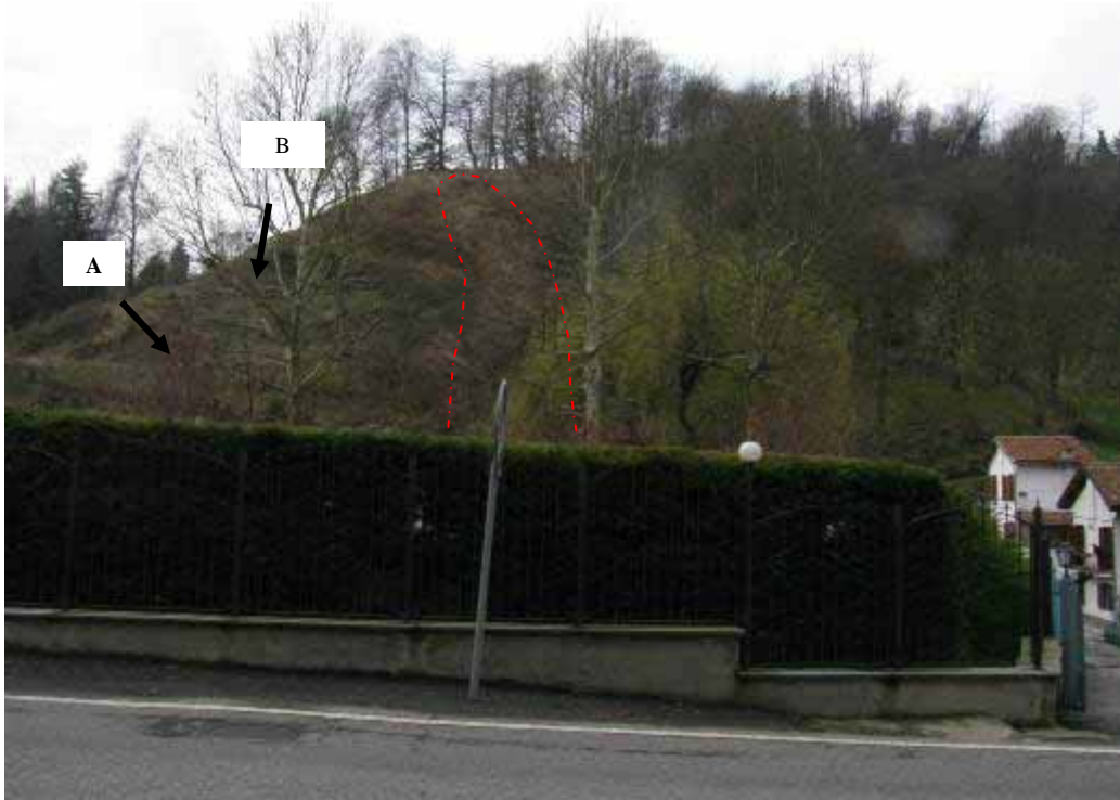
Traccia della frana (linea rossa); a sinistra gli interventi di sistemazione: A, terre armate (?), B, palizzate
