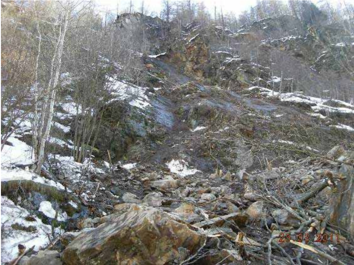
Zona di distacco vista dalla SP
