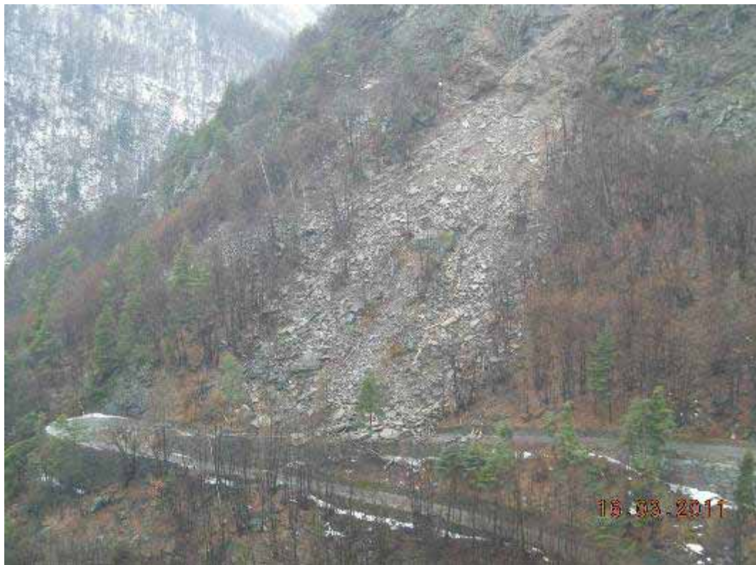
SP 170; fenomeno visto dal versante opposto.
