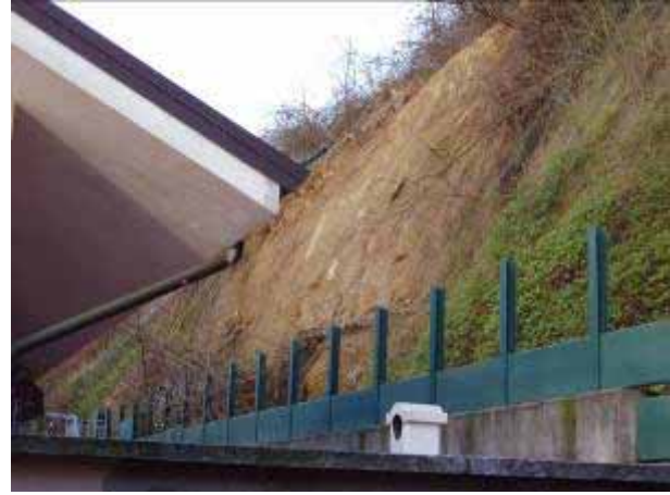
San Raffaele Cimena. Scarpata a tergo delle villette a schiera (edifici con gli abbaini). La superficie denudata (dettaglio nella foto a dx) corrisponde allo sviluppo di un precedente fenomeno franoso (2003).
