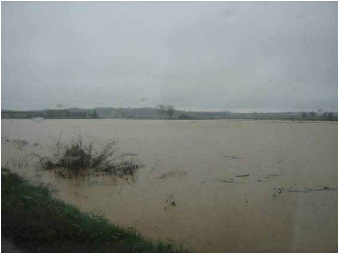
Torrente Rotaldo nei pressi della discarica di Casale.
