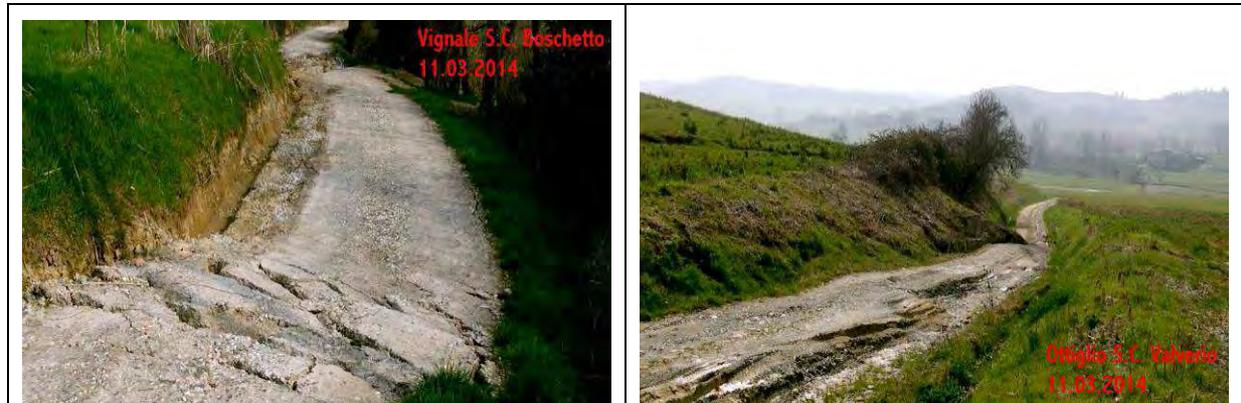
Figura 8 – Vignale, frana lungo s.da Boschetto. A destra, Ottiglio, frana lungo s.da Valverio
