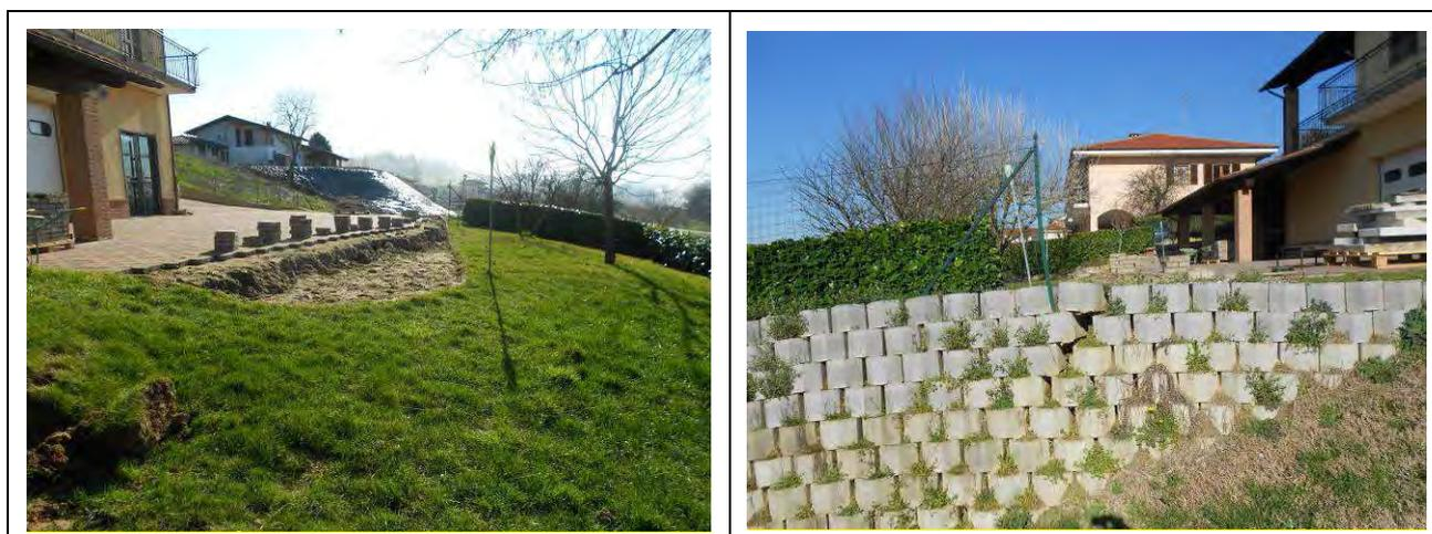
*Figura 20 - Montechiaro d'Asti – frana estesa: nicchia principale lunga oltre 100 m, gradino nelle pertinenze di 3 abitazioni di altezza variabile (10-40 cm). Il primo innesco con un gradino più alto di quello attuale (40-80 cm) è del 27 aprile 2009*
