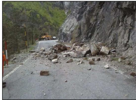
*Figura 15 – SP 154 tra Ormea e Briga Alta (CN). Crolli in roccia dalle pareti di controripa. Nel caso a destra, il crollo ha comportato l'asportazione di alcune reti a contatto.*
