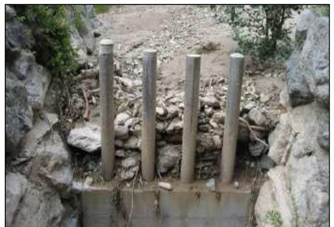
Figura 25 - Exilles, colata di fango e detriti lungo il r. Echalett. Traccia della colata (a sinistra) e la briglia selettiva che ha arrestato i materiali più grossolani.
