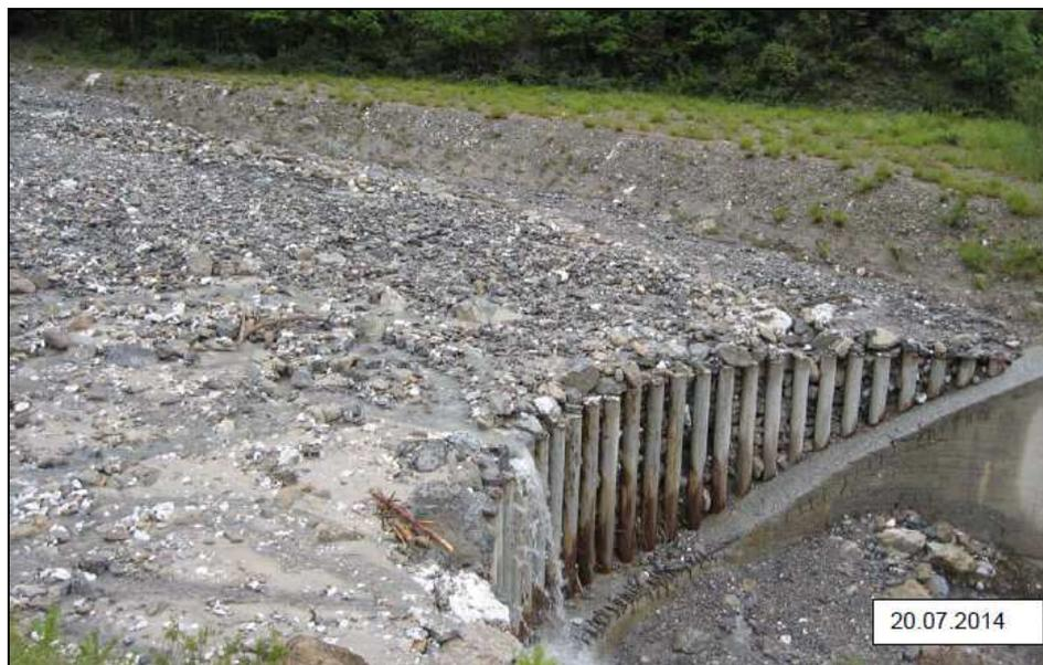
Figura 20 – Bardonecchia, colata di fango e detriti lungo il r. Fosse. Ubicazione del fenomeno (non in scala, da CTR) e vasca di deposito con briglia selettiva, che ha trattenuto i materiali grossolani.
