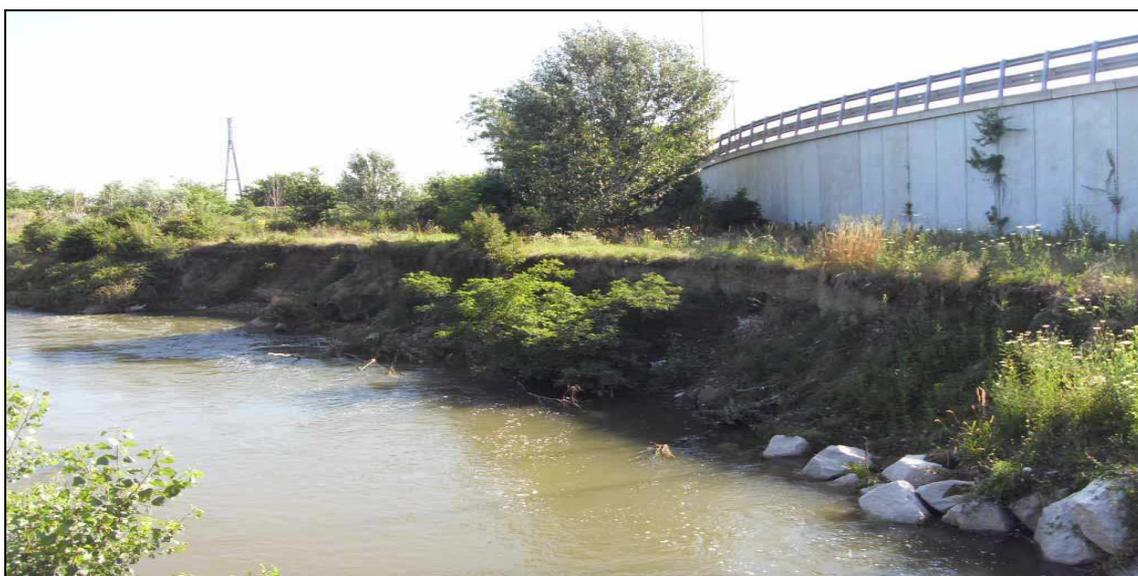
Figura 16- Novara, attività erosiva del T. Terdoppio presso via Panseri.
