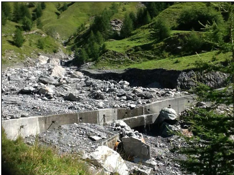
*Figura 19 – Bardonecchia t. Frejus, danni alle opere di difesa idraulica poco a monte del concentrico*
