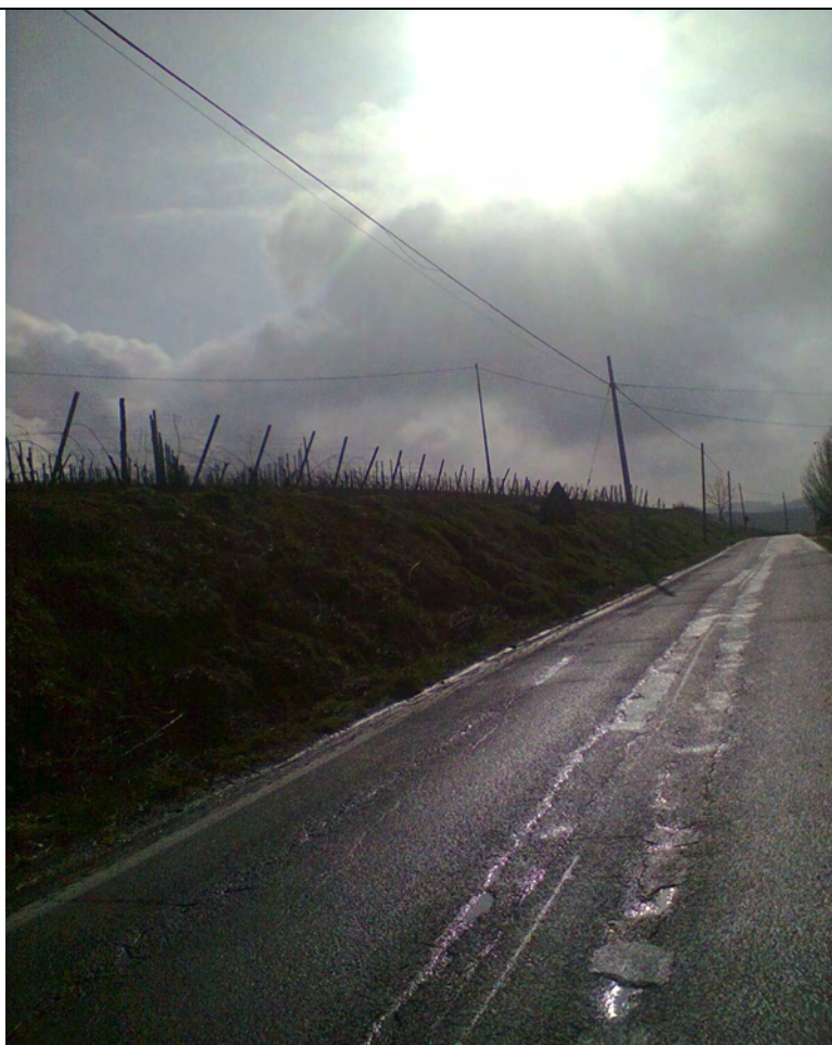
SP 233 “delle Rocche” km 1+3200 sx n° 1
