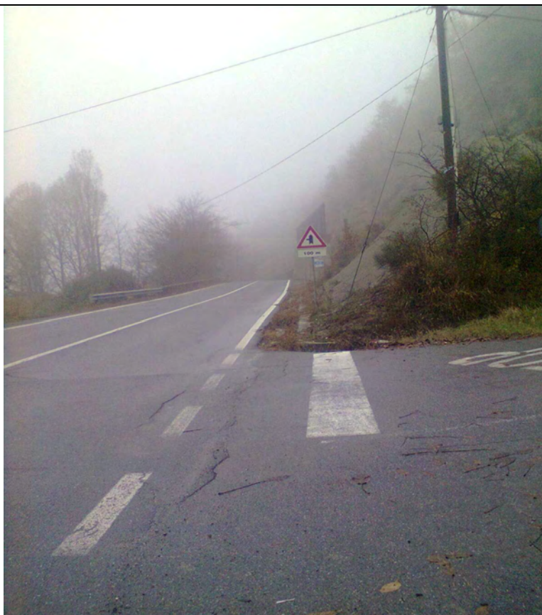
SP 210 “Acqui-Palo” km 6+600 sx n° 1
