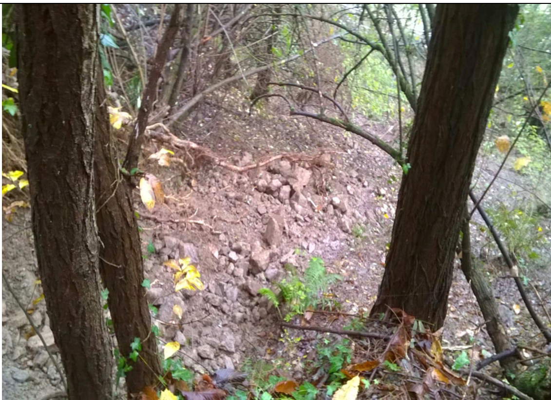
SP 456 d “del Turchino” al km 72+600 al km 72+750 foto n° 2
