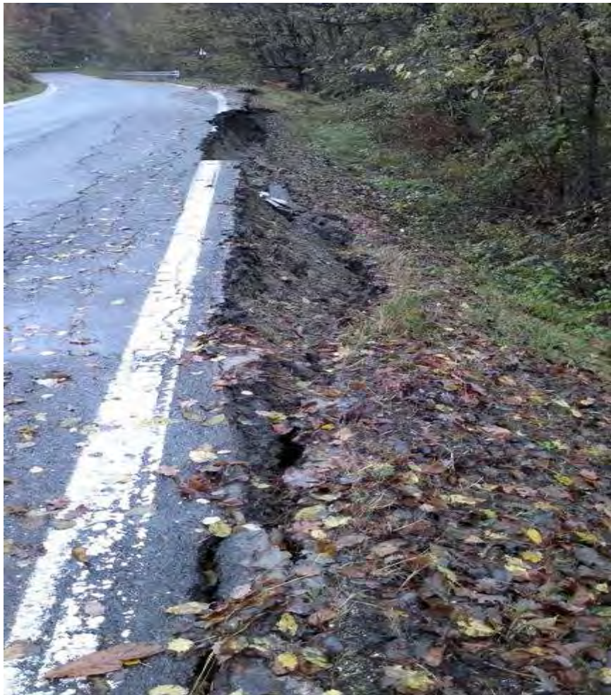
Sp 120”della Val Grue” dal km 21+429 al km 21+600 foto n° 1
