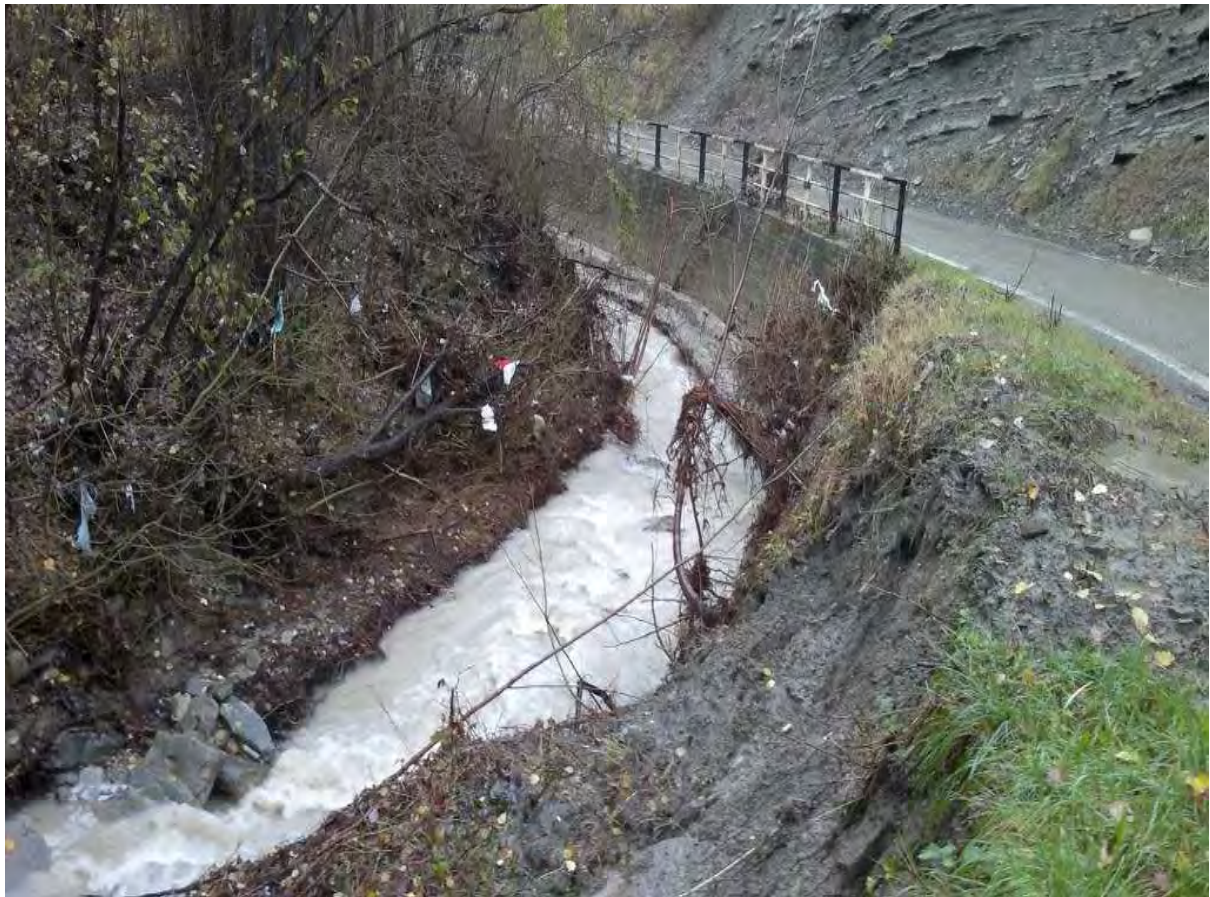
Sp 122 “di Campioli” dal km 2+800 al km 2+850 foto n° 1
