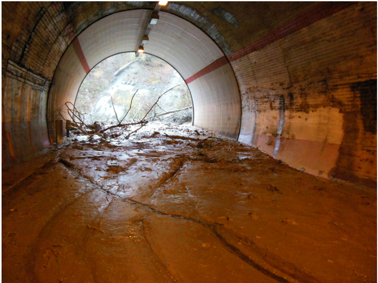
Sp 120 “della Val Grue” dal km20+000 al km 21+200 foto n° 2
