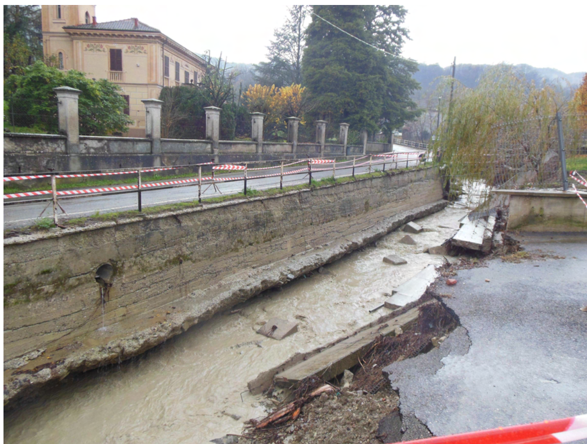
Sp 137 “ Garbagna - Bastita” dal km 0+000 al km 0+500 foto n° 1
