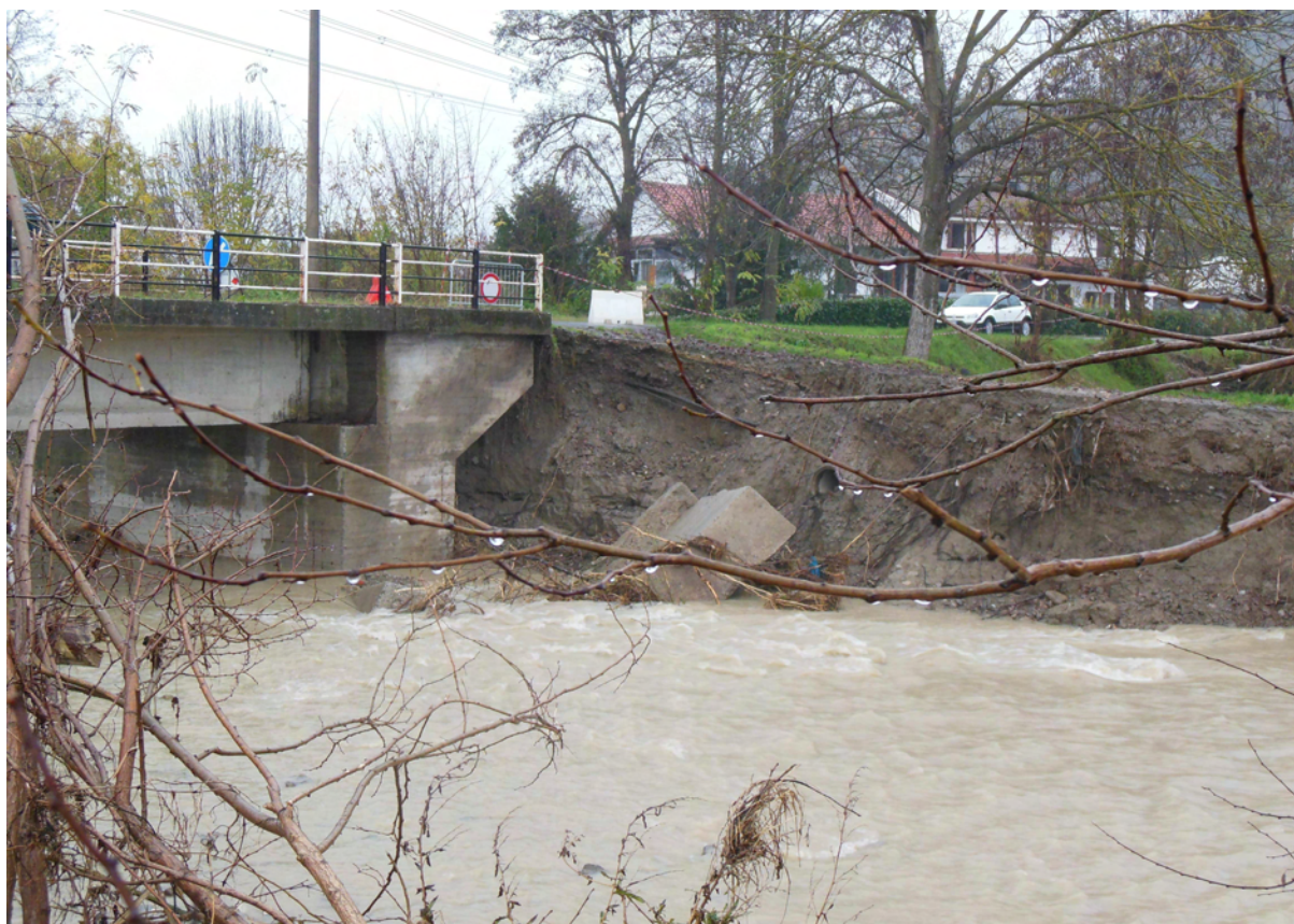
Sp 126 “di Cerreto Grue” dal km 0+150 al km 0+300 foto n° 1
