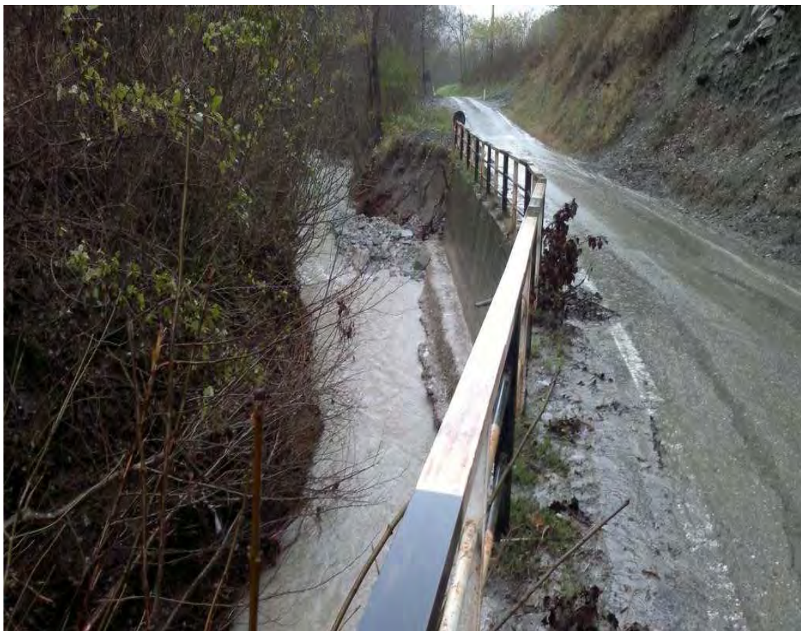
Sp 122 “di Campioli” dal km 2+800 al km 2+850 foto n°2
