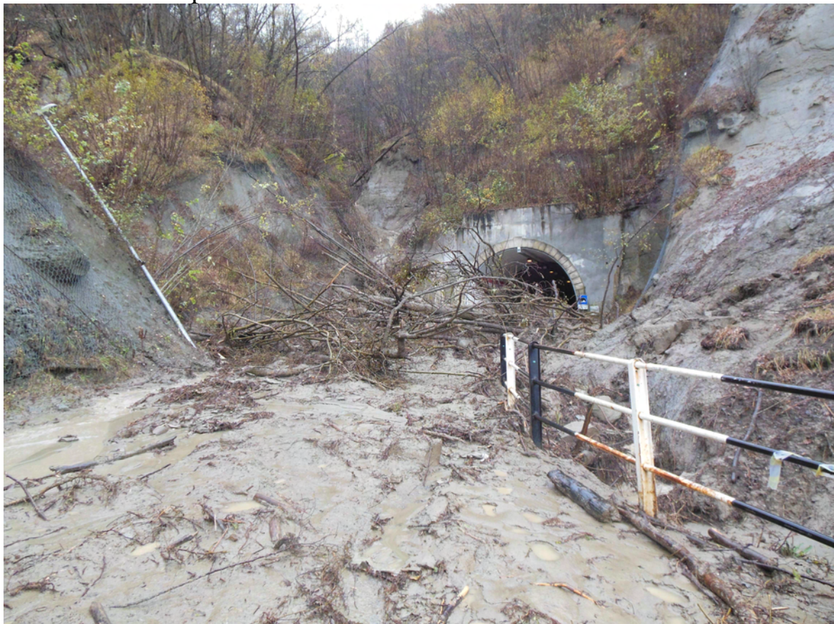
Sp 120 "della Val Grue" dal km20+000 al km 21+200 foto n° 1
