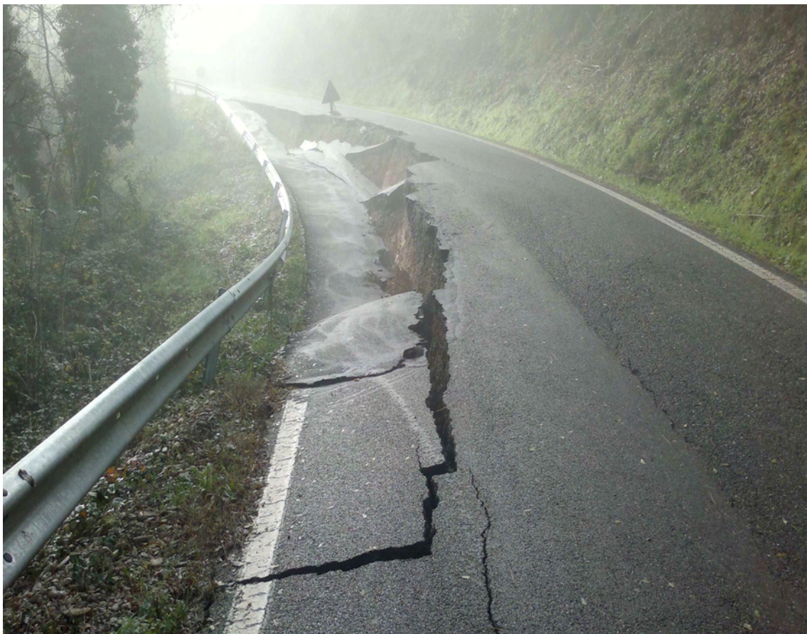
SP 139 "Carezzano -Cassano" km 3+000 n° 2
