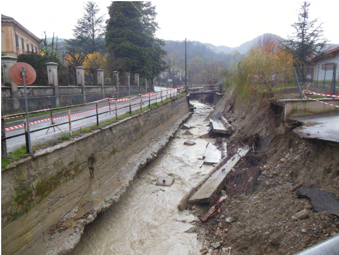
Sp 137 “ Garbagna - Bastita” dal km 0+000 al km 0+500 foto n° 2
