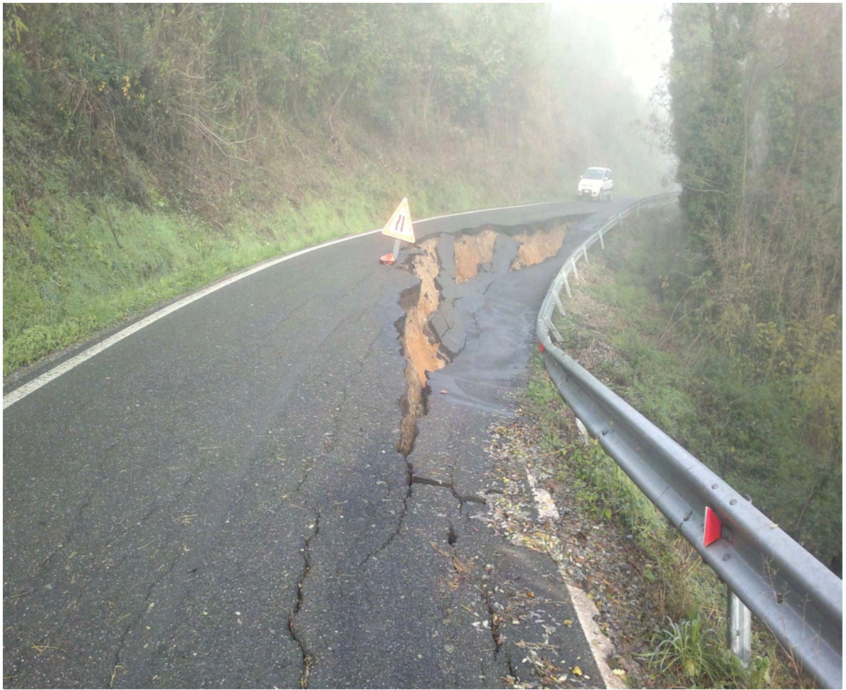
SP 139 "Carezzano -Cassano" km 3+000 n° 3
