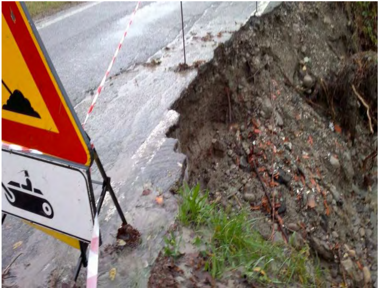
Sp 123 "di Montebere" dal km 0+200 al km 0+900 foto n° 1
