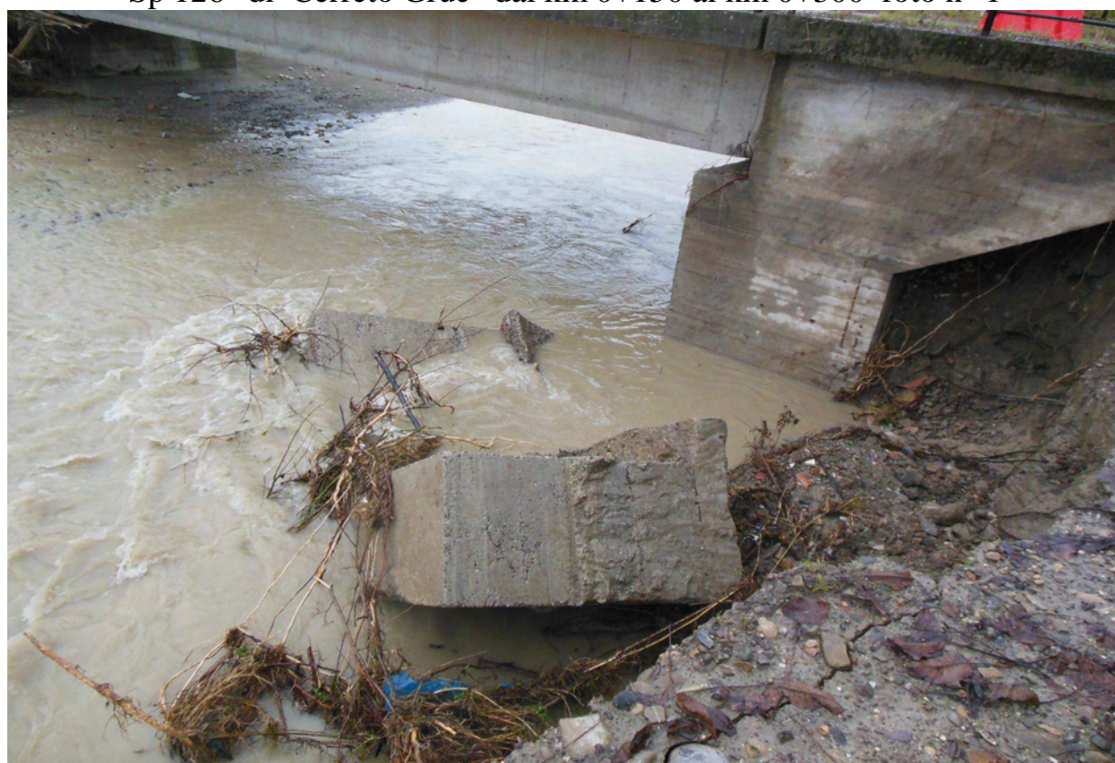
Sp 126 “di Cerreto Grue” dal km 0+150 al km 0+300 foto n°2
