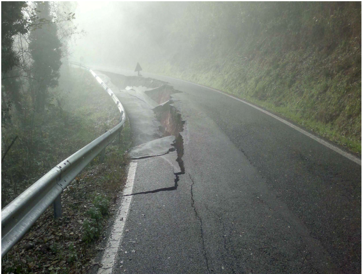
SP 139 "Carezzano -Cassano" km 3+000 n° 1
