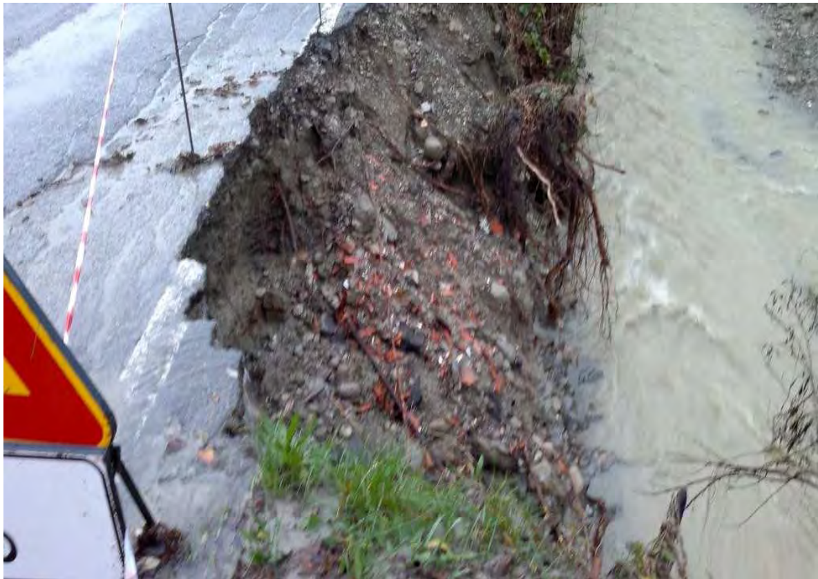
Sp 123 "di Montebore" dal km 0+200 al km 0+900 foto n° 2
