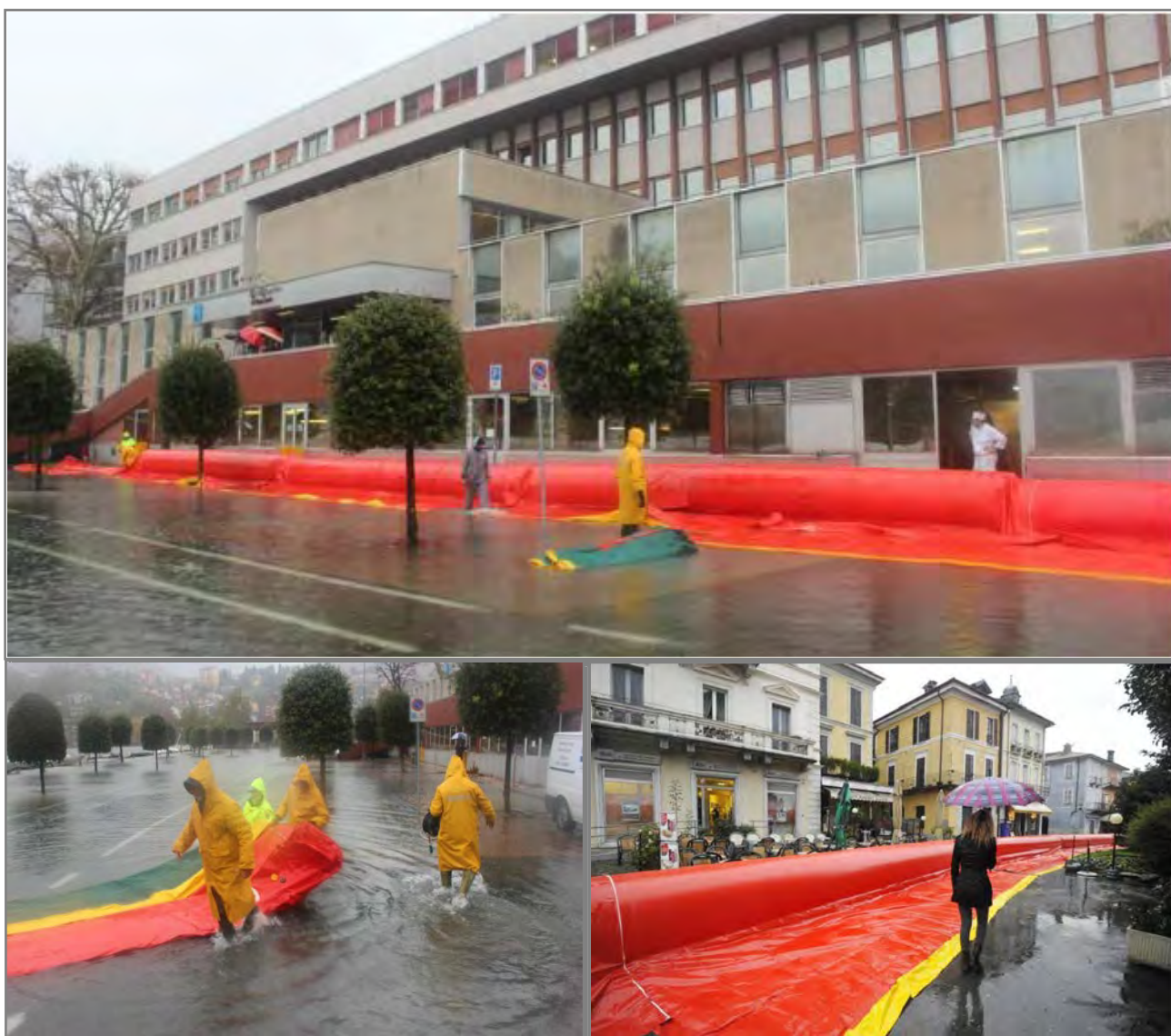
Barriere anti inondazione tipo "NOAO" a Omegna in corrispondenza dell'ospedale (foto in alto ed in basso a sinistra) e a Pallanza (foto in basso a destra). Fonte "la stampa".
