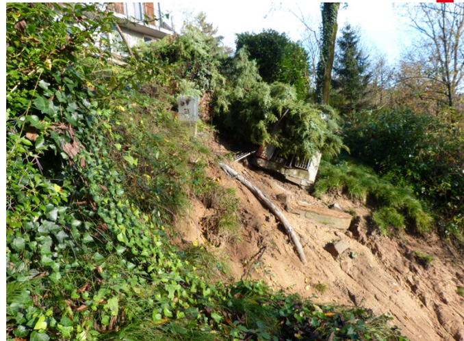
Figura 55 – Ubicazione (non in scala) dell'area coinvolta dal dissesto e vista del colamento
