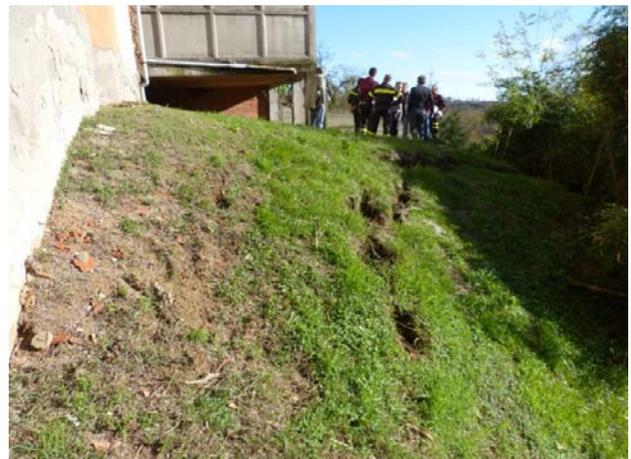
*Figura 34 – Ubicazione (non in scala) delle fratture di trazione (osservabili a destra) che hanno portato all'evacuazione del condominio al civico n°4 e del fenomeno di colamento rapido presso il civico n°6.*
