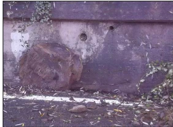
*Figura 9 - Cedimento carreggiata S.P. 139 km 3+000; caduta massi sulla ex S.S. 456 "del Turchino"*
