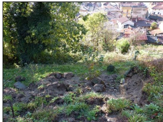
Figura 57 - Ubicazione del dissesto (non in scala) e vista dall'alto del cedimento di un tratto di muro a secco costituito da blocchi che minacciano i sottostanti edifici.
