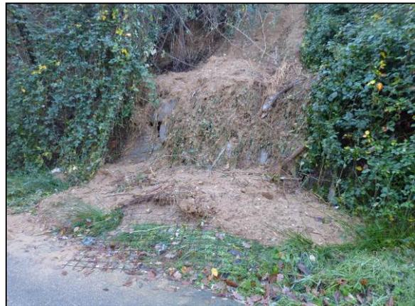
*Figura 60 - Località C.ne Rossi, un colamento detritico fangoso innescato in corrispondenza del ciglio di una scarpata presso cui è ubicata una stalla, ha messo a giorno i plinti dei pilastri del fienile minacciandone la stabilità, e interessando un tratto della sottostante SP, in un punto in cui già nel passato erano stati realizzati interventi di sistemazione (massi di cava nella foto di destra).*
