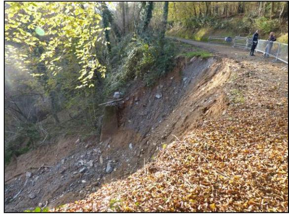
*Figura 42 - Colata di detrito e fango che ha interessato il ciglio della carreggiata stradale determinandone l'interdizione al traffico veicolare. Il materiale coinvolto è costituito da depositi fluvio-glaciali alterati, anche se lungo il fianco destro della frana, come visibile nella foto di destra, sono presenti anche rifiuti.*
