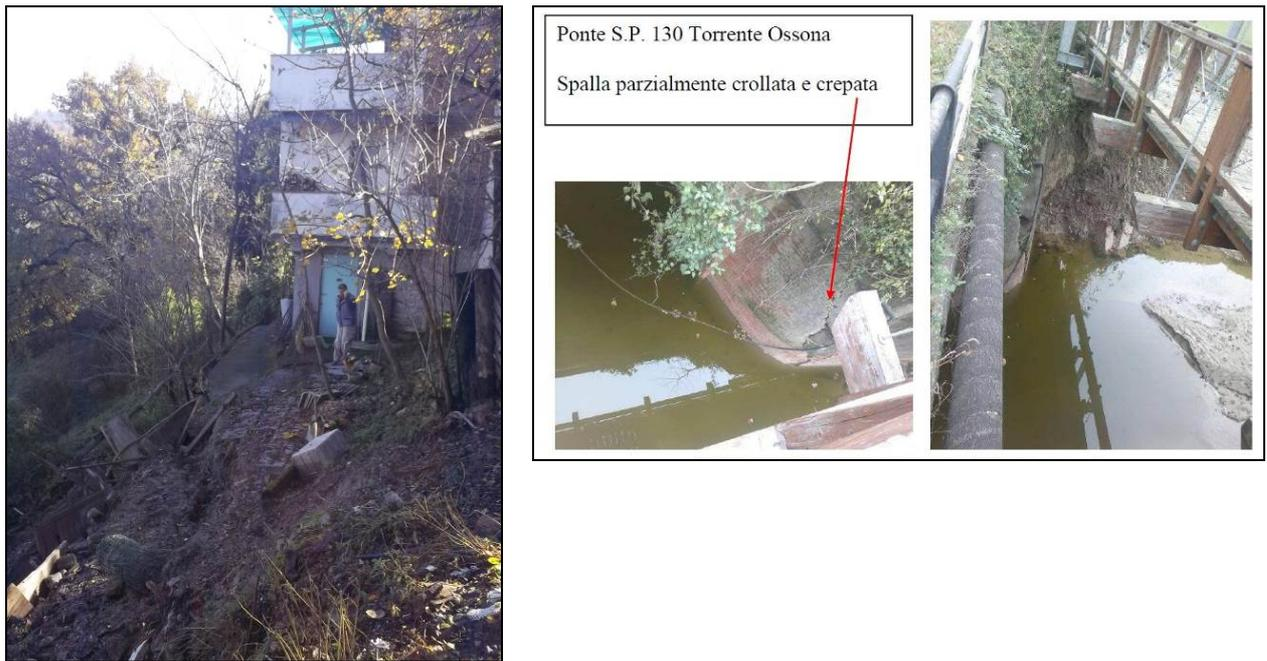
*Figura 17 - Costa Vescovato (AL). Fraz. Sarizzola. Aggravamento frana con edifici sgomberati; danni al ponte della S.P. 130 sul Torrente Ossoa a Costa Vescovato (AL)*
