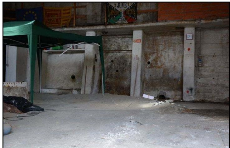
*Figura 62 – Ubicazione (non in scala) degli edifici interessati dal dissesto ed interno dell'edificio sgomberato; il pavimento si è sollevato e i muri portanti sono stati lesionati.*
