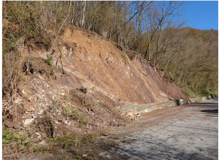
Figura 441 – Ubicazione (non in scala) dell'area coinvolta dal dissesto e vista della nicchia di distacco
