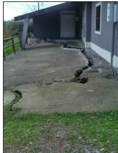
Figura 80– Ubicazione (non in scala) e orlo superiore di movimento rotazionale con edifici dichiarati inagibili in fraz. Crabia superiore
