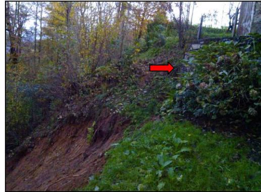
Figura 82 – La frana a valle della Chiesa a settentrione del concentrico di Guardabosone. La nicchia va a interessare la base di un muretto a secco a valle della Chiesa (in lato a destra nella foto)
