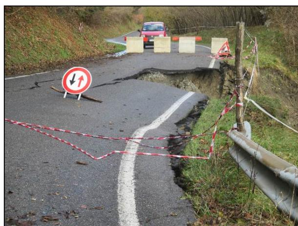
*Figura 11 - Cedimento sede stradale S.P. 168; cedimento sede stradale S.P.160 della Bocchetta*
