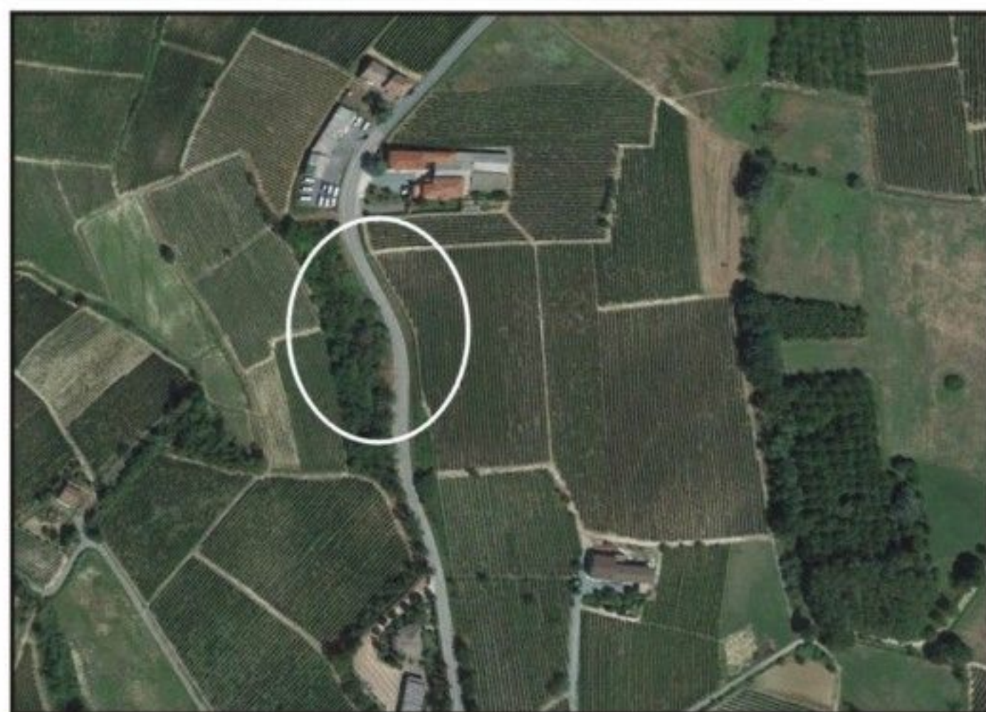
Foto aerea (da Google Earth) con indicazione dell'area dove è avvenuto il movimento franoso
