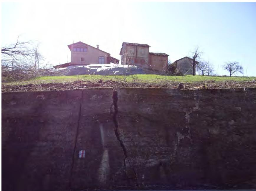
Immagine 02 - 2015\_03\_30-Frattura aperta sul muro di contenimento della scarpata di monte della SP 58
