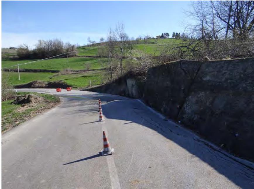
Immagine 01 - 2015\_03\_30-Deformazione della carreggiata della SP 58 e danneggiamento del muro di contenimento
