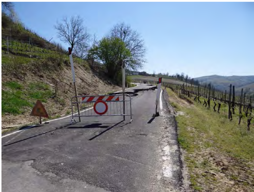
Immagine 05 - 2015/04/08-Strada Provinciale resa intransitabile per effetto del movimento franoso in corrispondenza del fianco sinistro
