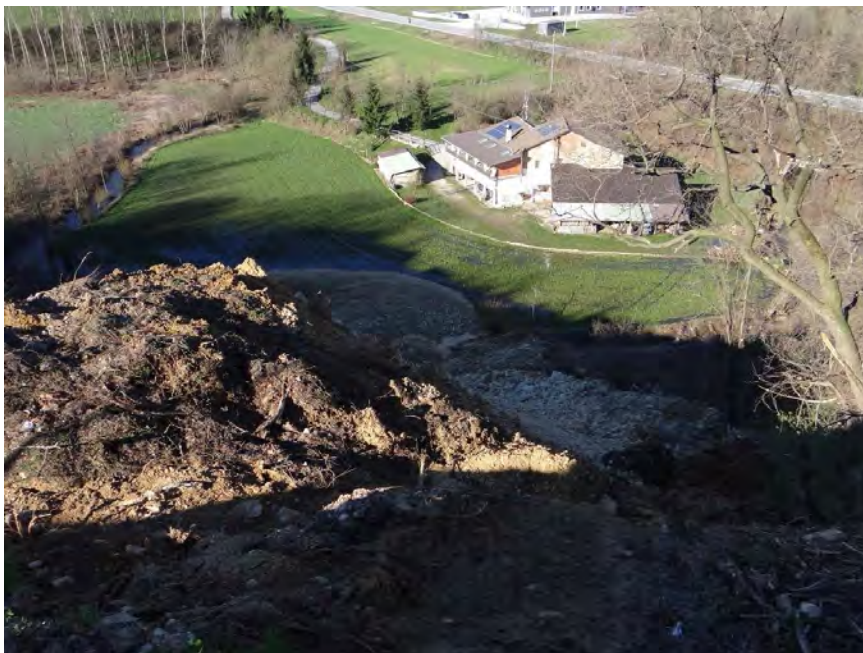
Immagine 04 - 2015/03/31-Accumulo di frana sulla piana sottostante che ha coperto e quindi deviato le acque del corso d'acqua
