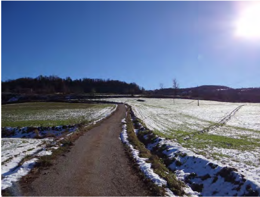
Immagine 05 - 2013/12/04-Fotografia scattata dal piede della frana, nei pressi di C.na Fontana
