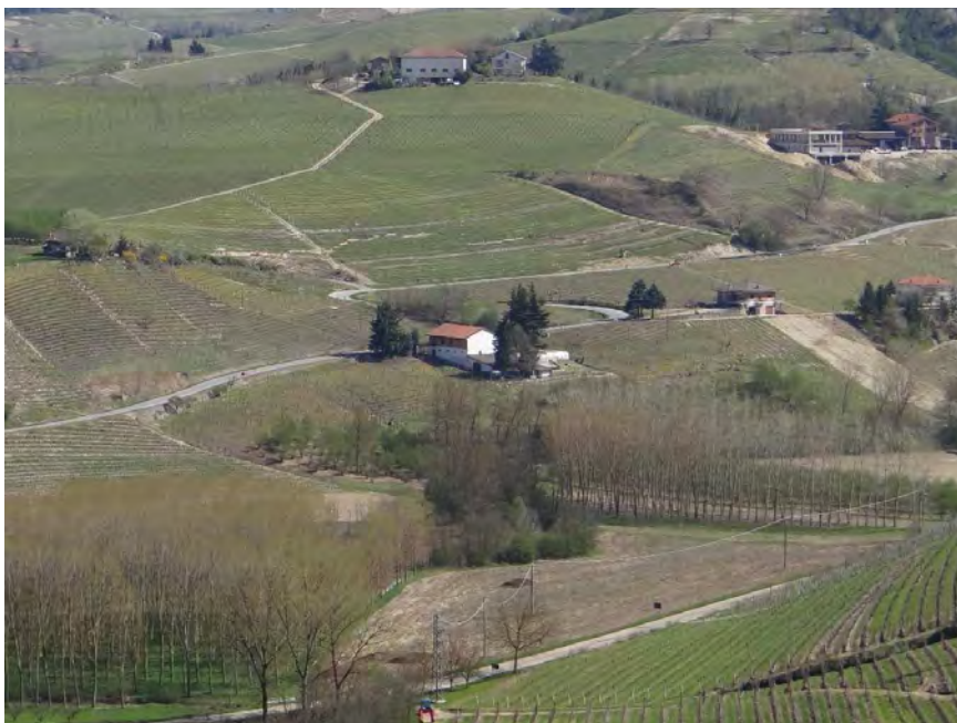
Immagine 01 - 2015/04/08-Panoramica del settore di versante interessato dalla frana; al centro dell'immagine l'abitazione che per effetto del movimento ha subito serie lesioni strutturali
