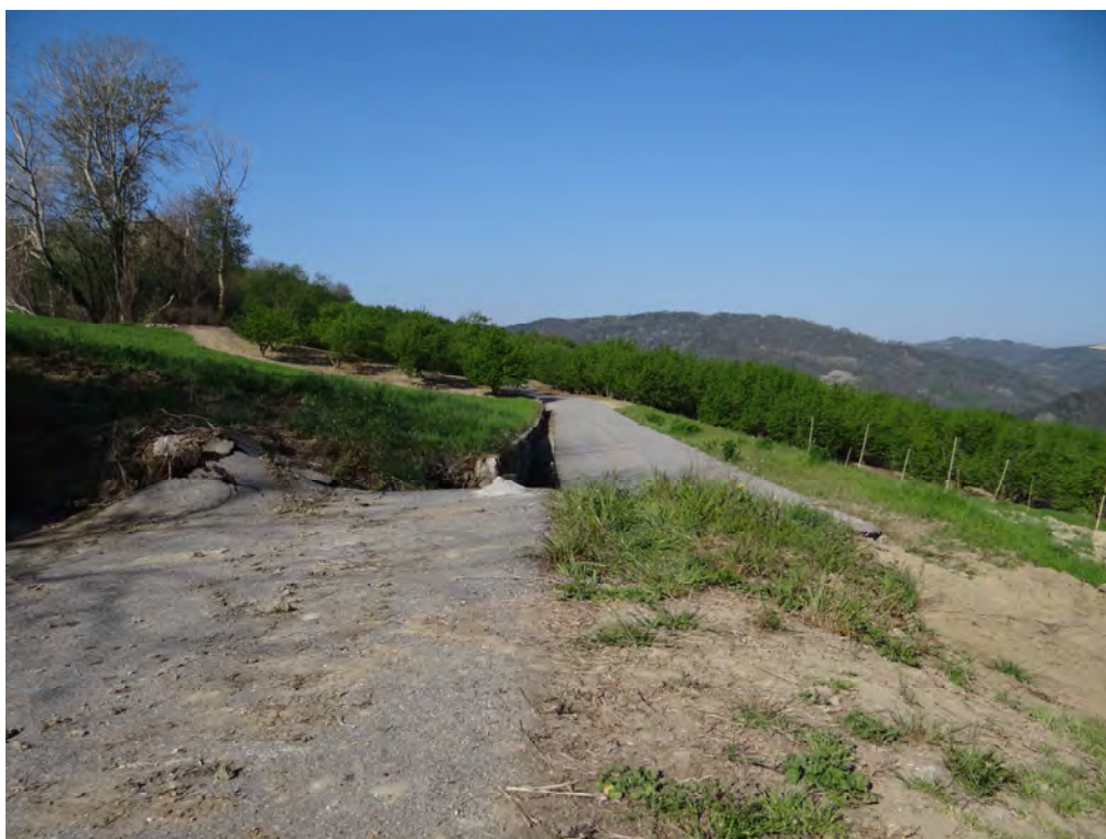
Traslazione della carreggiata della strada comunale in località Vernetta del comune di Castino (CN)
