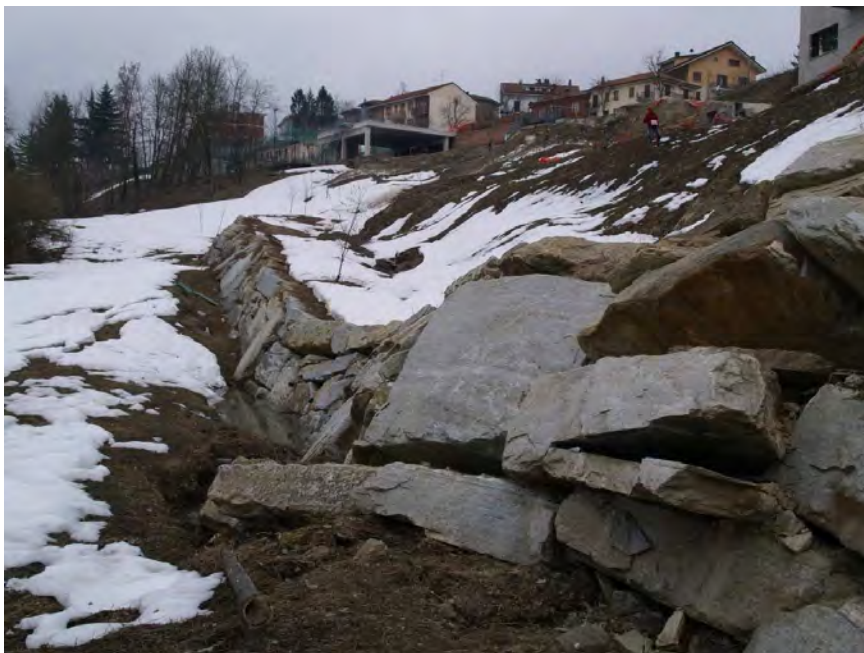
Immagine 04 - 2009/03/20-Deformazione della scogliera posta al piede del versante
