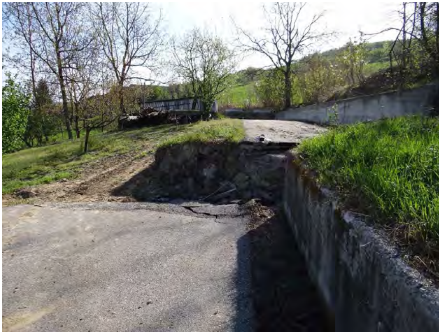
Immagine 17 - 2015/04/15-Traslazione della strada comunale in corrispondenza del fianco destro
