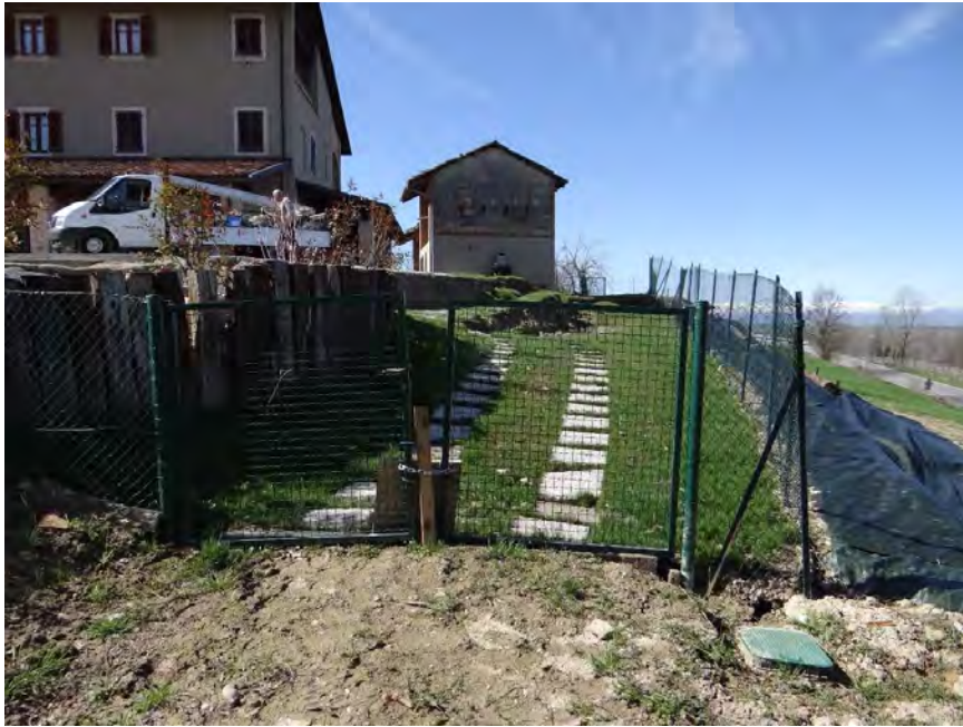
Immagine 03 - 2015_03_30-Danni alle pertinenze della Cascina Baricalino
