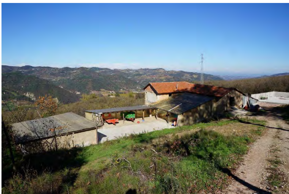
Immagine 06 - 2013/11/06-Abitazione isolata ubicata immediatamente a valle del coronamento in destra idrografica, abbandonata a causa dei pesanti danni subiti a seguito dell'attivazione della frana; la zona è monitorata dall'inclinometro I3
