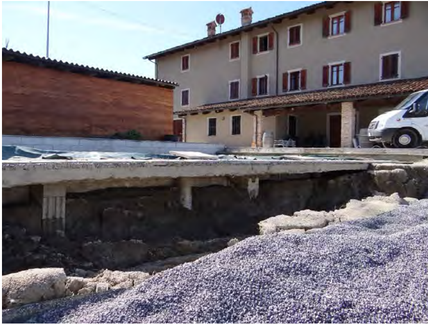
Immagine 05 - 2015_03_30-Sottoscalzamento della piscina
