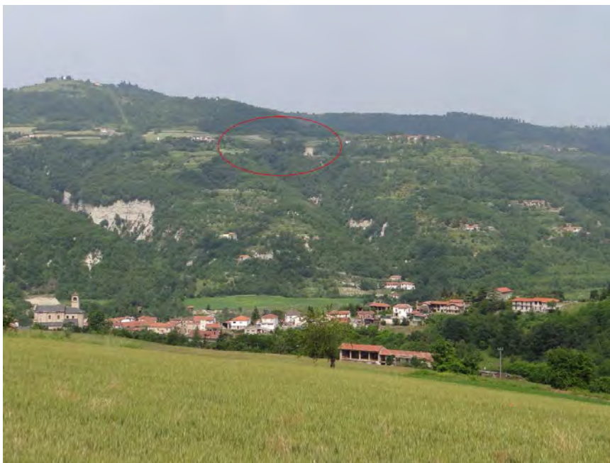
Immagine 01 - 2014/06/10-Panoramica scattata dal versante opposto, la zona in frana è indicativamente al centro dell'immagine; il settore denudato che si osserva è conseguente al fenomeno della primavera 2013
