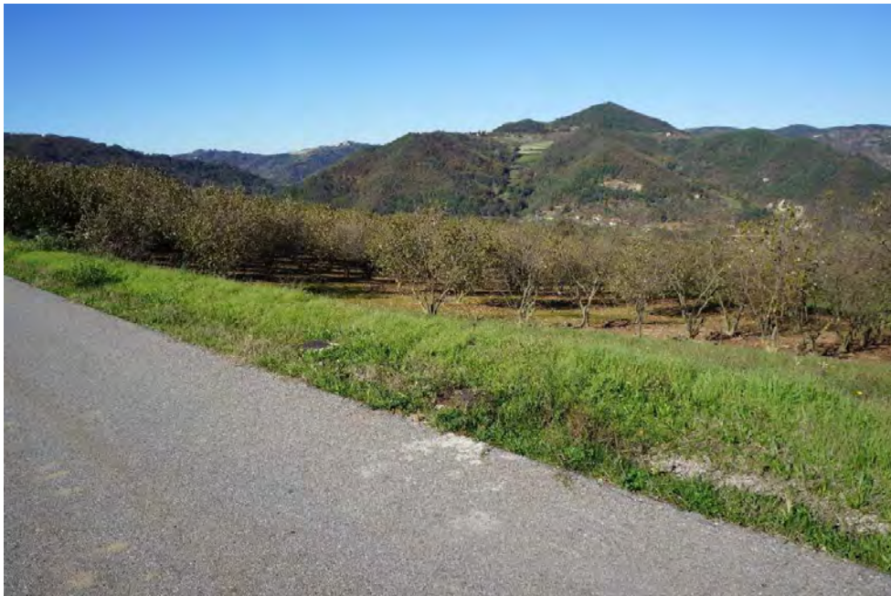
Immagine 03 - 2013/11/06-Probabile ubicazione della borgata di Vernetta Sottana distrutta dalla frana; a margine della strada gli strumenti di monitoraggio I2/10 e P2/10
