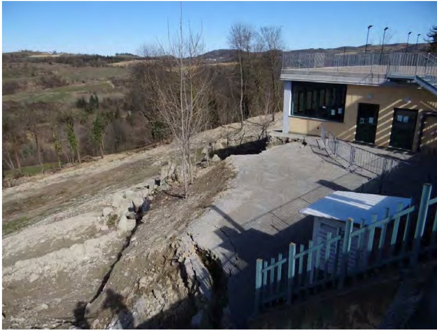
Immagine 09 - 2015/03/30-Coronamento di frana a ridosso delle strutture ricreative
