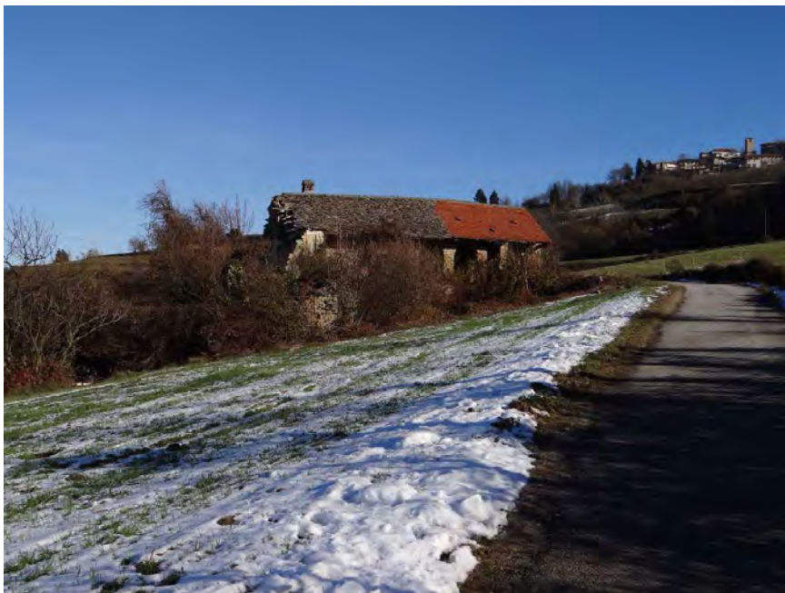
Immagine 04 - 2013/12/04-Cascina gravemente danneggiata dal movimento franoso dl 1972, ubicata in prossimità del suo fianco sinistro
