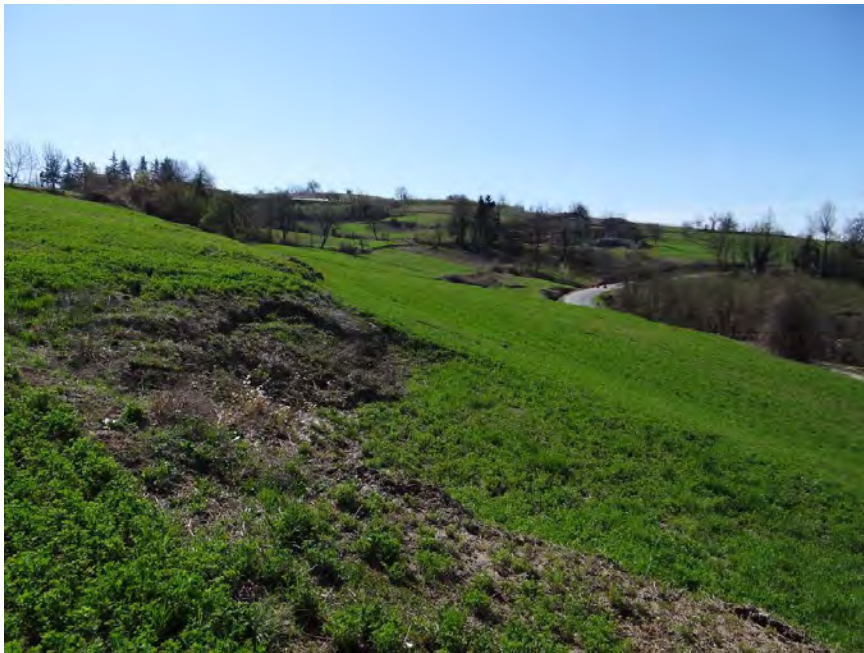
Immagine 05 - 2015/03/30-Rigonfiamenti al piede settentrionale del fenomeno franoso
