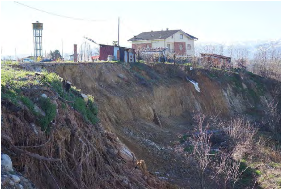
Immagine 03 - 2015/03/31-Particolar della scarpata di frana; sono evidenti le strutture minacciate pertinenti all'abitazione
