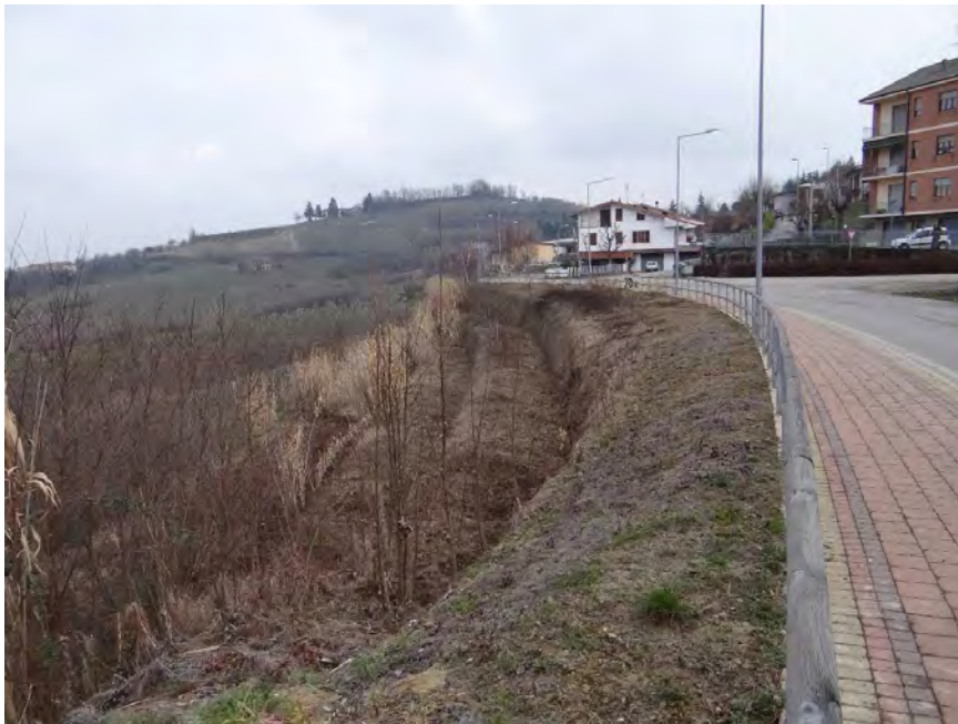
Immagine 03 - 2013_03_13-Opere di sostegno realizzate a valle della strada
