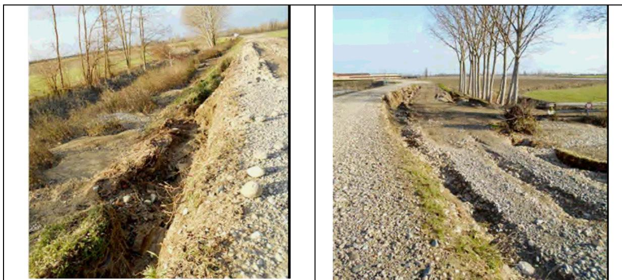
*Lavori di somma urgenza di ripristino e rialzo arginale per pericolo di sormonto argine e contenimento filtrazione sul paramento lato campagna del rilevato arginale in destra idraulica del fiume Bormida in localita' strada Stortigliona comuni di Alessandria e Pietramarazzi (AL).*
