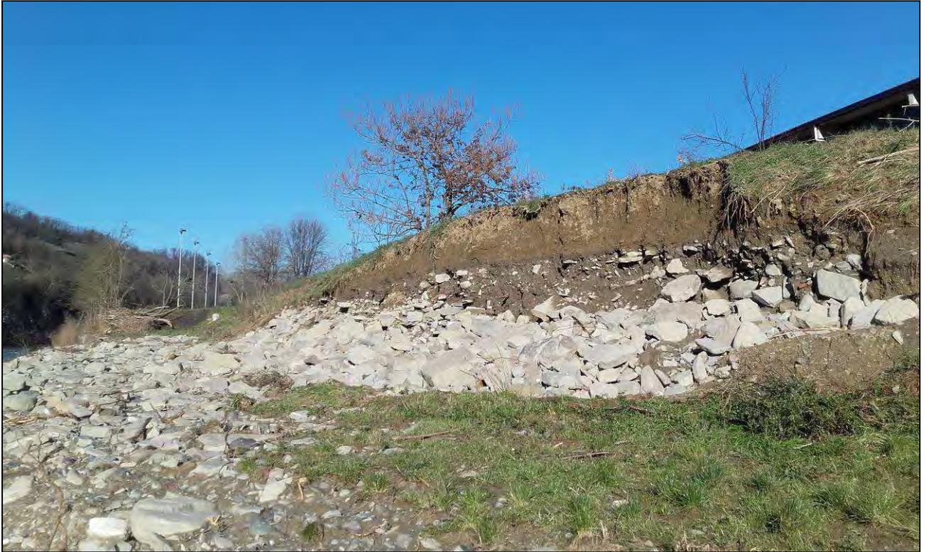
*Ponti: erosione rilevato di protezione abitato*
