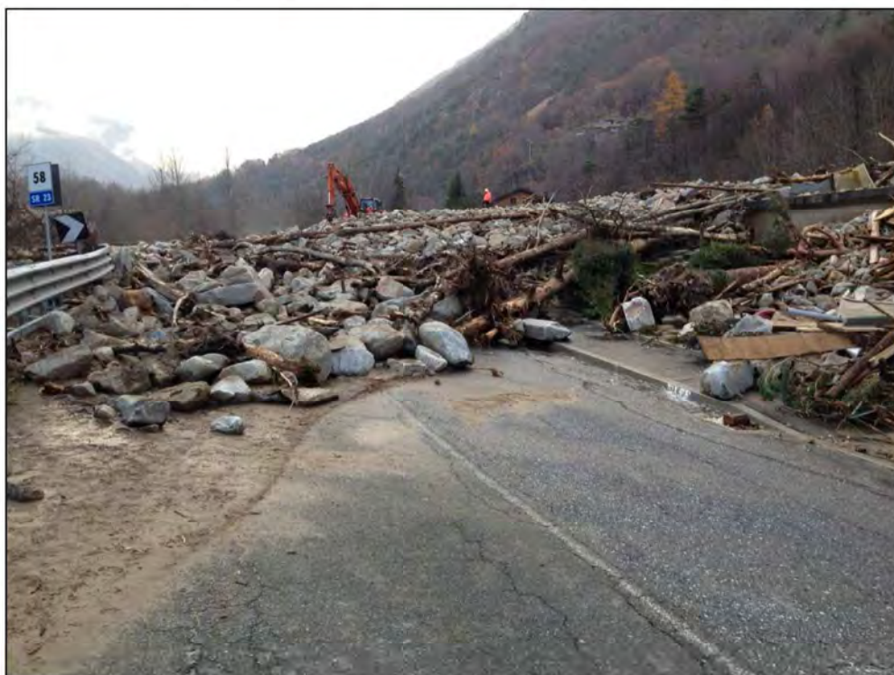
S.P. 23 del Colle del Sestriere - km 58+000– Comune di Perosa Argentina Rimozione colata detritica in prossimità attraversamento rio di Biera
