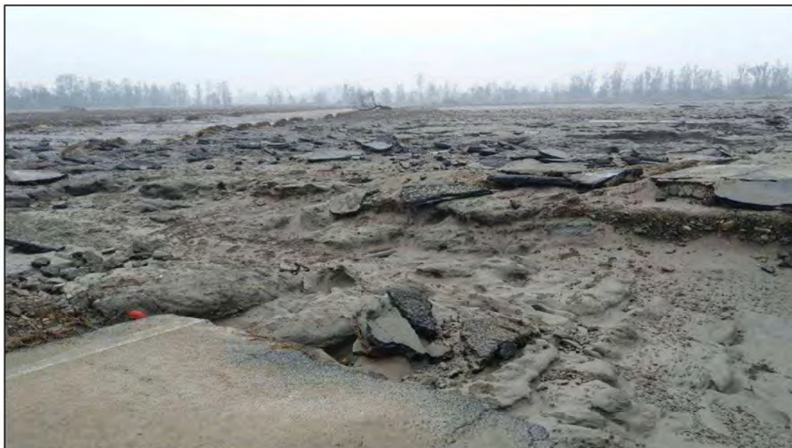
S.P. 149 di Pancalieri – Asportazione del corpo stradale per esondazione del fiume Po in comune di Pancalieri
