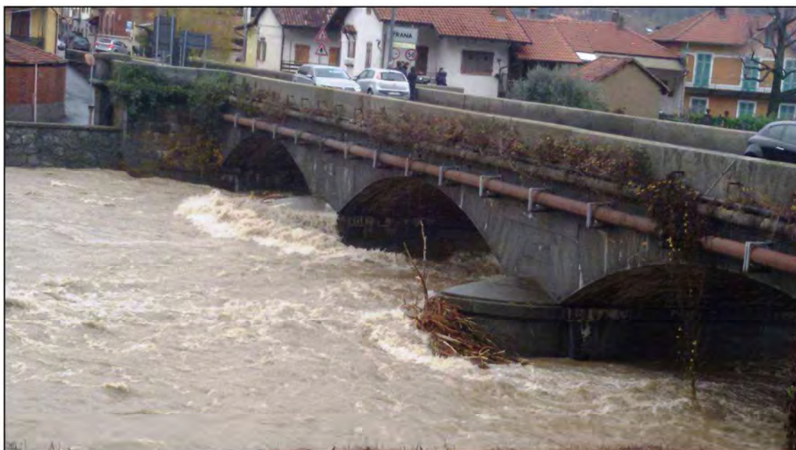
S.P. 589 dei Laghi di Avigliana – (Ponte sul torrente Sangone al km 7+270) – Deposito di materiale in corrispondenza di spalle e pile
