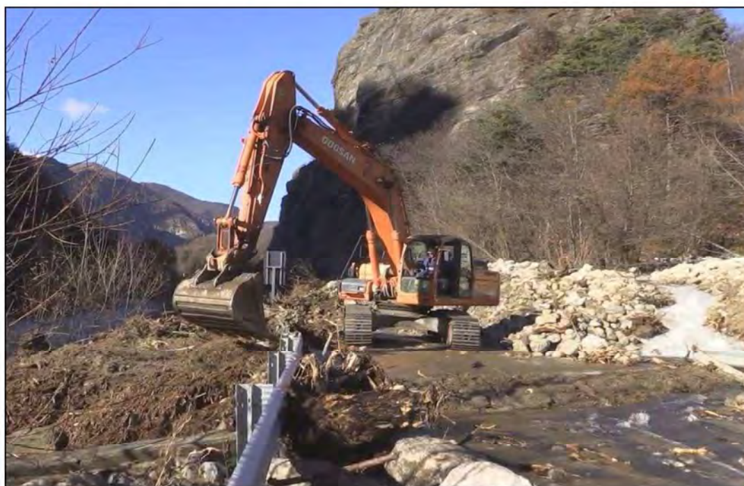
S.P. 23 del Colle del Sestriere - km 56+000/58+200 – Comune di Perosa Argentina Ripristino pavimentazione stradale nei tratti interessato dalle colate detritiche
