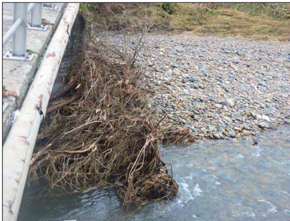
S.P. 8 di Druento – (Ponte sul torrente Casternone al km 17+550) – Deposito di materiale in corrispondenza di spalle e pile
