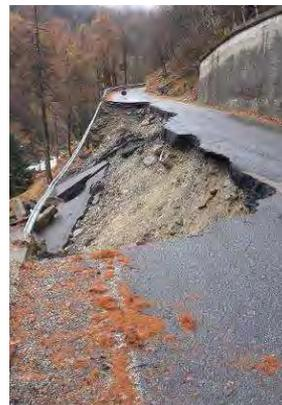
*PRALI- cedimento del sostegno di sottoscarpa della S.P.*
