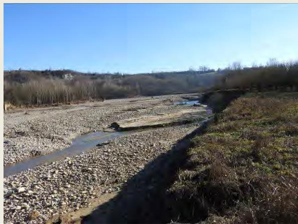
*Vista dalla sponda sinistra guardando verso monte. In primo piano l'erosione di sponda e sullo sfondo la nuova sezione d'alveo ottenuta dall'ampliamento del ramo di sinistra e dalla completa asportazione del terreno e della copertura arborea costituenti l'isola esistente prima della piena.*
