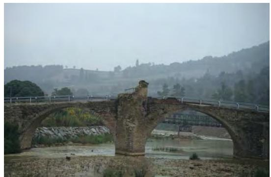
Figura 16 Fotografia del ponte medioevale gravemente danneggiato dalla piena del novembre '94 con l'asportazione della cappella e dei rilevati di accesso.
