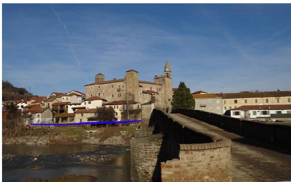
Figura 15 In primo piano il ponte di Monastero. La linea blu indica il battente d'acqua raggiunto sugli edifici a monte dell'opera nell'evento 2016. L'attraversamento è rimasto intatto.
