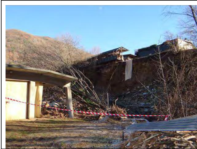
Figure 6. Erosioni di sponda lungo la comba della Rivoira (Pinasca)
