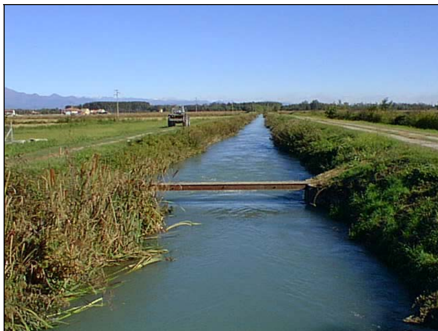
Canale De Pretis – dopo Carisio, prima dell'immissione in Elvo
