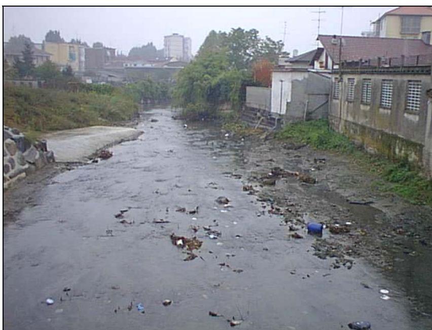
Colatore Cervetto - attraversamento del centro urbano di Vercelli
