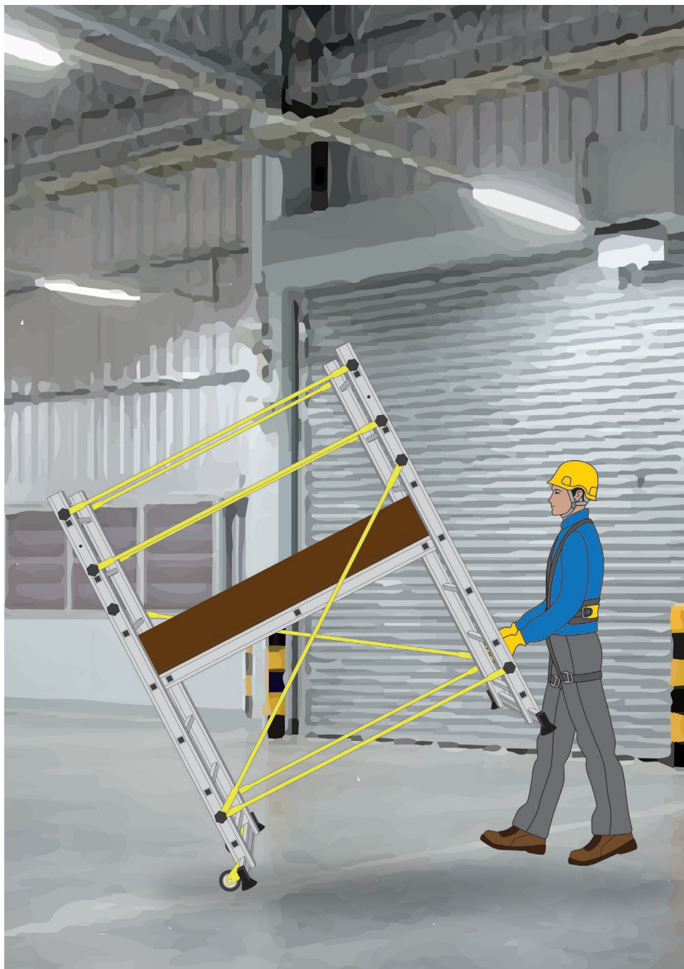
Figura 5 - Spostamento di un piccolo trabattello
