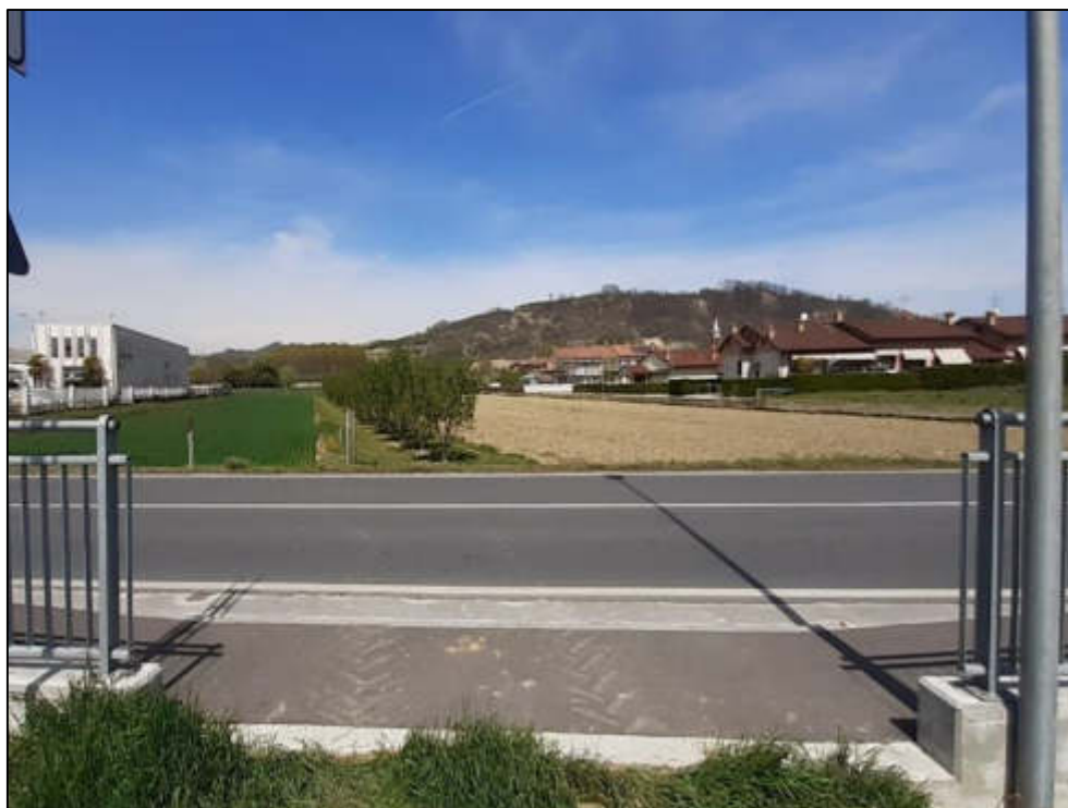
Figura 28 – Interruzione della barriera pedonale lungo la SS231 in corrispondenza dell'accesso alle aree coltivate a sud dell'infrastruttura viaria.
