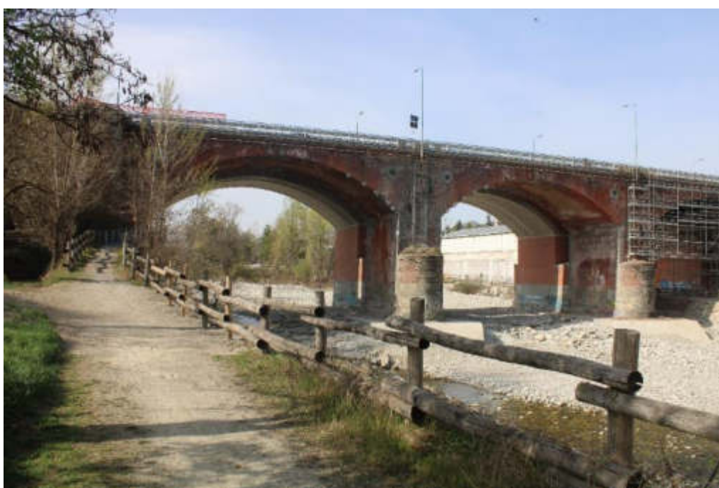
Figura 163 – Ponte della SP422 per il superamento del torrente Gesso in prossimità del varco V-32 in comune di Cuneo.
