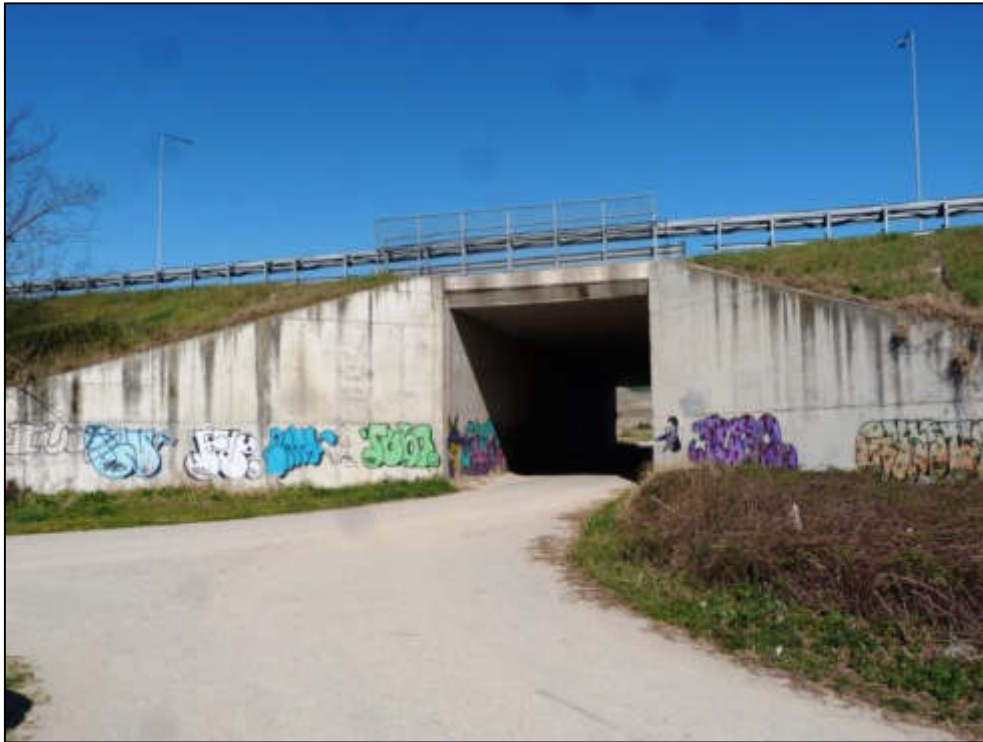
Figura 10 - Sottopasso carrabile della A33 in prossimità del varco V-02 in comune di Guarene.
