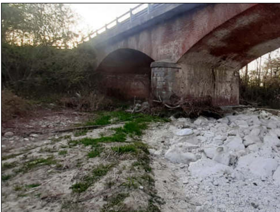
Figura 127 – Dettaglio della sponda destra del torrente Varaita in corrispondenza del ponte della SP129.
