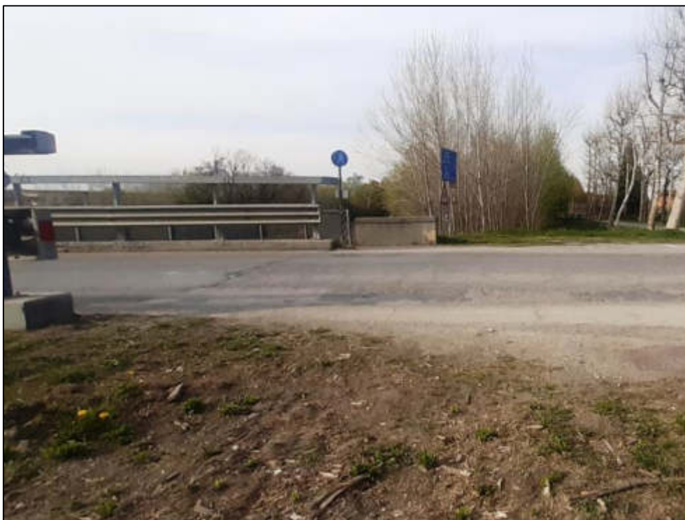
Figura 90 – Tratto della SP129 in sponda destra del torrente Maira che è necessario superare per gli spostamenti della fauna terrestre lungo la direttrice Sud/Nord.
