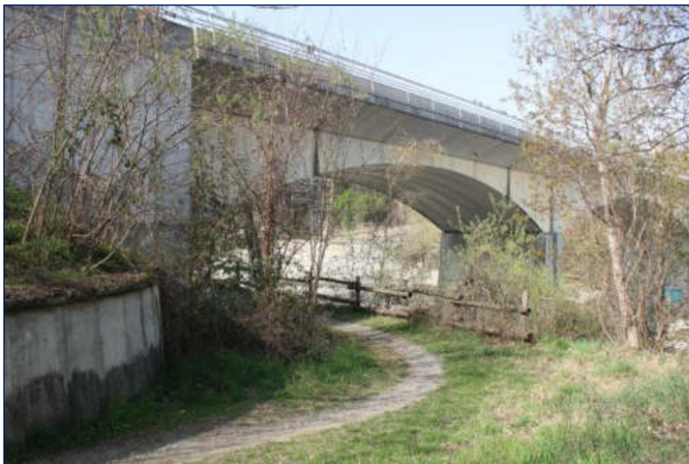
Figura 162 – Ponte della ferrovia Cuneo – Mondovì per il superamento del torrente Gesso in prossimità del varco V-32 in comune di Cuneo. Si noti la pista ciclo-pedonale che percorre la sponda destra del torrente.
