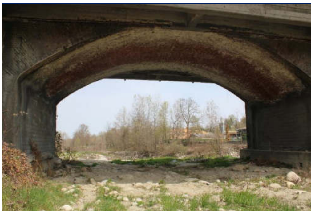
Figura 70 – Dettaglio della sponda sinistra del torrente Pesio in corrispondenza del ponte della SP37, con passaggio utilizzato dalla fauna terrestre per gli spostamenti lungo l'alveo.
