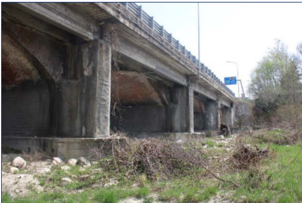
Figura 69 – Ponte della SP37 per il superamento del torrente Pesio in prossimità del varco V-30 in comune di Pianfei.
