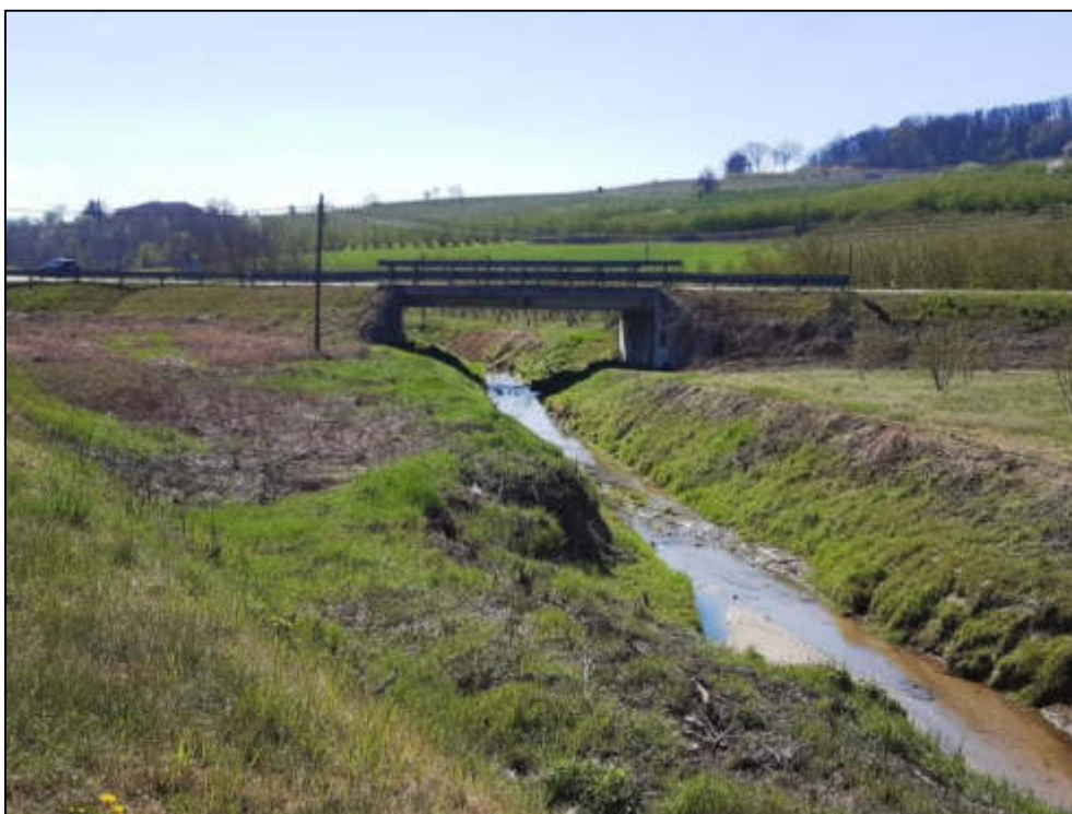
Figura 18 – Corso del torrente Ridone a nord del nuovo tracciato della SP10 e sovrappasso con ampie sponde fruibili dalla fauna selvatica.
