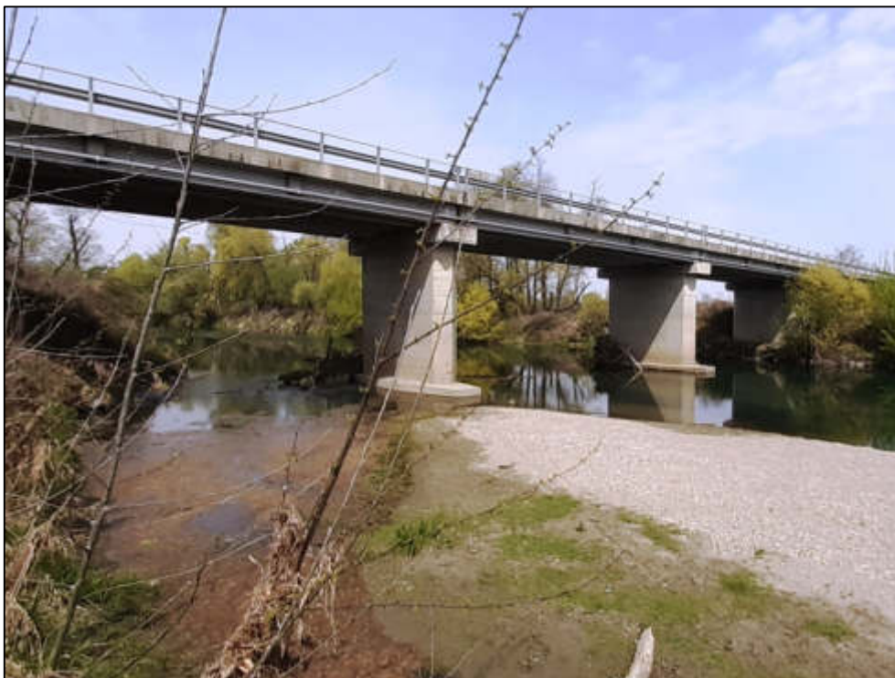
Figura 194 – Ponte della SP207/SP149 per il superamento del fiume Po, in prossimità del varco V-24 fra i comuni di Faule e Pancalieri.
