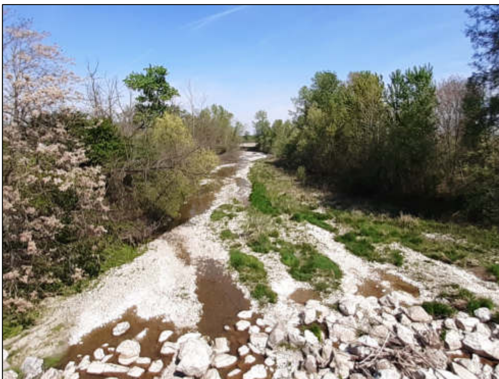
Figura 128 – Alveo del torrente Varaita a valle del ponte della SP129.
