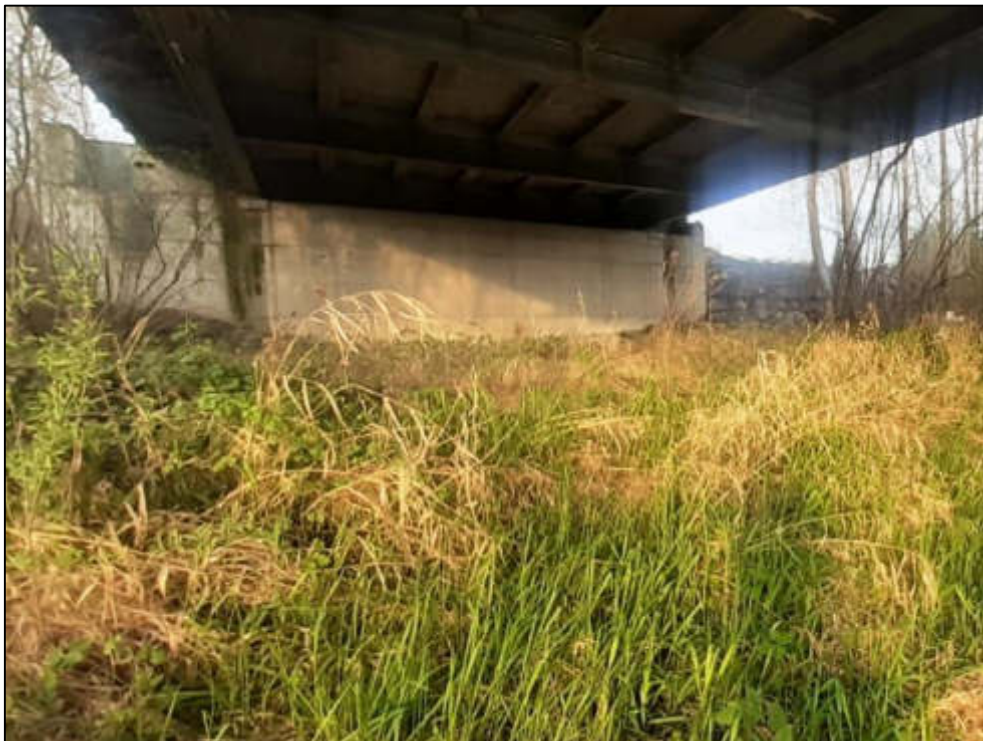
Figura 119 – Dettaglio della sponda destra del torrente Varaita in corrispondenza del ponte della SP175.
