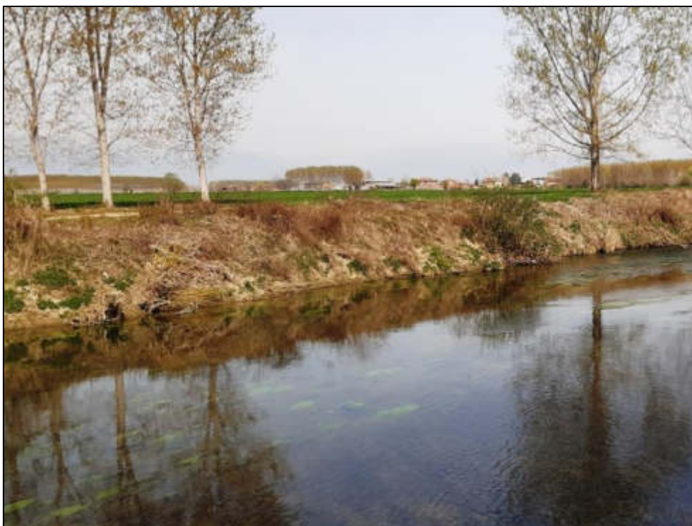
Figura 222 – Interruzione della vegetazione spondale del fiume Po in corrispondenza del varco V-27.
