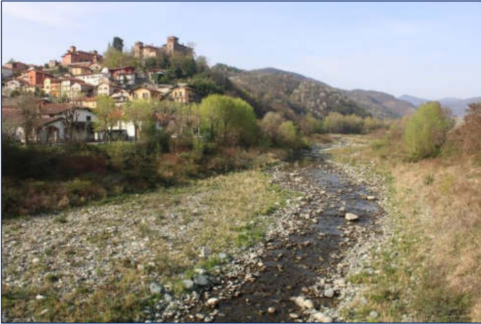
Figura 144 – Il torrente Varaita a monte del ponte della SP589. Si noti in sponda destra l'abitato di Costigliole Saluzzo e più a monte la prima fascia collinare, con boschi che presentano un elevato grado di naturalità.
