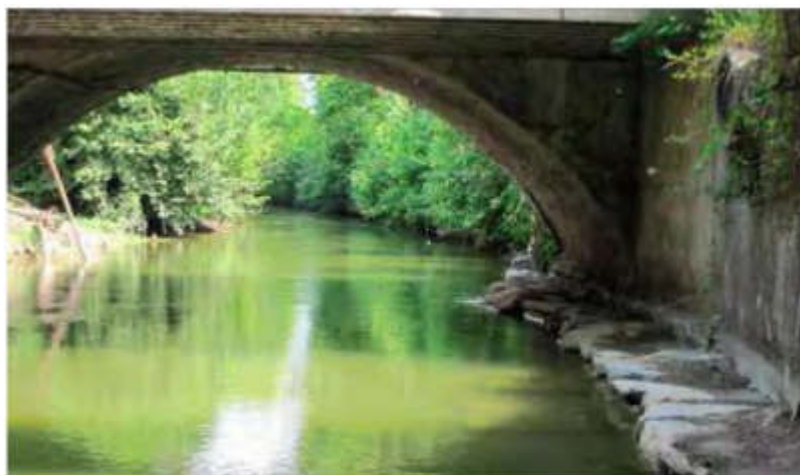
Figura 206 – Passaggio faunistico realizzato con massi ammorsati in alveo (intervento realizzato nell'ambito del progetto LIFE TIB lungo il fiume Bardello).
