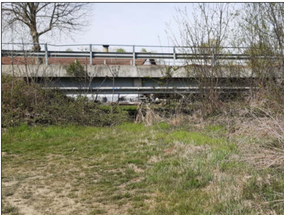
Figura 195 – Passaggio non occluso lungo la sponda destra del fiume Po, che consente il superamento in sicurezza della SP207/SP149 da parte della fauna terrestre.
