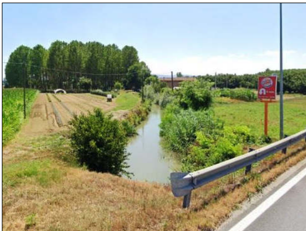
Figura 23 – Mosaico di aree agricole e arboricoltura da legno a sud della SS231, lungo il canale Mussotto, in prossimità del varco V-06 in comune di Alba.
