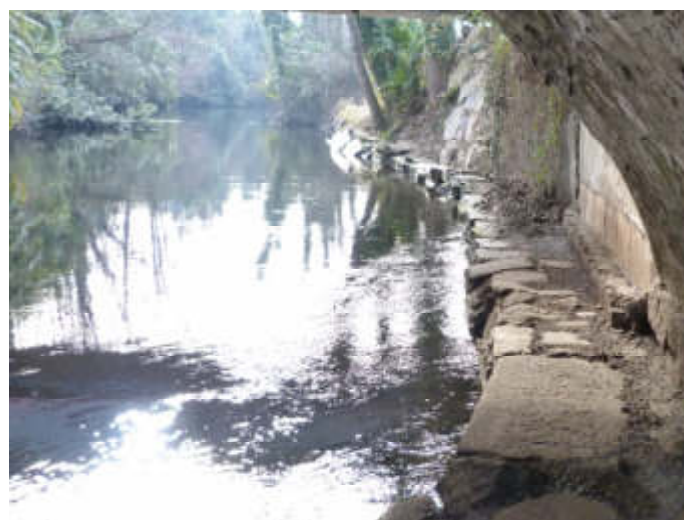
Figura 64 – Esempio di passaggio faunistico realizzato con massi ammassati in alveo in corrispondenza di un ponte stradale (intervento realizzato nell'ambito del progetto LIFE TIB lungo il fiume Bardello).
