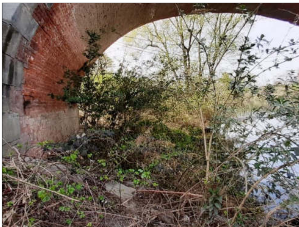
Figura 186 – Dettaglio della sponda destra del fiume Po in corrispondenza del ponte della SP663 che consente lo spostamento della fauna terrestre sotto la strada provinciale.
