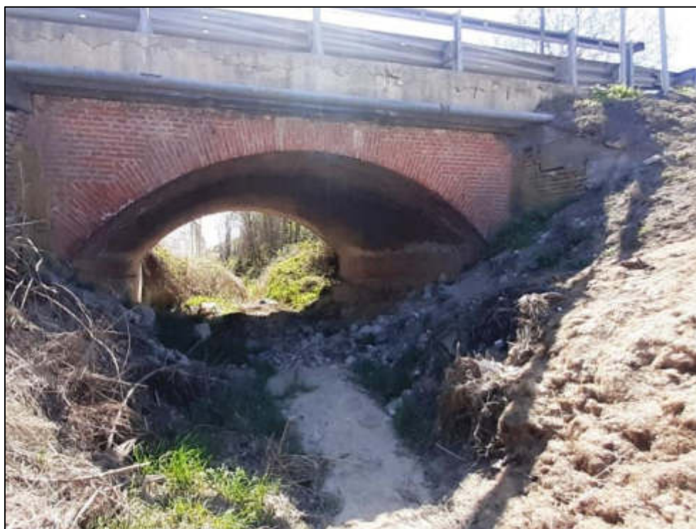
Figura 49 – Dettaglio della sponda destra del rio della Gera in corrispondenza del superamento della statale SS231.
