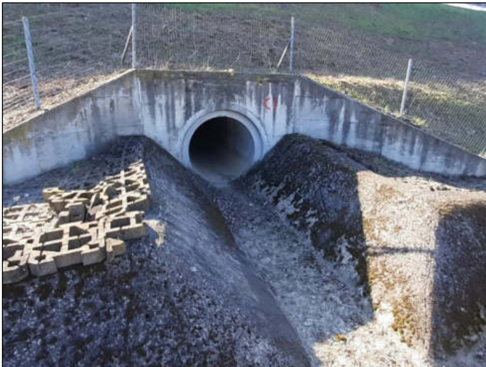
Figura 11 - Canalizzazione di drenaggio della A33 in prossimità del varco V-02, nella porzione nordoccidentale.
