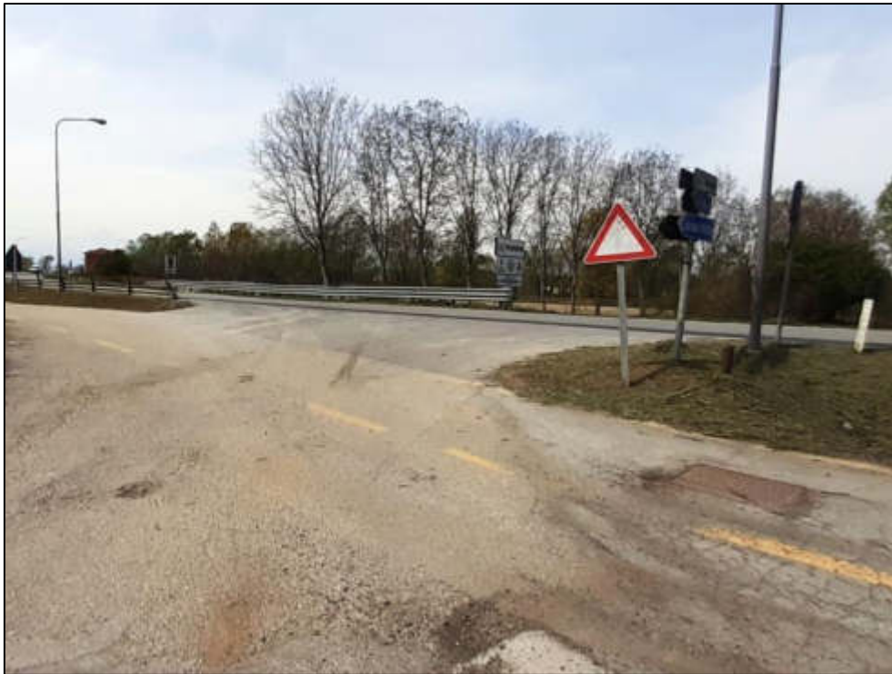
Figura 134 – Tratto di attraversamento della SP663 in corrispondenza del varco V-23 in comune di Polonghera.
