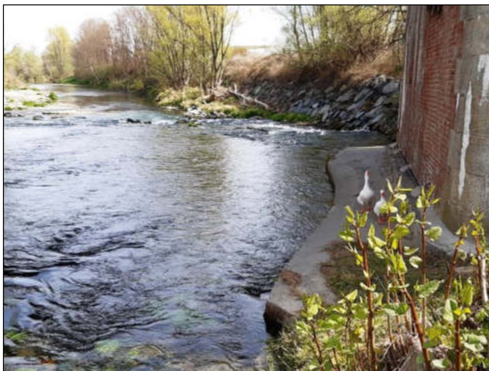
Figura 212 – Dettaglio della sponda destra del fiume Po in corrispondenza del ponte della SP1, con cengia utilizzata dalla fauna per gli spostamenti lungo l'alveo, non raccordata all'argine a valle del ponte.
