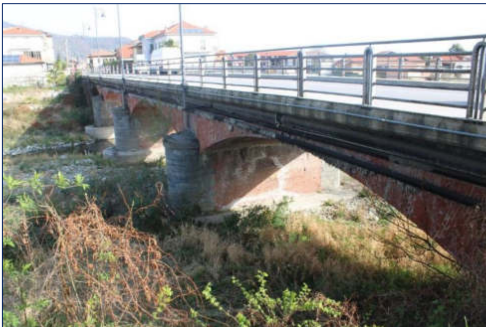
Figura 142 – Ponte della SP589 per il superamento del torrente Varaita in prossimità del varco V-29 in comune di Costigliole Saluzzo. Si noti la presenza di vegetazione erbacea sotto le arcate del ponte, che le rende permeabili alla fauna terrestre.
