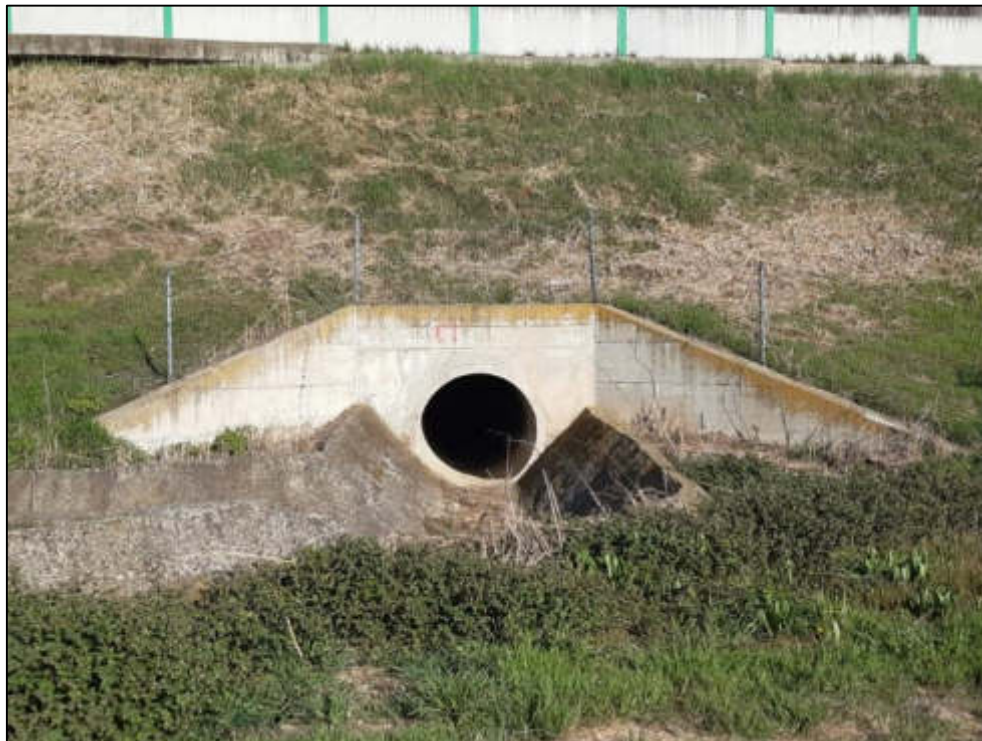
Figura 6 – Una delle due canalizzazioni di drenaggio della A33 in prossimità del varco V-01 in comune di Magliano Alfieri.
