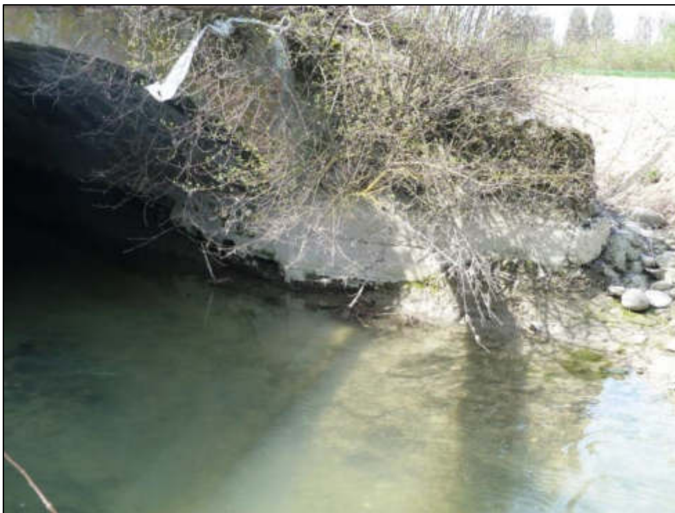
Figura 25 – Dettaglio della sponda del canale Mussotto che manca di continuità in sponda sinistra, dopo il superamento della SS231 presso il varco V-06 in comune di Alba.
