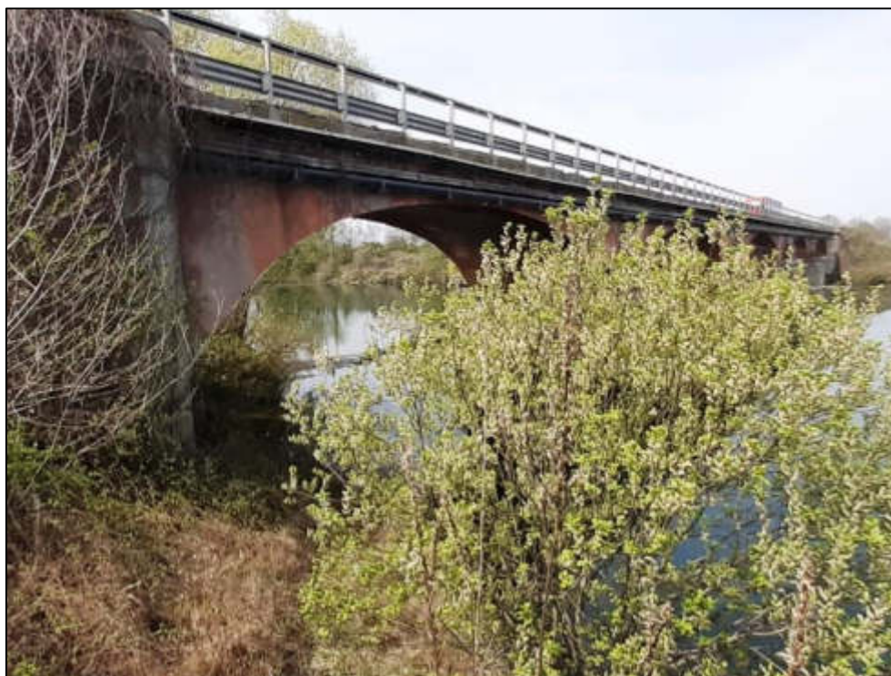
Figura 185 – Ponte della SP663 per il superamento del fiume Po in prossimità del varco V-21 in comune di Casalgrasso.
