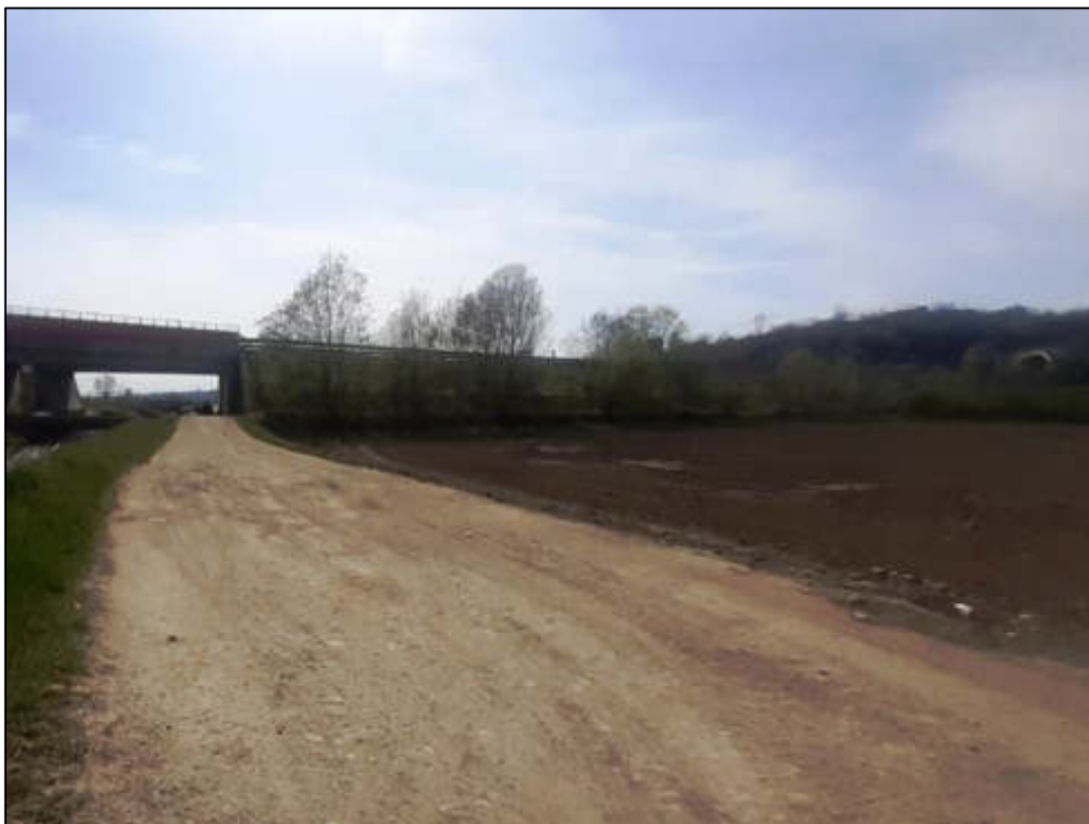
Figura 156 - Sottopasso carrabile della A33 in prossimità del varco V-13 in comune di Cherasco.
