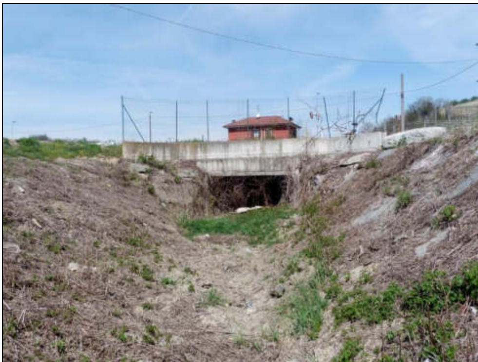
Figura 22 – Apertura meridionale del canale di sfioro del canale Mussotto, dopo il superamento della SS231 presso il varco V-05 in comune di Alba.
