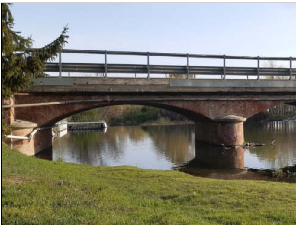
Figura 88 – Dettaglio delle sponde del Maira in corrispondenza del ponte della SP129 che impedisce lo spostamento della fauna terrestre sotto la strada provinciale.
