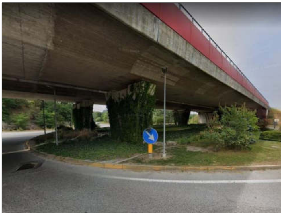
Figura 147 – Tratto rilevato della A33 in corrispondenza del superamento della rotonda lungo la SP661 in comune di Cherasco.
