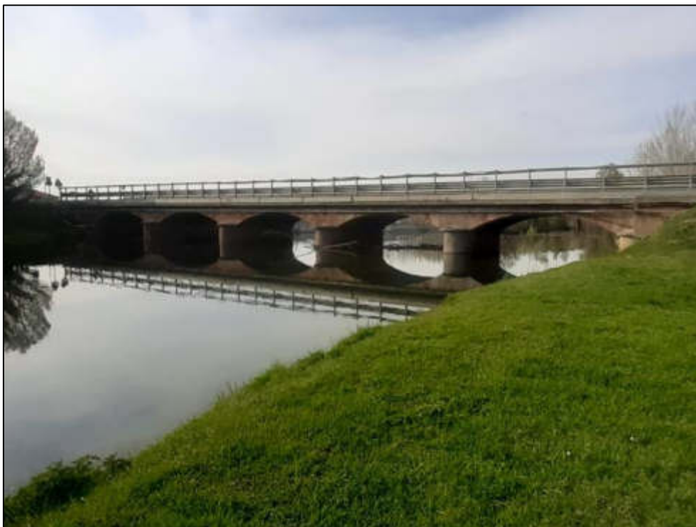
Figura 87 – Ponte della SP129 per il superamento del torrente Maira in prossimità del varco V-15 in comune di Cavallermaggiore.
