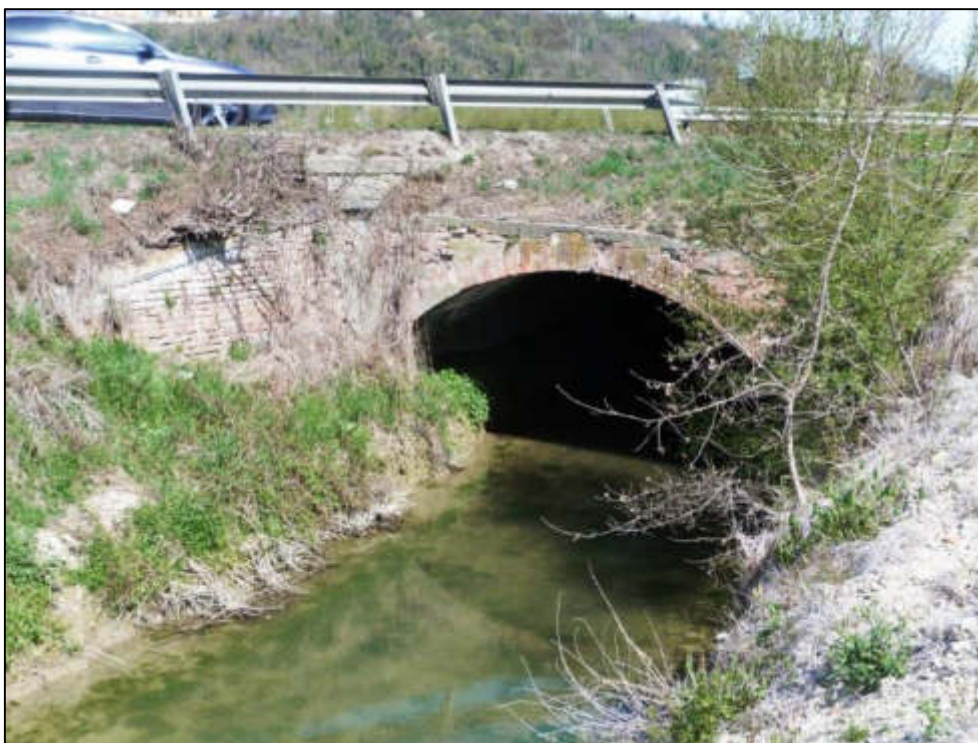
Figura 26 – Aspetto della sponda del canale Mussotto dove potrebbe essere migliorata la continuità in sponda sinistra, prima del superamento della SS231 presso il varco V-06 in comune di Alba.
