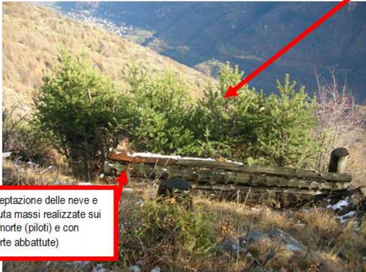
Barriere contro la reptazione delle neve e per il controllo caduta massi realizzate sui ceppi delle piante morte (pilotti) e con correnti (piante morte abbattute)
