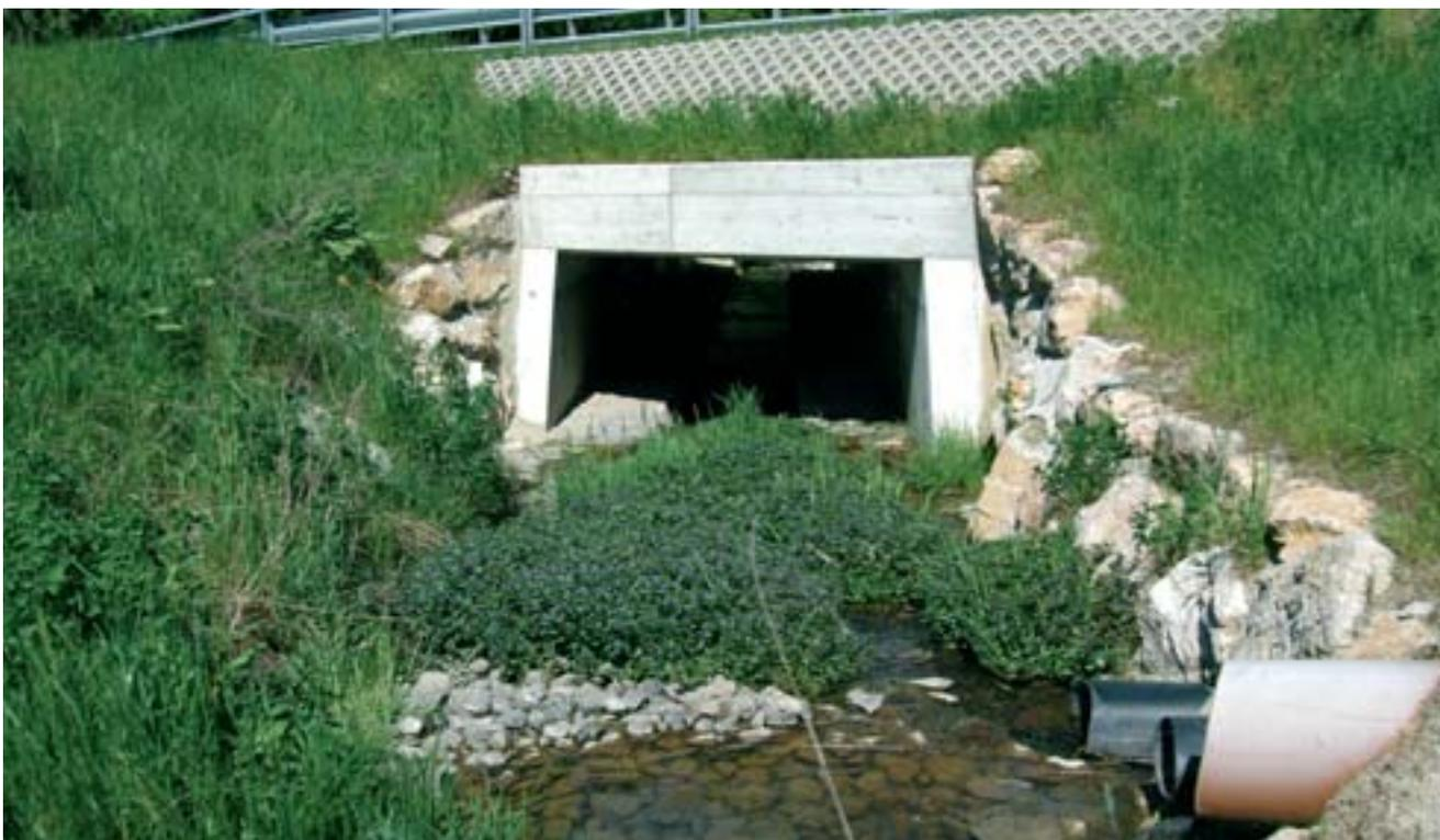
Fig. 14 - Particolare rinaturalizzazione del rio nel punto dello scarico del bacino di trattamento e sottopasso idraulico attrezzato per il passaggio della fauna (si notino le due banchine laterali a lato del rio)
