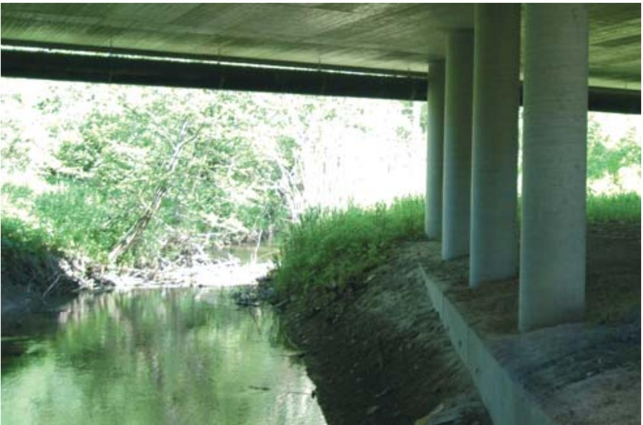
Fig. 35 - Sottopasso misto per la fauna e per il passaggio di acque superficiali
