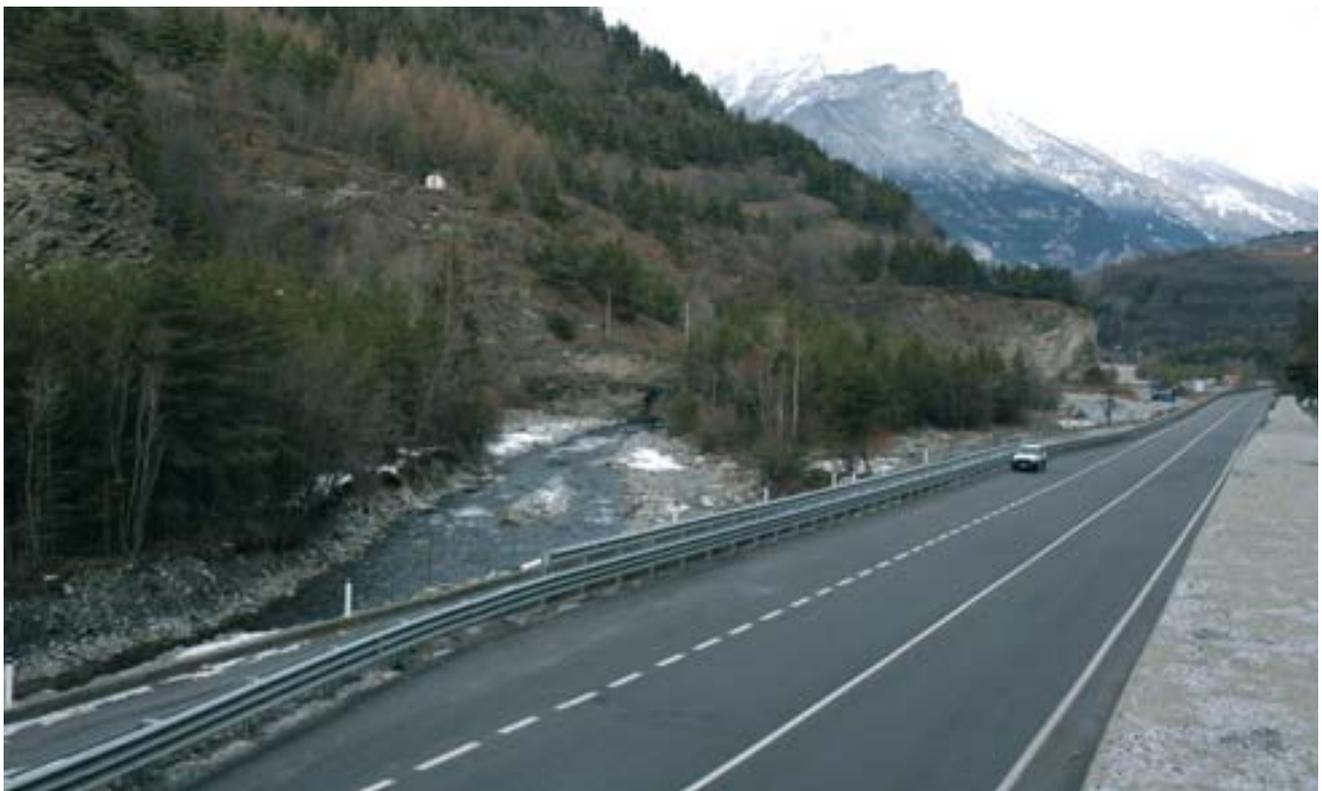
Fig. 6 - Tratto invalicabile per la fauna per presenza di guard-rail alto e assenza di accessi al torrente
