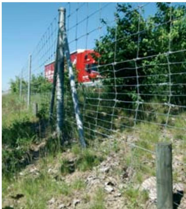
Fig. 16 - Particolare della recinzione antiscafcamento ungulati con maglia fitta in basso per la microfauna e con maglia larga nella porzione superiore.
