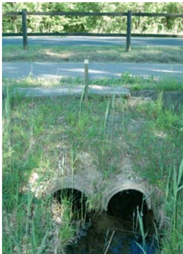
Fig. 6 - Uscita del passaggio anfibi con sistema a doppi tubi
