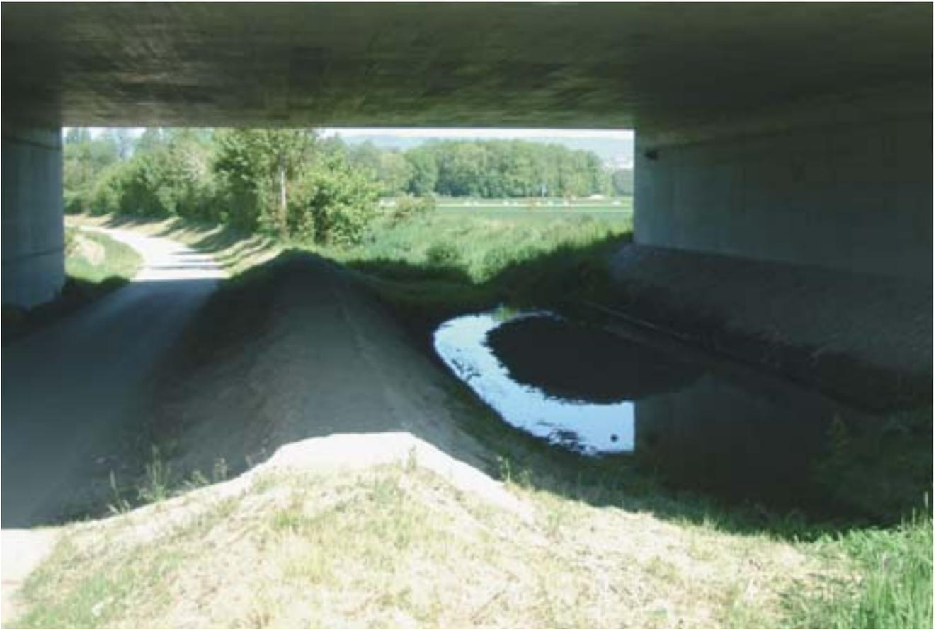
Fig. 34 - Sottopasso misto per la fauna e per il passaggio della viabilità rurale
