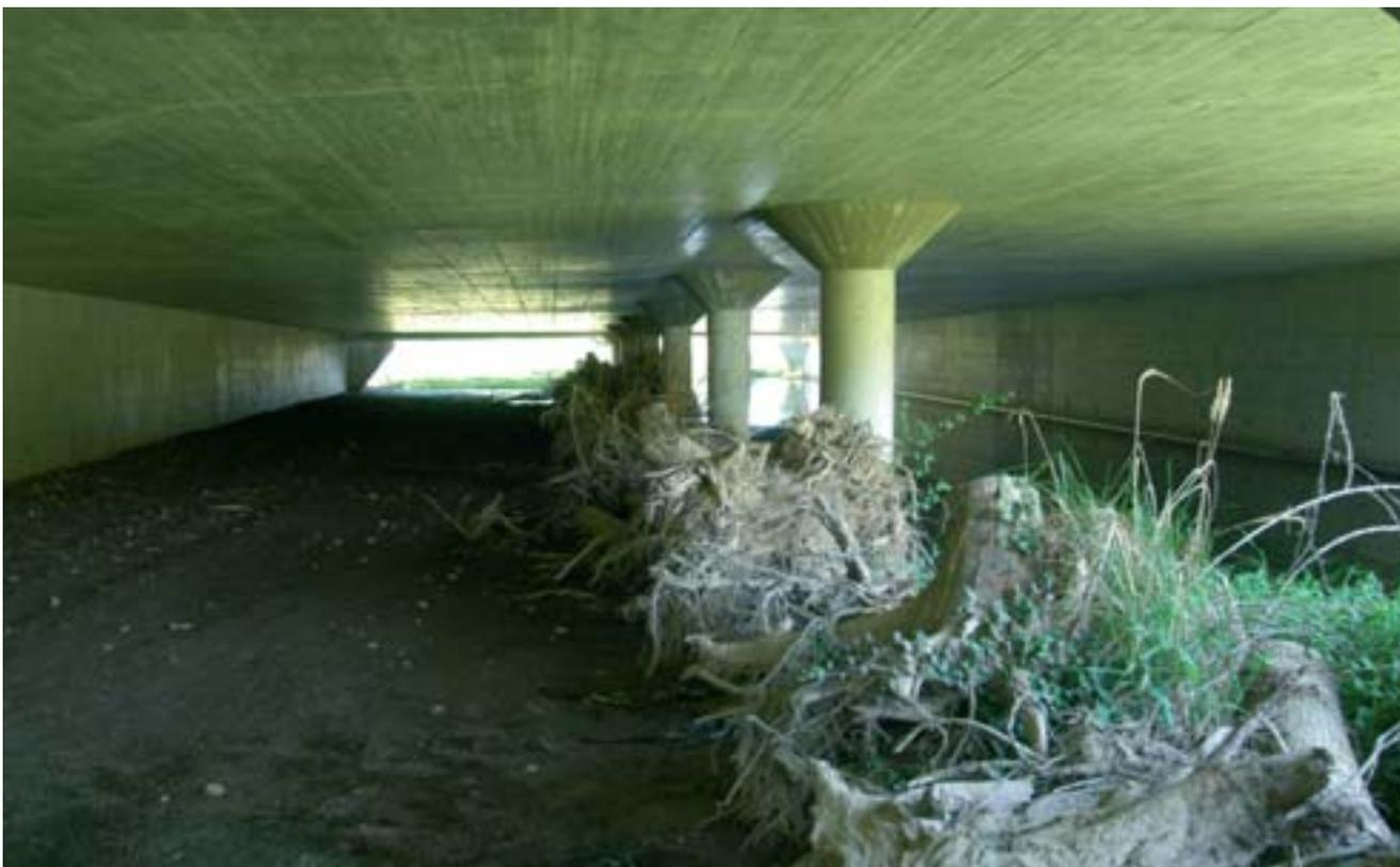
Fig. 24 – Particolare della sistemazione del sottopasso con la disposizione di una fila di ceppi che separa la parte allagata dalla fascia in terreno transitabile dalla fauna
