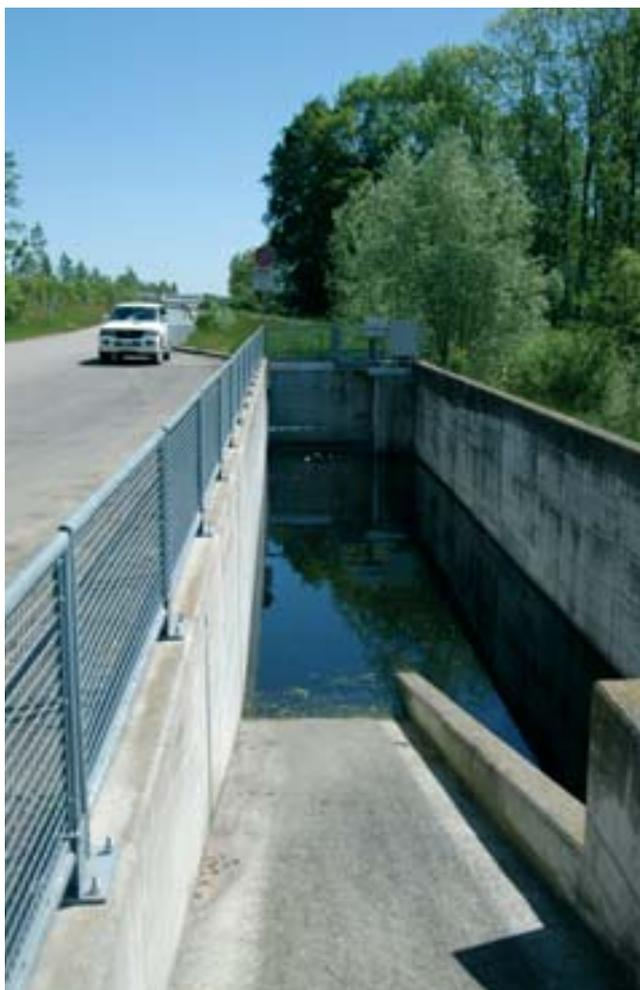
Fig. 21 - Particolare della vasca di prima pioggia con sedimentatore per olii che precede il bacino
