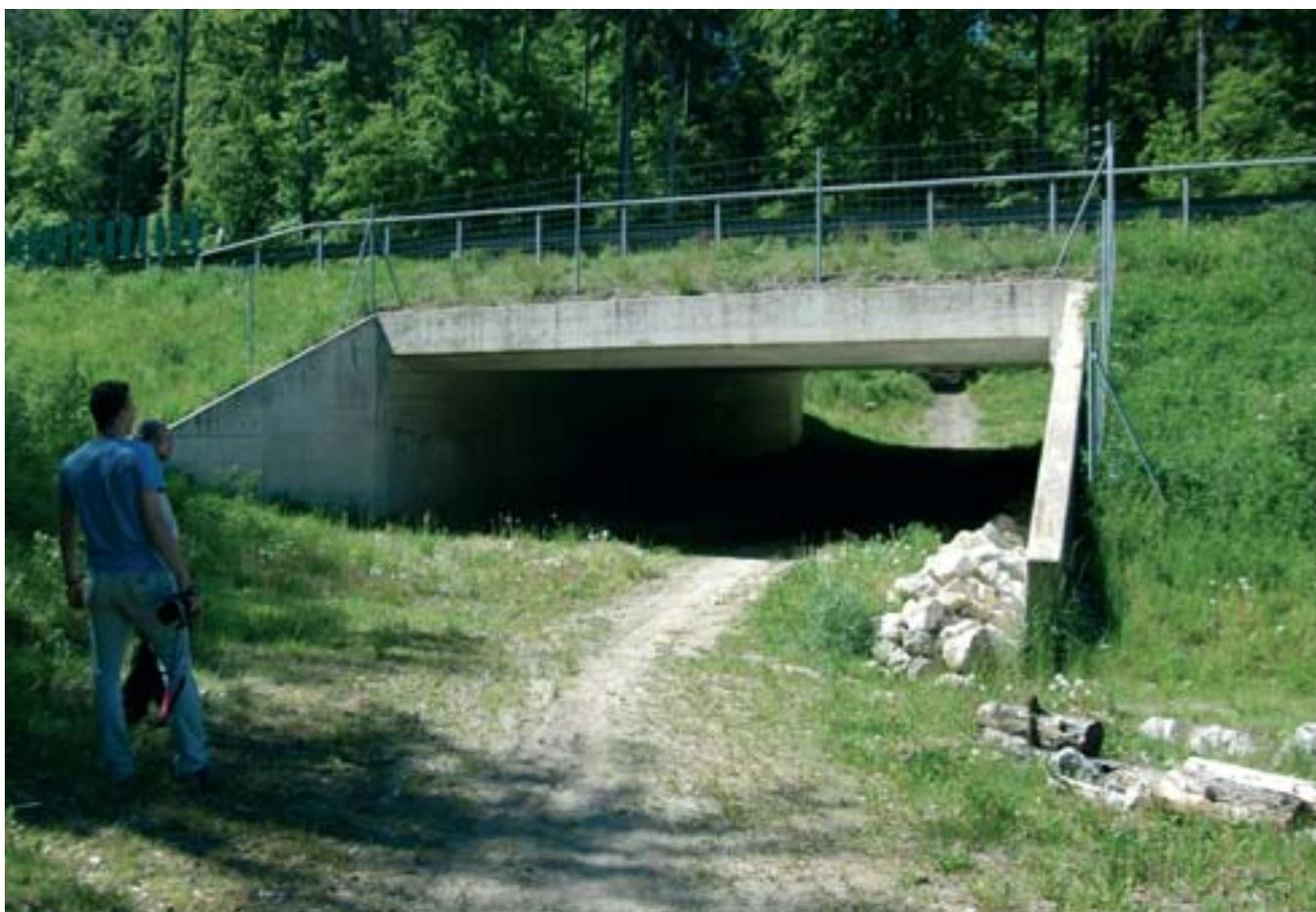
Fig. 10 - Sottopasso ad uso faunistico lungo una pista forestale. Si notino le fasce erbose ai margini e la fila di sassi
