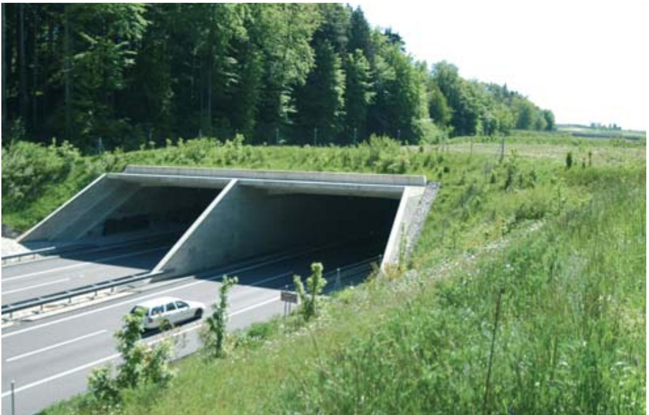
Fig. 17 - Ecodotto di Chévrefu – Particolare copertura dell'ecodotto
