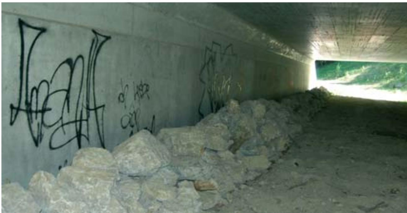
Fig. 11 - Particolare della disposizione della fila di sassi all'interno del sottopasso
