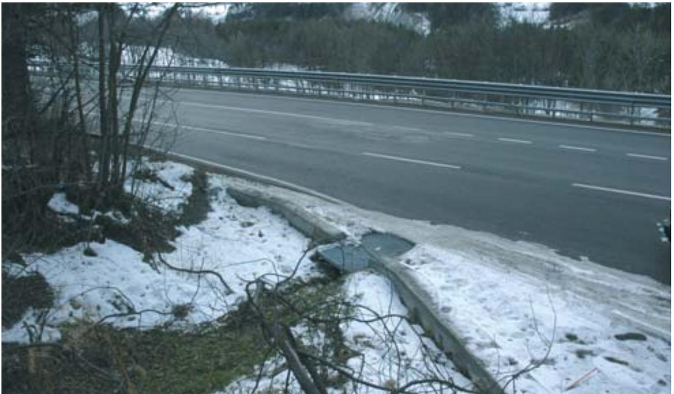
Fig. 12 - Tombino di scolo dell'acqua la cui chiusura ne impedisce l'utilizzo come sottopasso per la piccola fauna e causa l'intrappolamento degli animali
