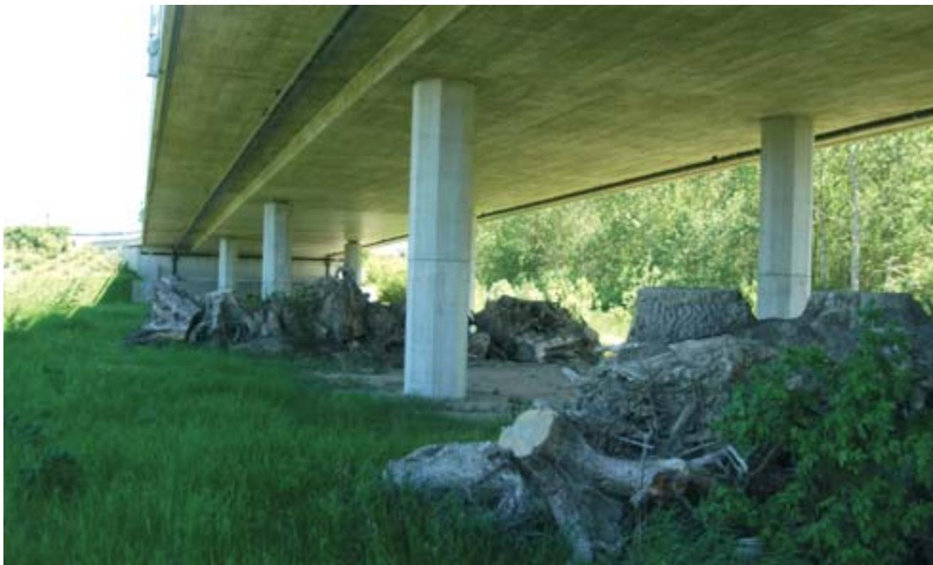
Fig. 25 - Particolare della disposizione delle file di ceppi sotto il viadotto per ripristinare il corridoio ecologico interrotto
