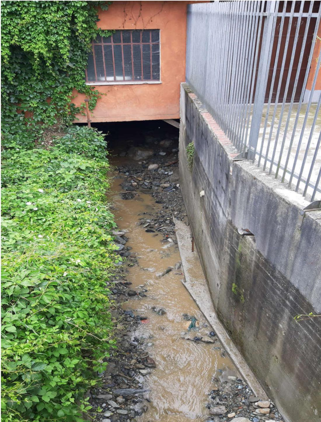
Figura 16. Sbocco dell'intubamento del Rio di S. Anna che non ha smaltito la portata solida a causa dell'ostruzione dello stesso
