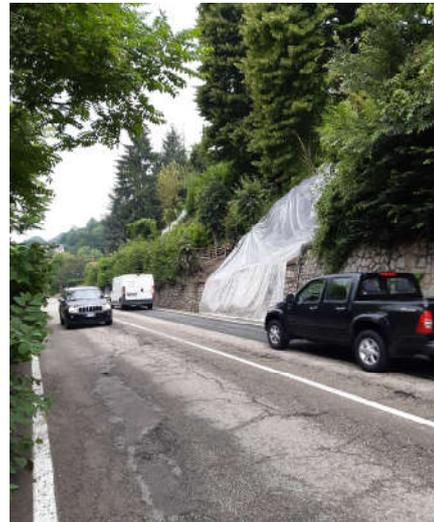
Figura 23. SR 10 del traforo del Pino nel Comune di Torino. Colata di materiale detritico e terroso che ha provocato danni funzionali alla sede stradale.
