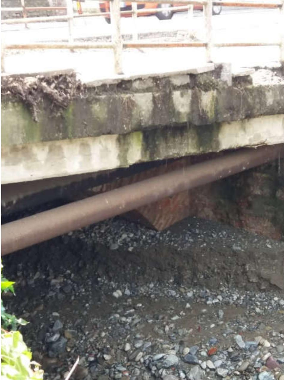
Figura 20. Ripresa da valle dell'attraversamento del Rio S. Anna su via Torino; visibile sia il ponte ad arco, sia l'ingombro del materiale ghiaioso-ciottoloso che riducono la sezione di deflusso.
