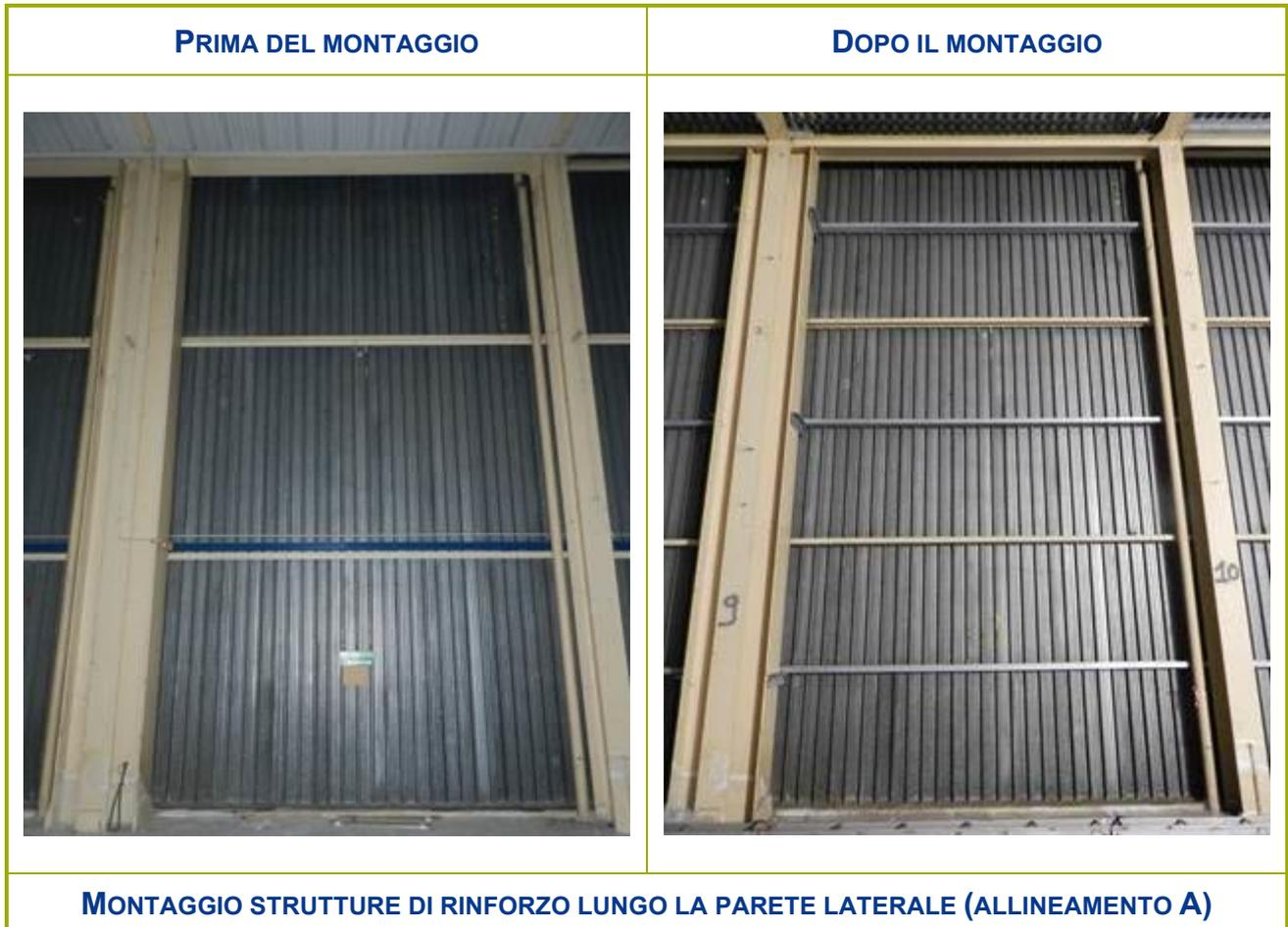
Figura 2-59 – Montaggio strutture di rinforzo lungo la parete laterale (Allineamento A)
