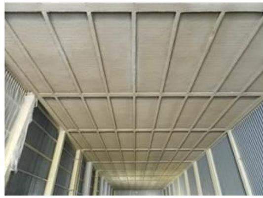
**Figura 2-64 – Attività di posa dell'intonaco ignifugo**
