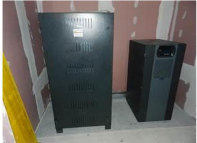
Figura 2-84 – Installazione Quadri elettrici e UPS
