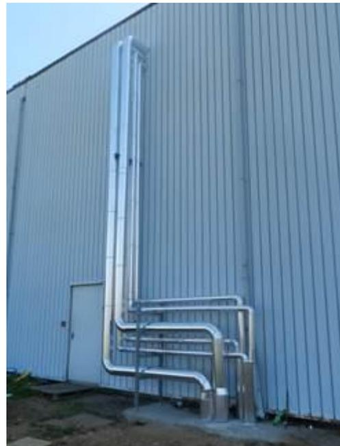
Figura 2-82 – Attività di coibentazione delle tubazioni dei fluidi termovettori
