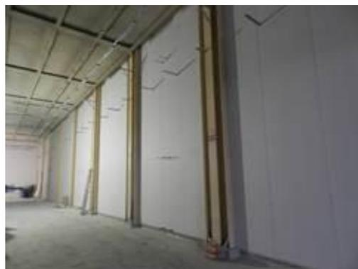
**Figura 2-70 – Attività di rivestimento in cartongesso pareti Area di Stoccaggio**
