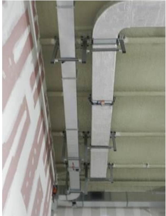
Figura 2-76 – Montaggio condotte di ventilazione
