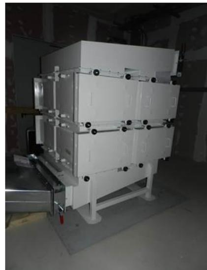
Figura 2-85 – Installazione ventilatore di estrazione e canister
