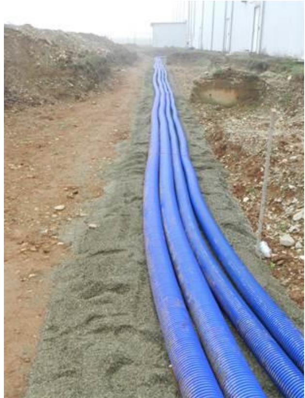
**Figura 2-77 – Montaggio tubazioni interrate per fluidi termovettori**
