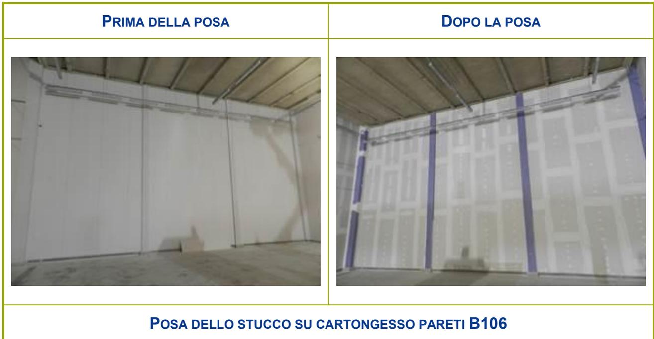
**Figura 2-71 – Posa dello stucco sul cartongesso delle pareti del locale B106**
