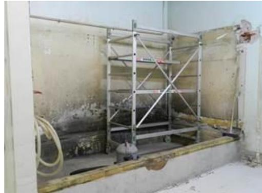
Figura 2-40 – Smantellamento della vasca di decontaminazione
