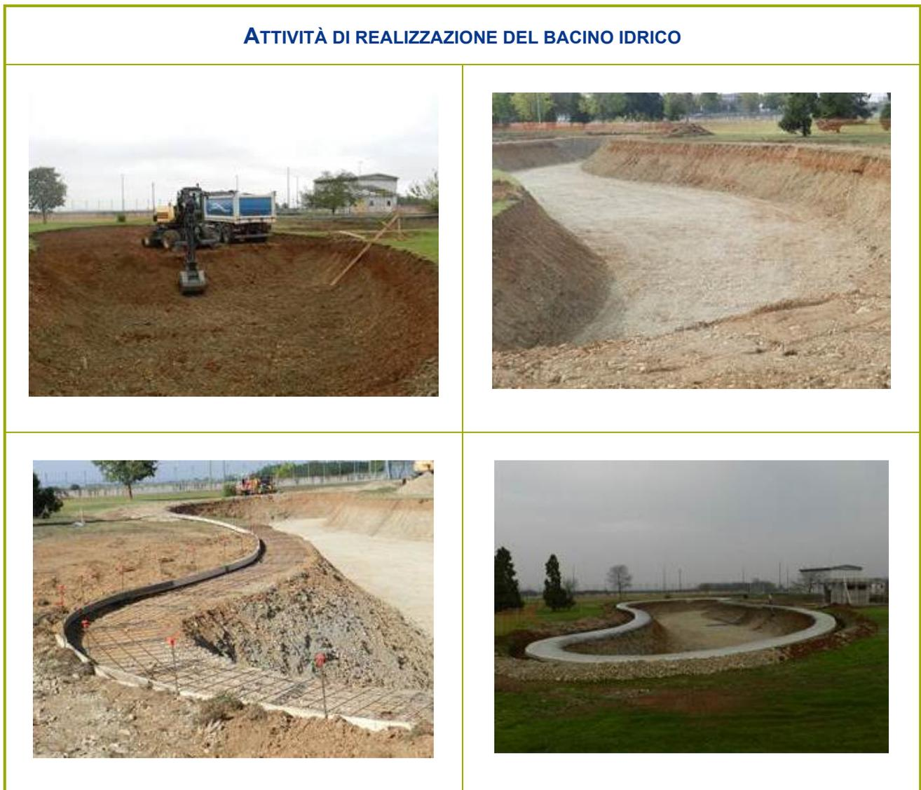
**Figura 2-111 – Attività di realizzazione del bacino idrico**
