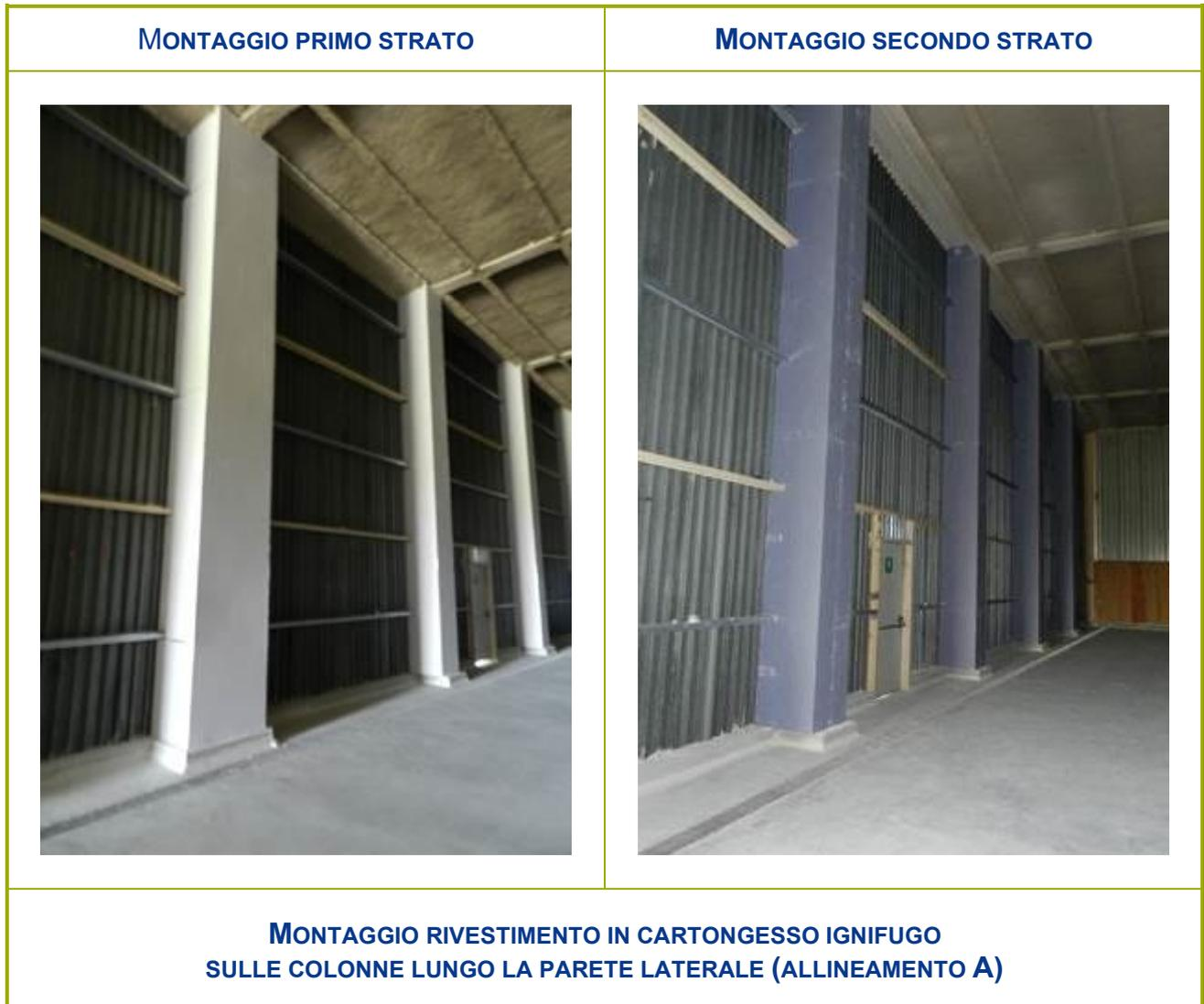
**Figura 2-65 – Montaggio del rivestimento in cartongesso ignifugo sulle colonne lungo la parete laterale (Allineamento A)**
