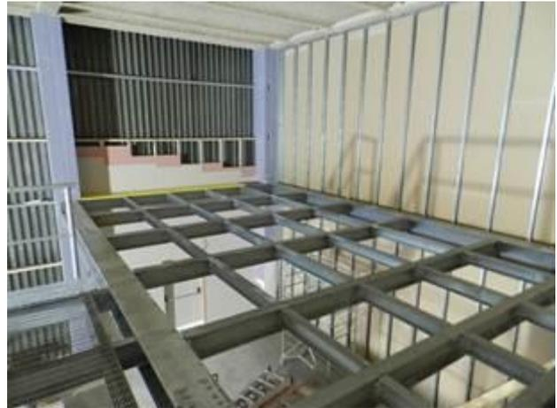
Figura 2-74 – Montaggio pareti laterali del soppalco
