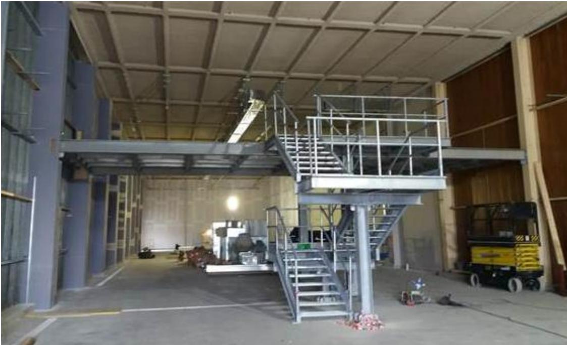
Figura 2-73 – Montaggio struttura metallica del soppalco
