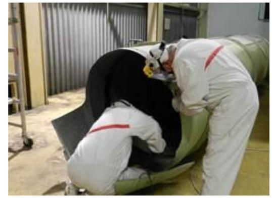
**Figura 2-25 – Smantellamento tubazioni nel locale A221 dell'Edificio BLD2**
