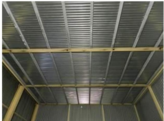
**Figura 2-58 – Attività di montaggio della lamiera grecata sul soffitto del locale B106**
