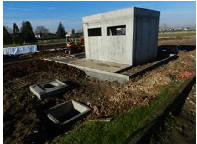
**Figura 2-112 – Attività di realizzazione dell'edificio per il posizionamento del sistema di pressurizzazione**
