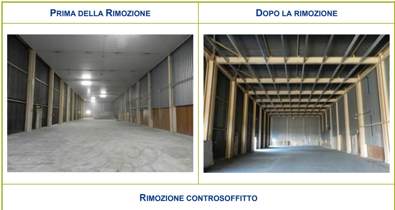
**Figura 2-57 – Attività di rimozione del controsoffitto del locale B106**
