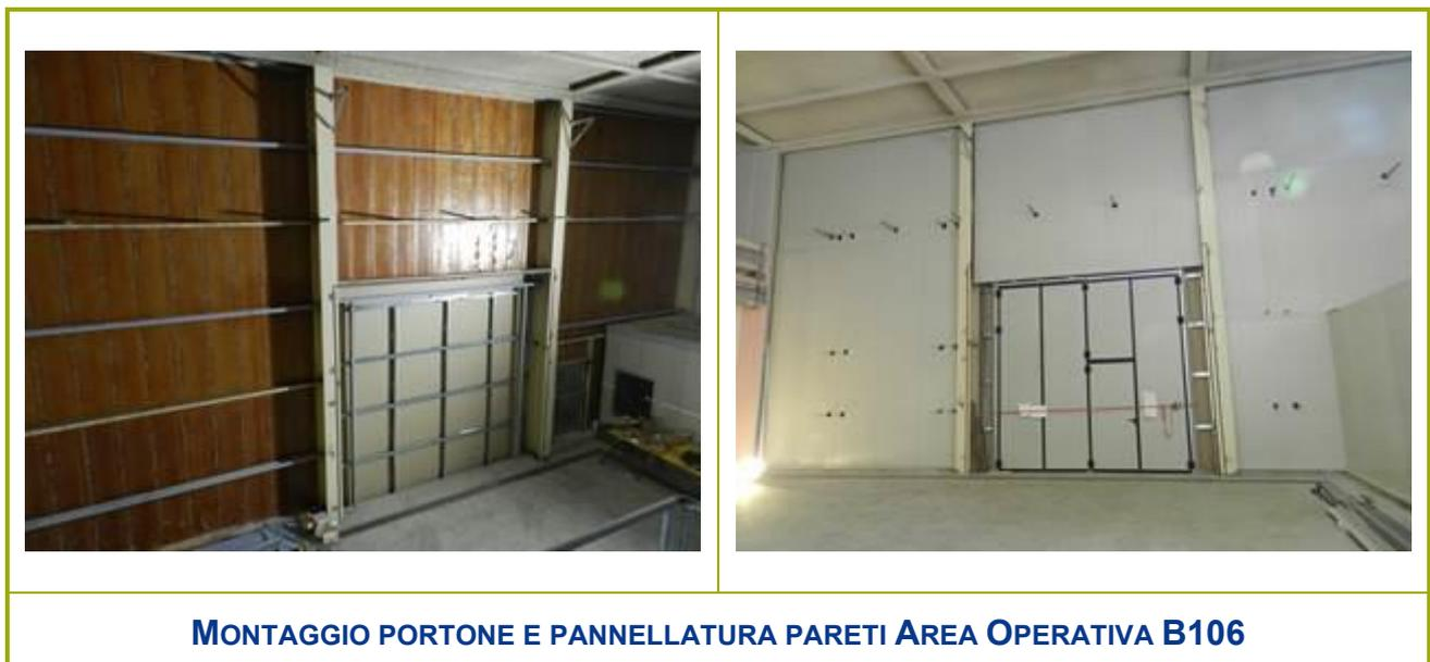
**Figura 2-72 – Montaggio del Portone e della pannellatura sulle pareti dell'Area Operativa B106**
