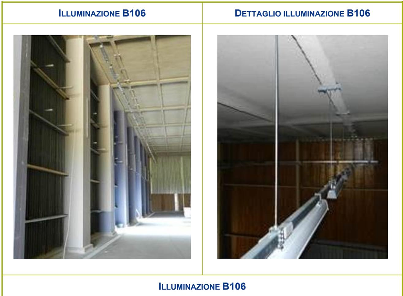
**Figura 2-67 – Montaggio delle plafoniere per l’illuminazione del locale B106**
