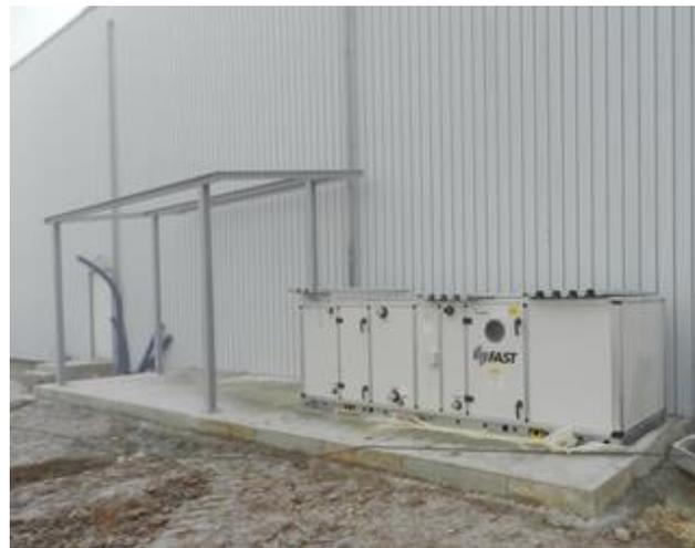
**Figura 2-79 – Installazione UTA esterna su basamento in calcestruzzo**
