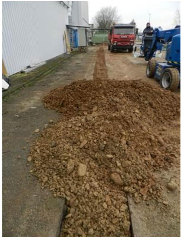
**Figura 2-83 – Posa tubazioni interrate del sistema drenaggi**
