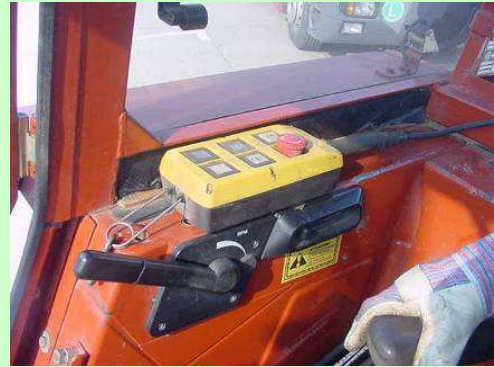
Esempio di comandi riportati in cabina
