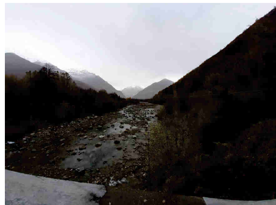
Deposito a monte del ponte da movimentare
