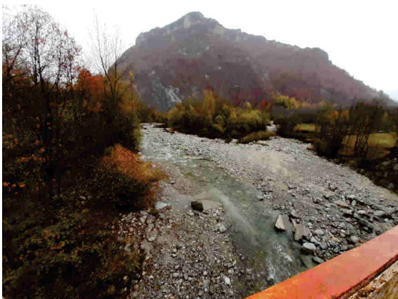
Deposito a valle del ponte da asportare
