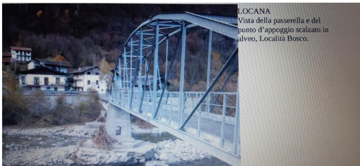
Figura 7. Scalzamento pila attraversamento torrente Orco in località Bosco
