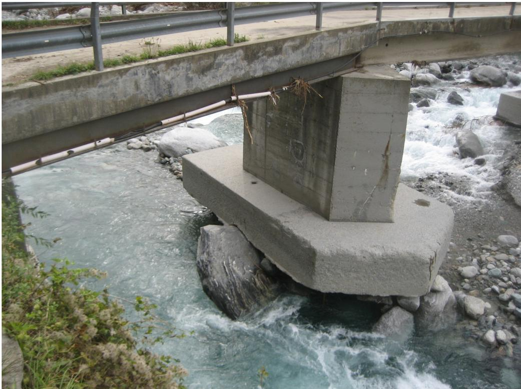
*Figura 5. Erosioni erosioni pile ponte in località Crotto*
