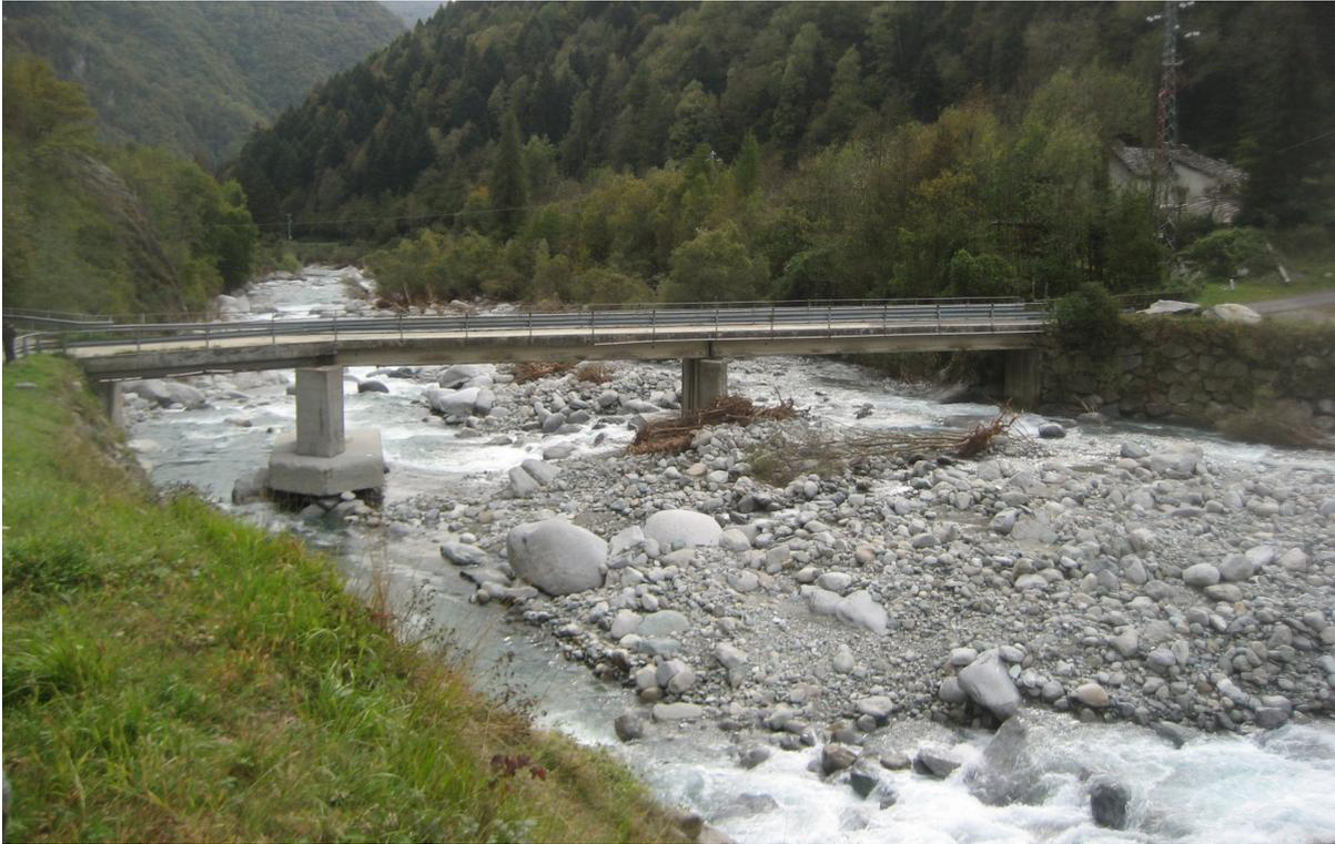
*Figura 4. Erosioni pile accumulo materiale ponte torrente Soana località Crotto*
