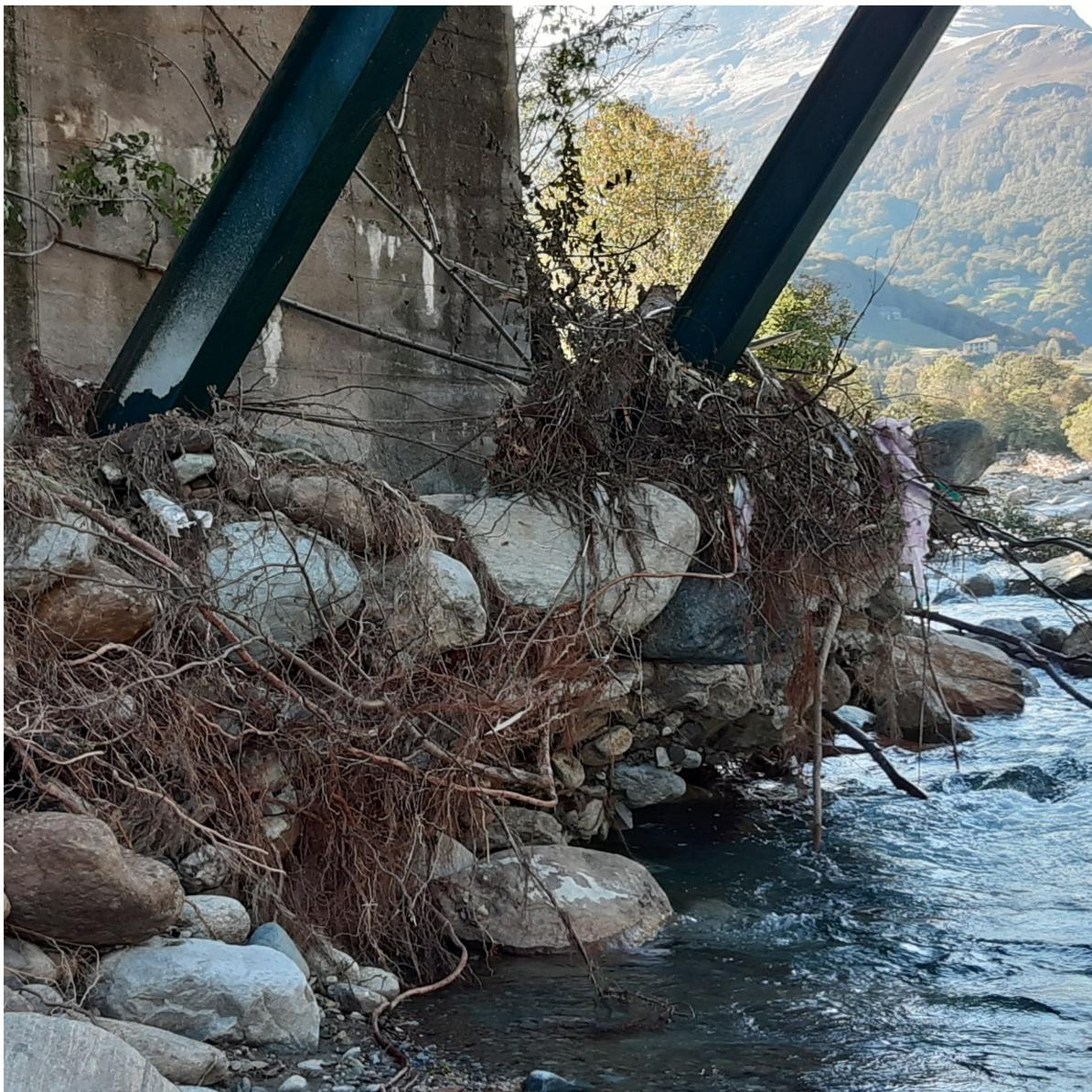
*Figura 1. Erosione pila ponte Bailey*
