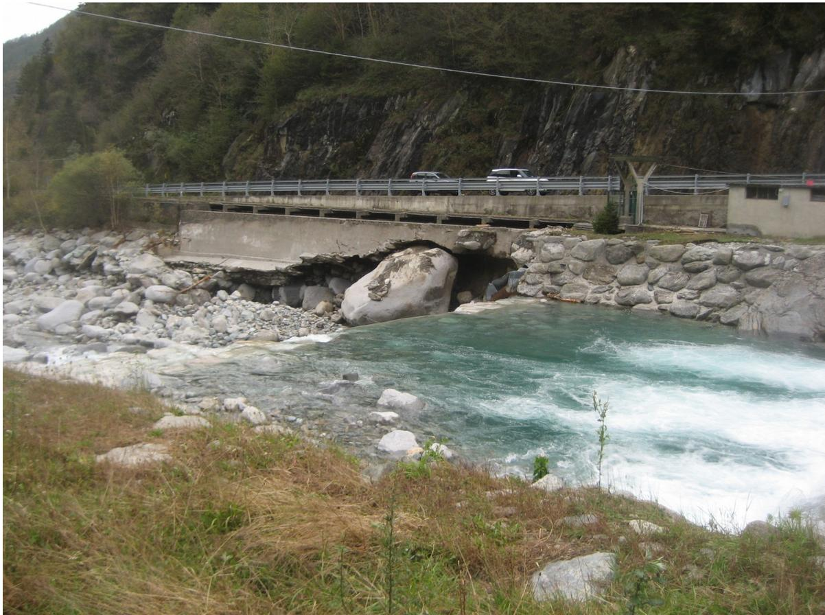
*Figura 3. Erosioni spondali torrente Soana località Montelavecchia*
