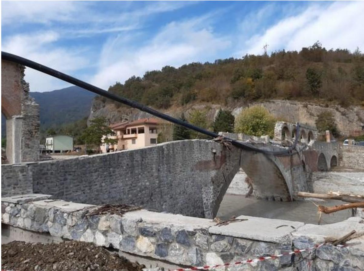
Figura 6. Bagnasco: arcate crollate del ponte di epoca romana
