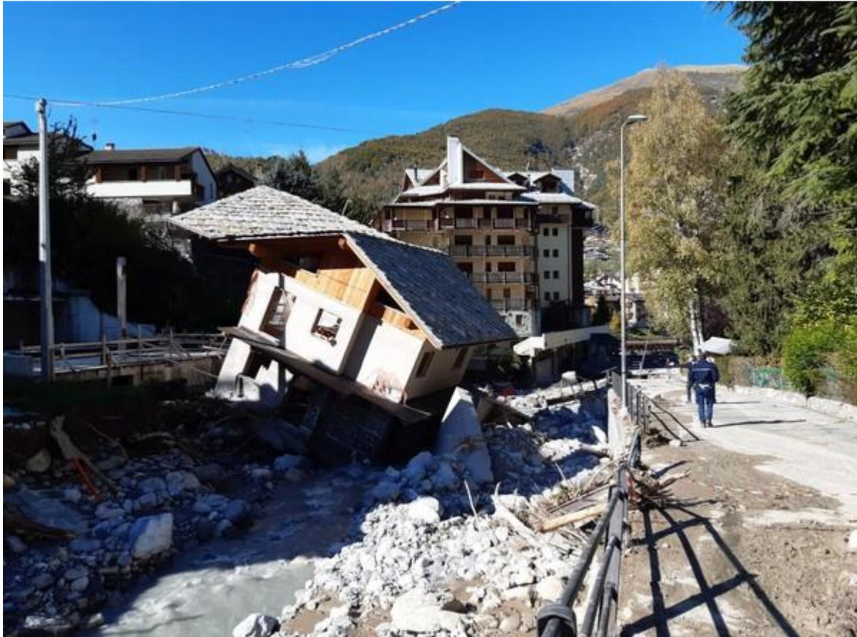
*Figura 8. Casa in ristrutturazione crollata nell'alveo del rio San Giovanni nel comune di Limone Piemonte (CN)*
