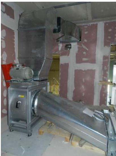
Figura 2-84 – Installazione ventilatore di estrazione e canister
