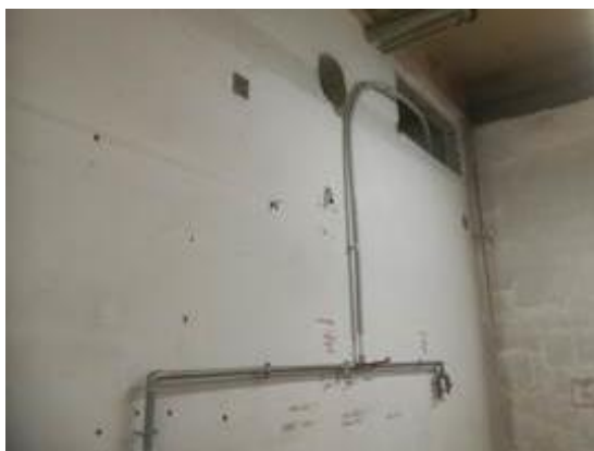
Figura 2-47 – Predisposizione tubazione scarico effluenti liquidi di cantiere
