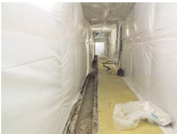
Figura 2-52 – Scarifica cunicolo corridoio A214
