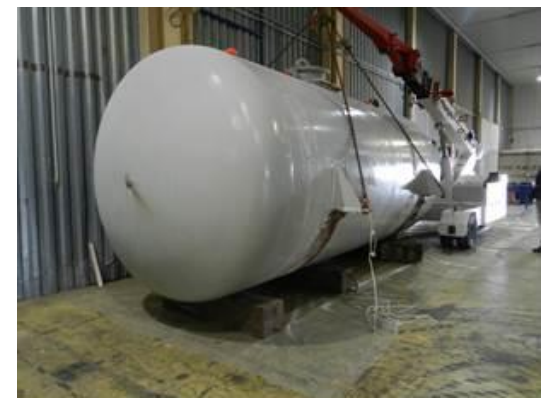
Figura 2-31 – Rimozione del serbatoio SR6 e posizionamento nel locale B106
