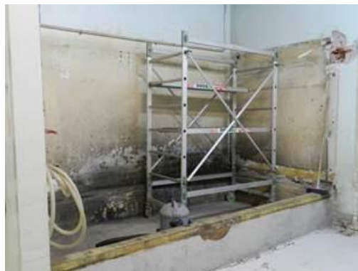
Figura 2-40 – Smantellamento della vasca di decontaminazione
