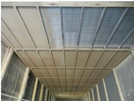
Figura 2-63 – Attività di posa dell'intonaco ignifugo
