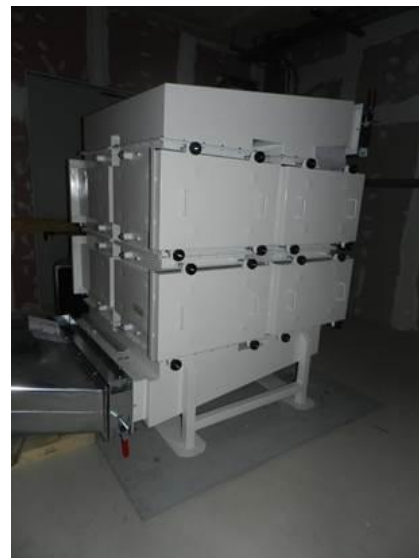
Figura 2-84 – Installazione ventilatore di estrazione e canister
