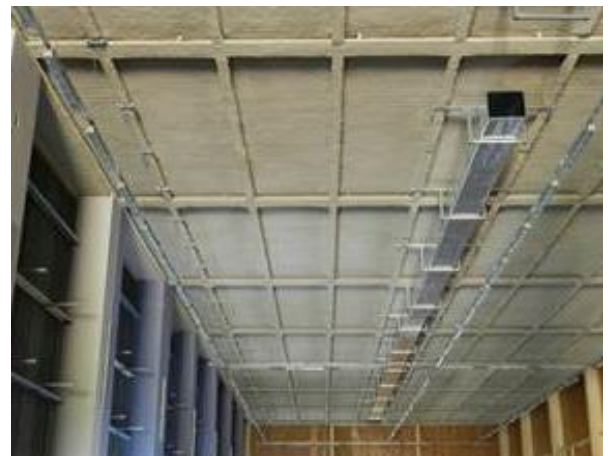
Figura 2-66 – Attività di posa staffaggi e condotta ventilazione sul soffitto B106
