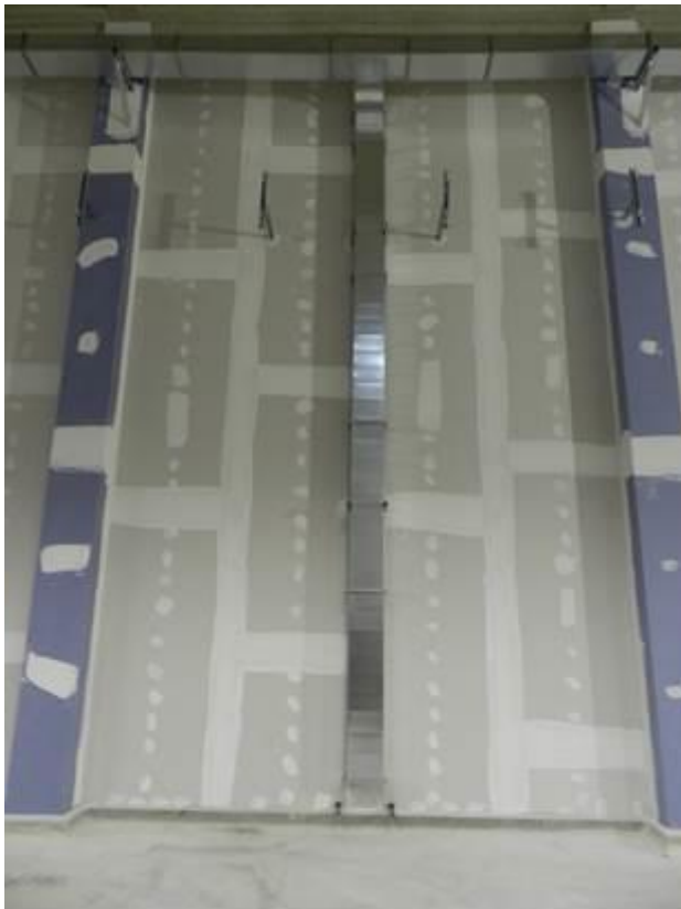
Figura 2-75 – Montaggio condotte di ventilazione
