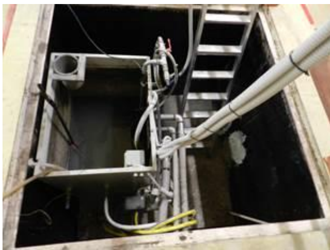
Figura 2-36 – Rimozione del serbatoio SR1 ed inserimento nuovo serbatoio
