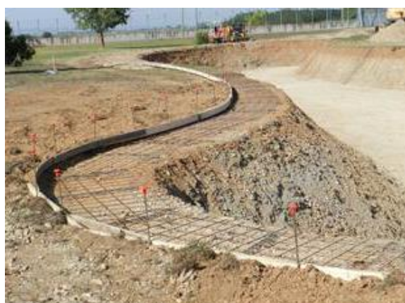
Figura 2-108 – Attività di realizzazione del bacino idrico
