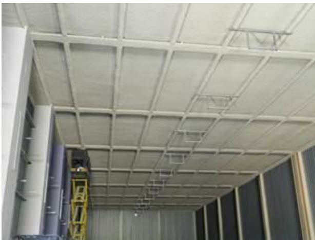
Figura 2-66 – Attività di posa staffaggi e condotta ventilazione sul soffitto B106
