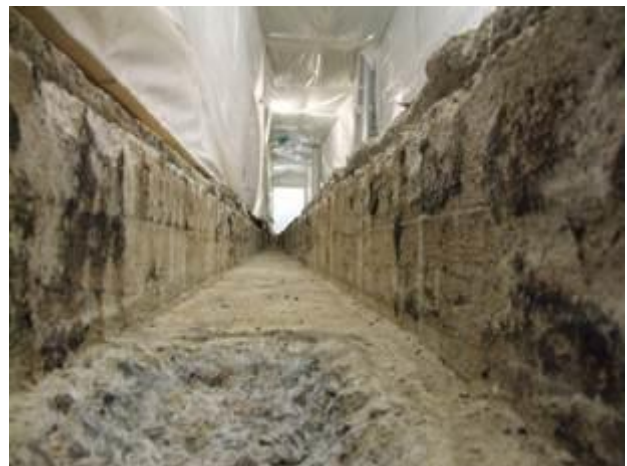
Figura 2-53 – Scarifica cunicolo corridoio A214
