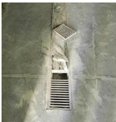
Figura 2-60 – Attività di montaggio delle canaline del sistema drenaggi all'interno del B106
