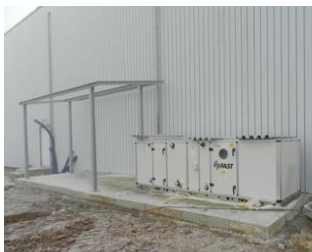
Figura 2-78 – Installazione UTA esterna su basamento in calcestruzzo
