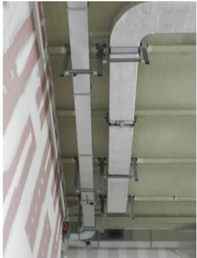
Figura 2-75 – Montaggio condotte di ventilazione
