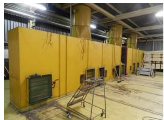
Figura 2-26 – Smantellamento filtrazione nel locale A221 dell'Edificio BLD2
