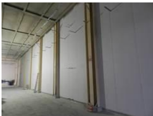
Figura 2-70 – Attività di rivestimento in cartongesso pareti Area di Stoccaggio
