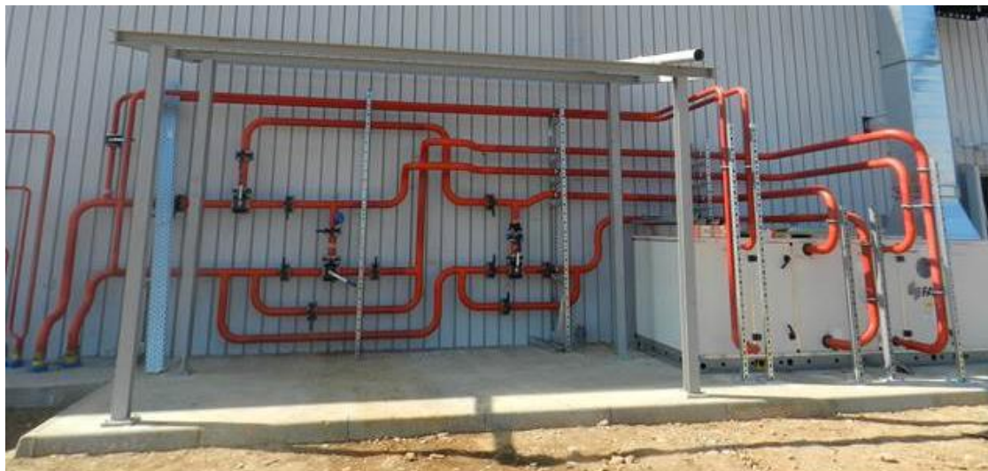
Figura 2-80 – Montaggio tubazioni per fluidi termovettori
