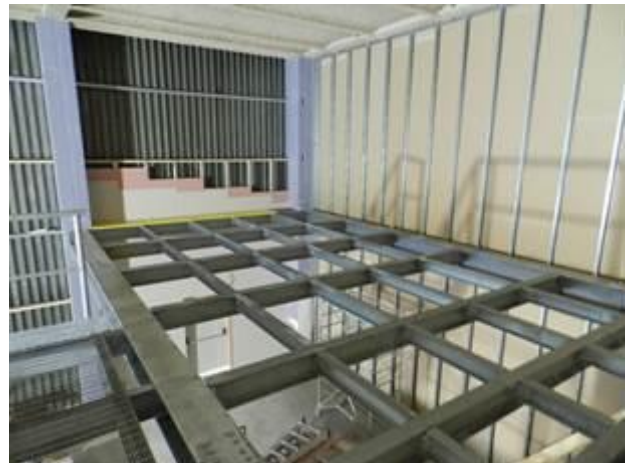
Figura 2-73 – Montaggio pareti laterali del soppalco
