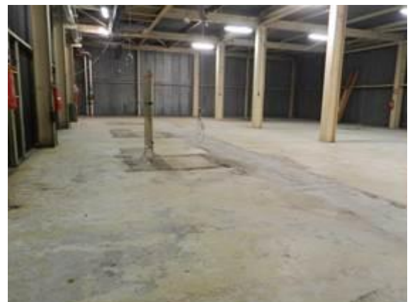
Figura 2-33 – Rimozione del linoleum nel locale A221
