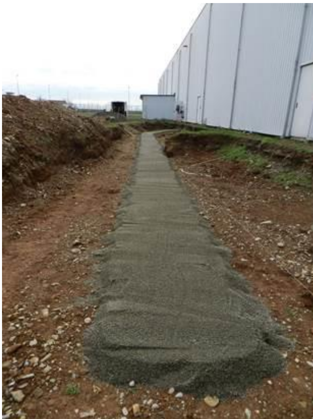
Figura 2-76 – Montaggio tubazioni interrate per fluidi termovettori
