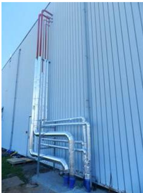
Figura 2-82 – Attività di coibentazione delle tubazioni dei fluidi termovettori
