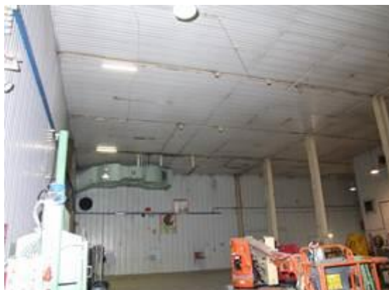
Figura 2-19 – Smantellamento mandata e ricircolo in area A110 (tubazioni verdi e grigie)
