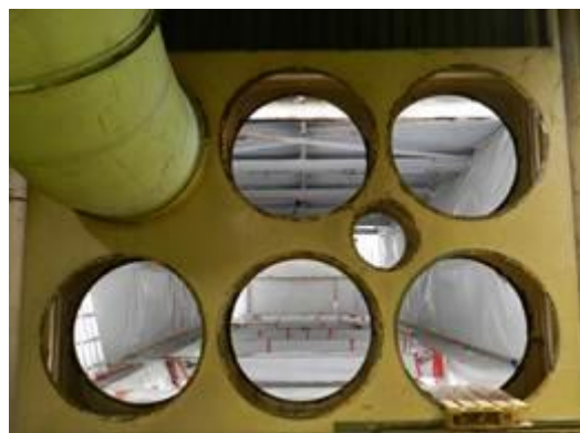
Figura 2-24 – Smantellamento delle condotte di ventilazione poste sopra al corridoio di passaggio che unisce l'Edificio BLD1 con l'Edificio BLD2
