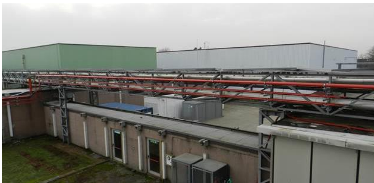
Figura 2-80 – Montaggio tubazioni esterne per fluidi termovettori
