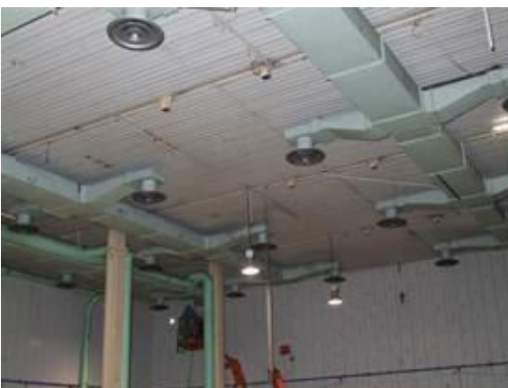
Figura 2-16 – Smantellamento impianto di espulsione nell'area A110 (filtri e tubazioni gialle)
