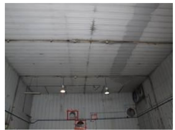
Figura 2-20 – Smantellamento mandata e ricircolo nel locale A109 (tubazioni verdi e grigie)
