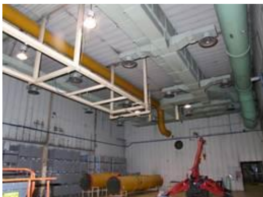
Figura 2-18 – Smantellamento impianto di espulsione nel locale A109 (tubazioni gialle)
