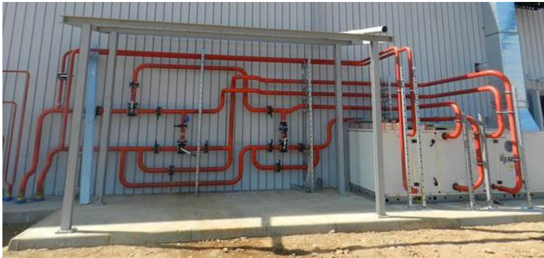
Figura 2-81 – Montaggio tubazioni per fluidi termovettori
