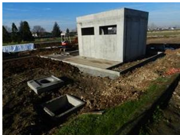
Figura 2-109 – Attività di realizzazione dell'edificio per il posizionamento del sistema di pressurizzazione
