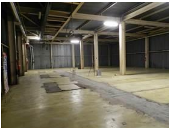
Figura 2-34 – Rimozione del linoleum nel locale A221
