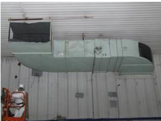
Figura 2-22 – Smantellamento impianto di ventilazione nelle aree A102, A103, A104, A105 e A107
