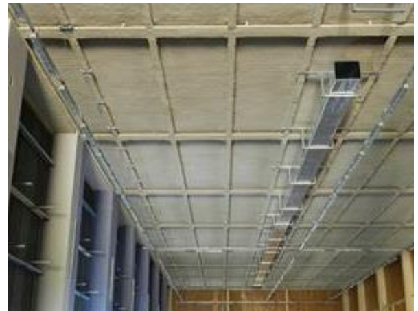
Figura 2-65 – Attività di posa staffaggi e condotta ventilazione sul soffitto B106
