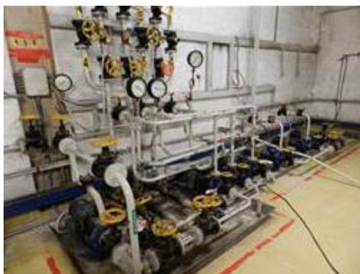
Figura 2-39 – Smantellamento del sistema di trasferimento dei liquidi radioattivi
