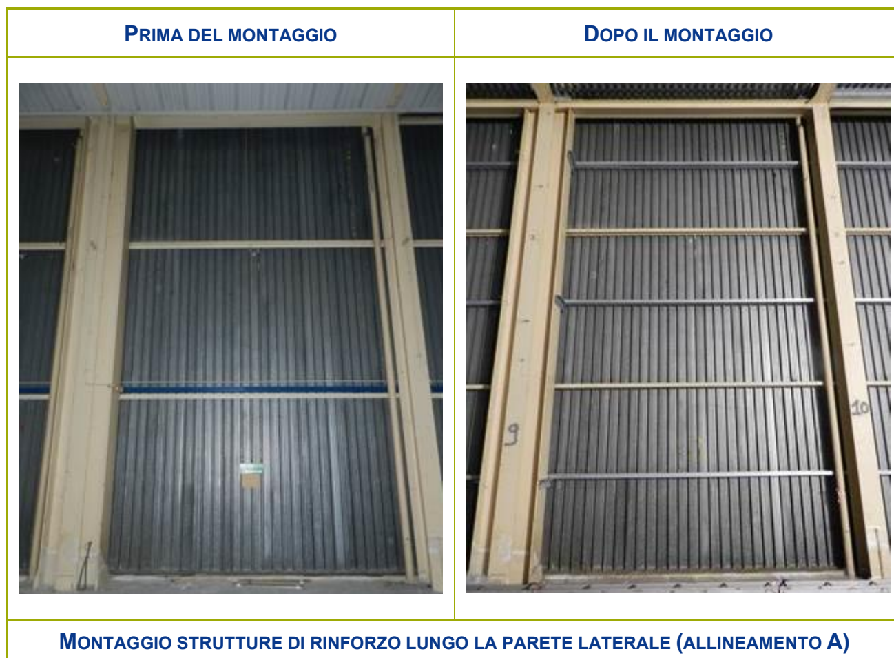
Figura 2-59 – Montaggio strutture di rinforzo lungo la parete laterale (Allineamento A)
