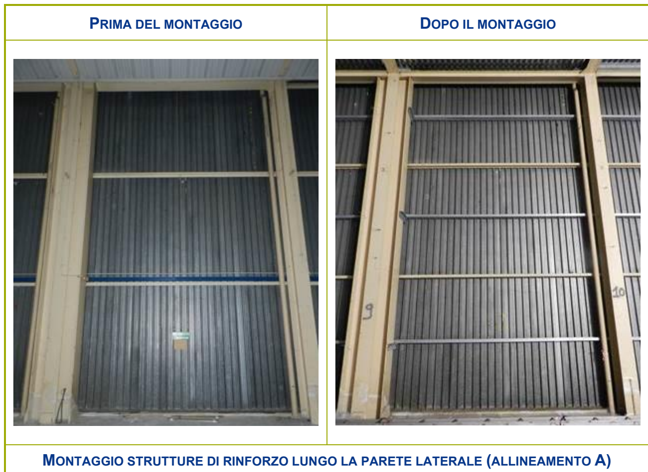
Figura 2-58 – Montaggio strutture di rinforzo lungo la parete laterale (Allineamento A)
