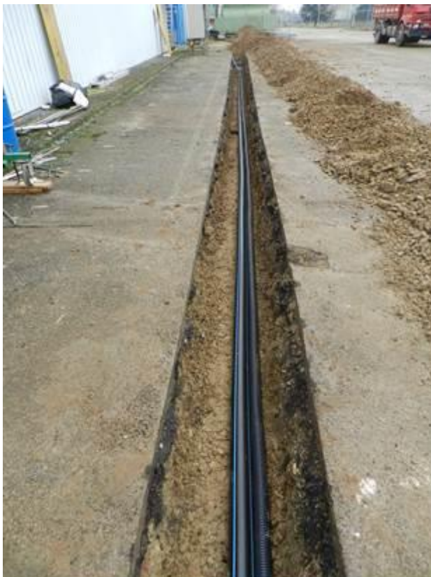
Figura 2-82 – Posa tubazioni interrate del sistema drenaggi
