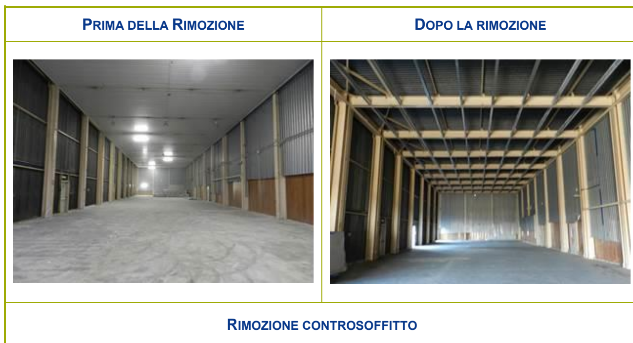
Figura 2-56 – Attività di rimozione del controsoffitto del locale B106
