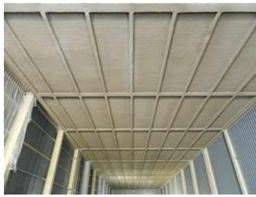
Figura 2-63 – Attività di posa dell'intonaco ignifugo
