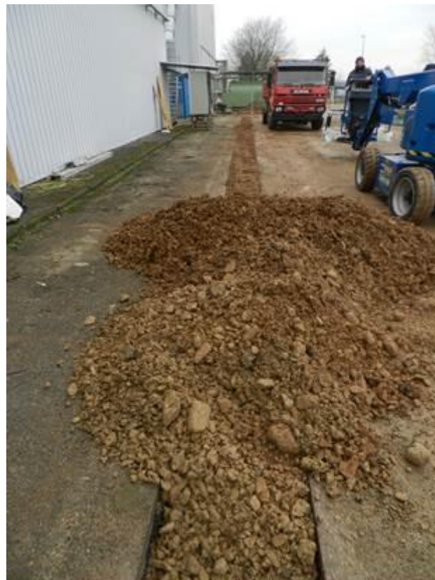
Figura 2-83 – Posa tubazioni interrate del sistema drenaggi
