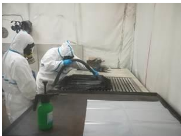
Figura 2-43 – Smantellamento prefiltri e filtri nell'area di taglio A104
