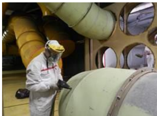
Figura 2-24 – Smantellamento tubazioni nel locale A221 dell'Edificio BLD2
