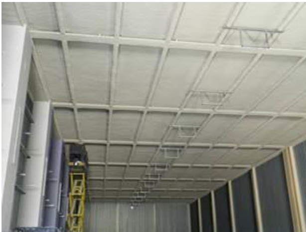
Figura 2-65 – Attività di posa staffaggi e condotta ventilazione sul soffitto B106
