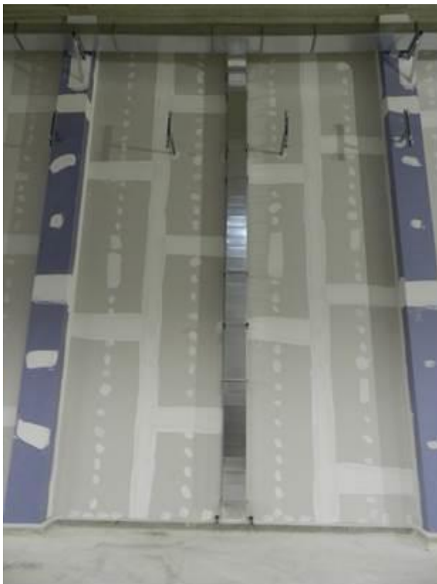
Figura 2-76 – Montaggio condotte di ventilazione
