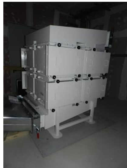
Figura 2-85 – Installazione ventilatore di estrazione e canister
