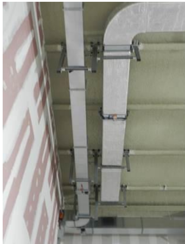
Figura 2-76 – Montaggio condotte di ventilazione
