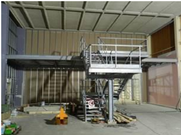
Figura 2-73 – Montaggio pareti laterali del soppalco
