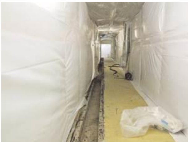
Figura 2-53 – Scarifica cunicolo corridoio A214
