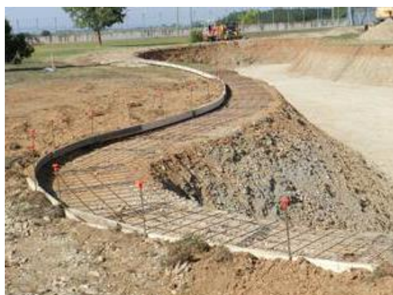
Figura 2-107 – Attività di realizzazione del bacino idrico
