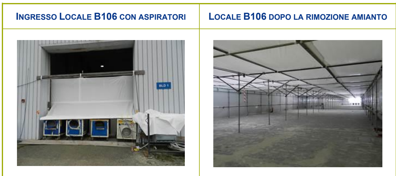
Figura 2-56 – Attività di rimozione amianto dalla pavimentazione del locale B106
