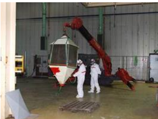
Figura 2-17 – Smontaggio filtri elettrostatici nell'area A124
