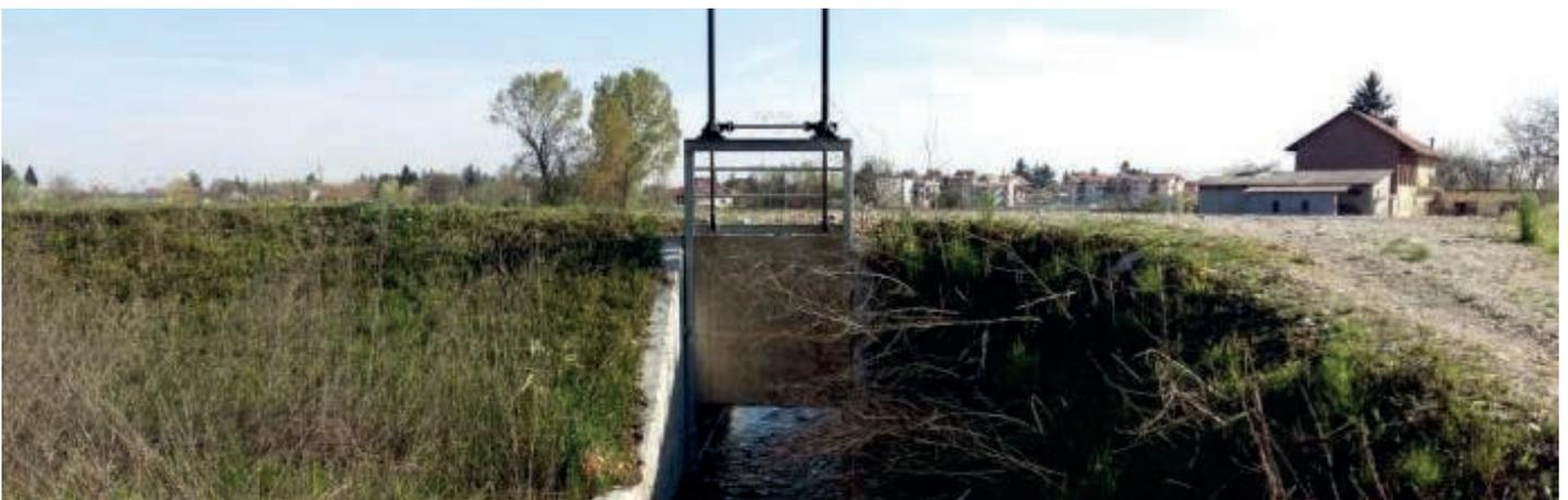
L'esecuzione dei lavori ha comportato anche la realizzazione di rampe di accesso ai fondi agricoli, il rifacimento di tubazioni irrigue con le relative opere di regolamentazione e la realizzazione di nuove paratoie sui canali Pertusio e Chiaretto per impedire che l'onda di piena attraverso questi ultimi possa confluire nell'area protetta dall'argine.
