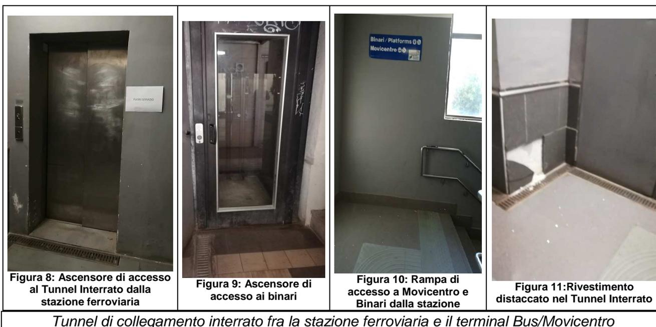
Il Tunnel di collegamento necessita di una più attenta manutenzione: le pareti presentano infatti parti di rivestimento distaccate e parti di intonaco deteriorate che andrebbero ripristinate.
