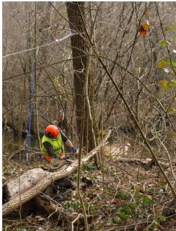
Ripristino deflusso del canale Naviglia ad Avigliana: ancoraggio del tronco e trasporto a riva con l'ausilio del verricello e successivo sezionamento. Foto arch. EGAPAC
