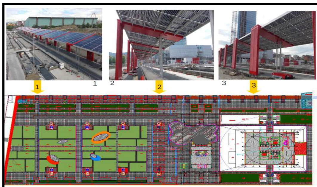
Figura 4 - Stato finale dell'opera Lotto 1 – opera conclusa
