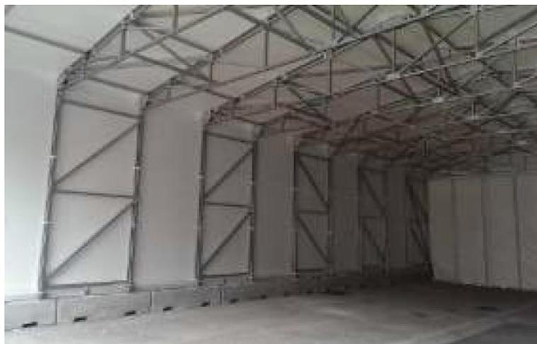
La segregazione delle aree di lavoro è avvenuta utilizzando una struttura mobile prefabbricata, chiusa su due lati e dotata di copertura.
