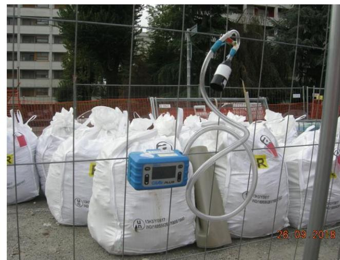
Il ritrovamento, a più riprese, di materiale contenente amianto nelle strutture del cavalcavia e nella rete infrastrutturale ad esso collegata su una vasta area del cantiere ha richiesto l'attuazione di specifici **Piani di Lavoro** concordati con le autorità sanitarie per la rimozione dei materiali e per la successiva bonifica dei siti, con la necessità di sospendere le lavorazioni programmate nelle aree di lavoro
