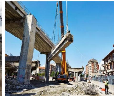
Durante i lavori è stato modificato il sistema di abbattimento di parte del manufatto in sito con pinze e frantumatori per mitigare i tempi di demolizione del viadotto, fortemente compromessi a causa delle attività di gestione dei materiali contenenti amianto
