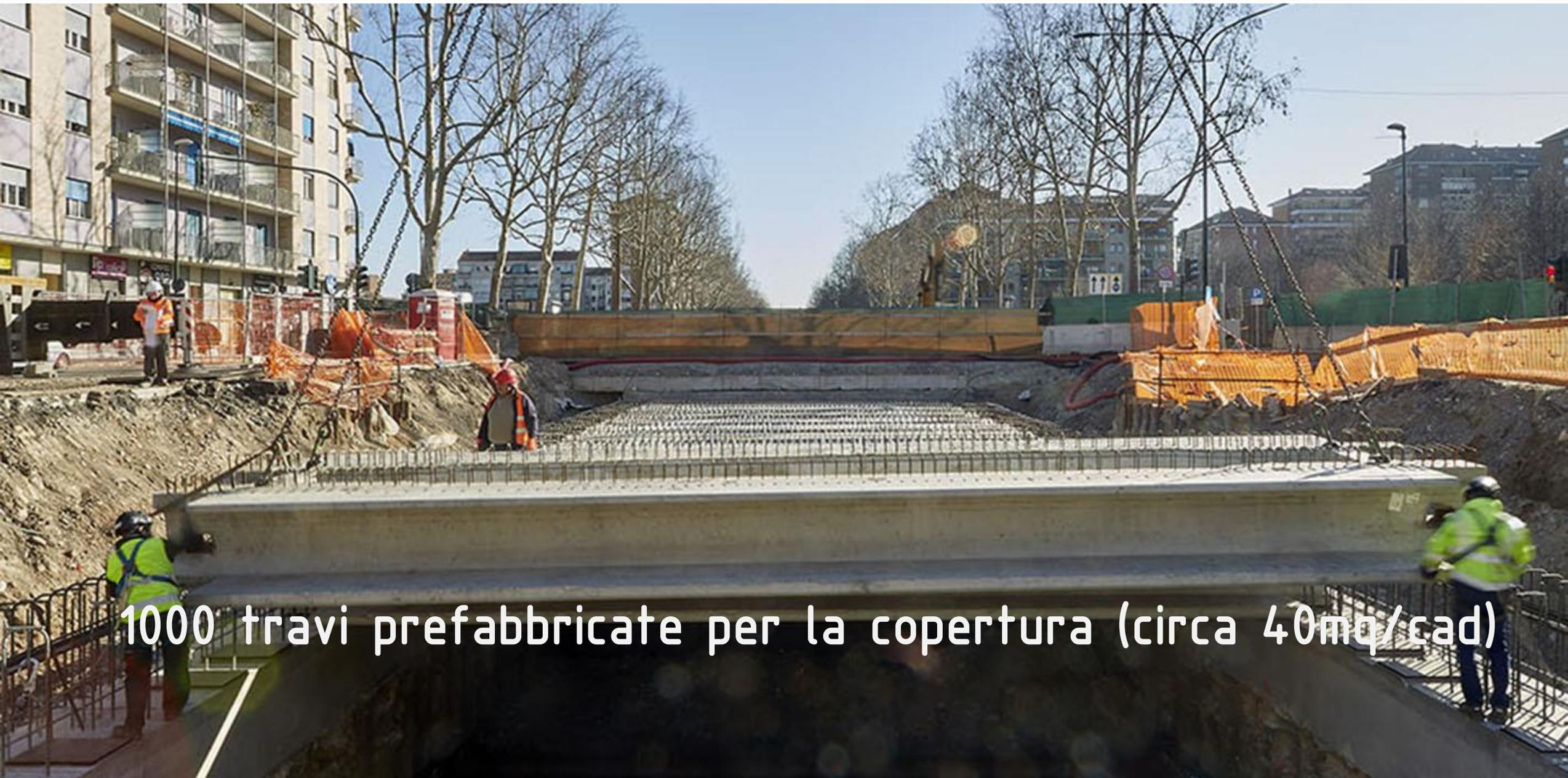
1000 travi prefabbricate per la copertura (circa 40mq/cad)
