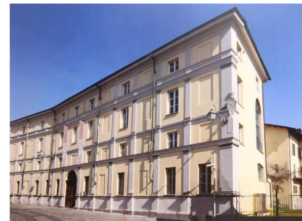
La facciata su corso del Piazza
