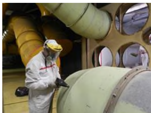
Figura 2-24 – Smantellamento tubazioni nel locale A221 dell’Edificio BLD2
