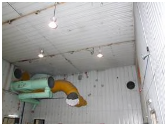
Figura 2-20 – Smantellamento impianto di ventilazione nel locale A108
