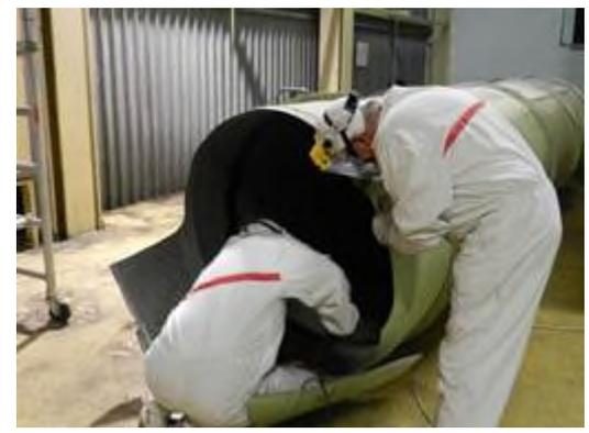
**Figura 2-24 – Smantellamento tubazioni nel locale A221 dell'Edificio BLD2**
