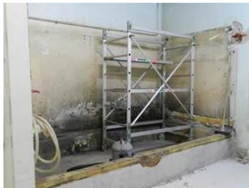
Figura 2-39 – Smantellamento della vasca di decontaminazione
