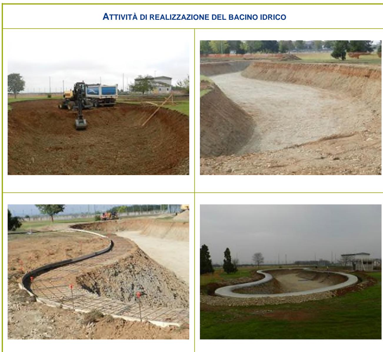
**Figura 2-52 – Attività di realizzazione del bacino idrico**
