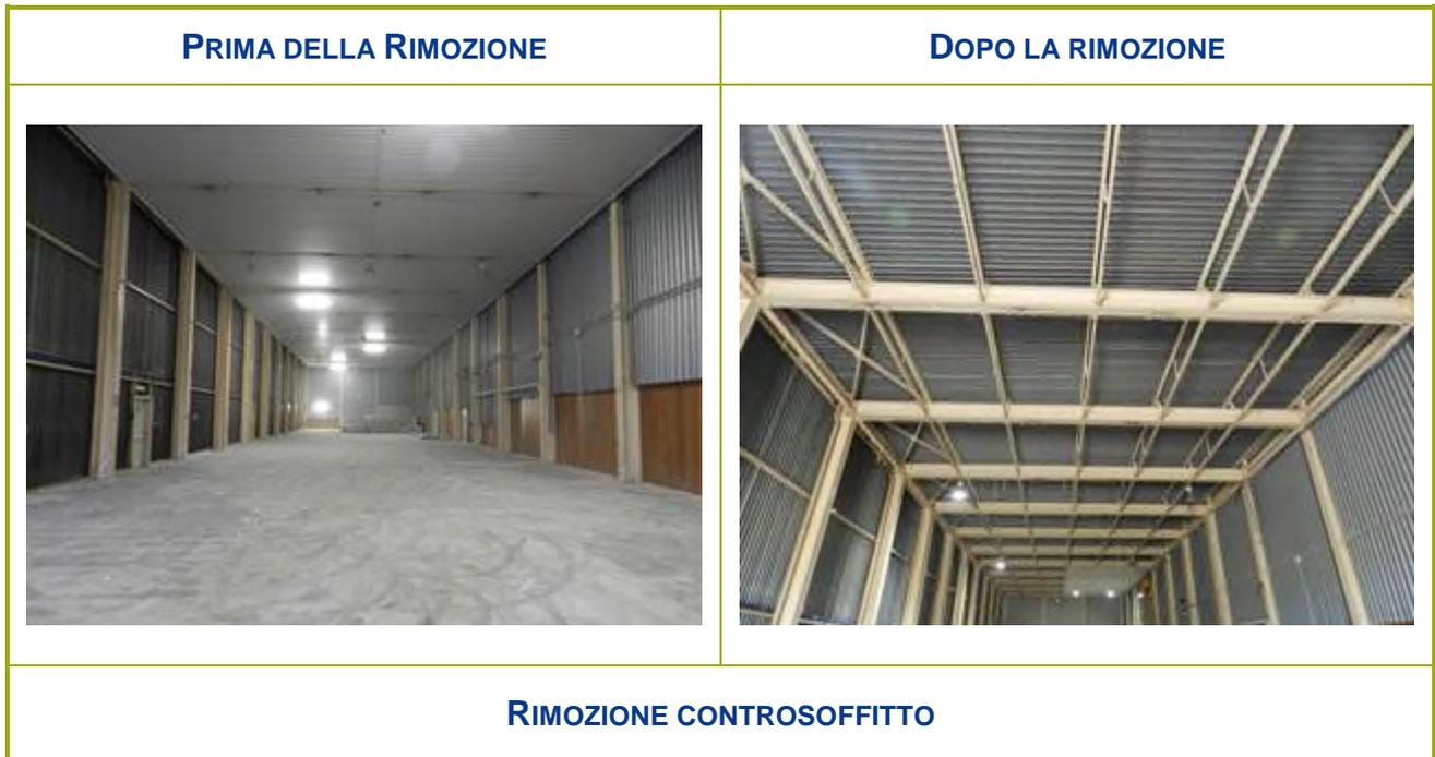
**Figura 2-44 – Attività di rimozione del controsoffitto del locale B106**
