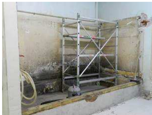
Figura 2-39 – Smantellamento della vasca di decontaminazione
