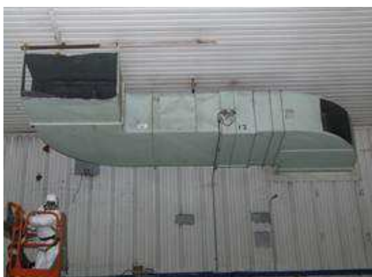
Figura 2-21 – Smantellamento impianto di ventilazione nelle aree A102, A103, A104, A105 e A107
