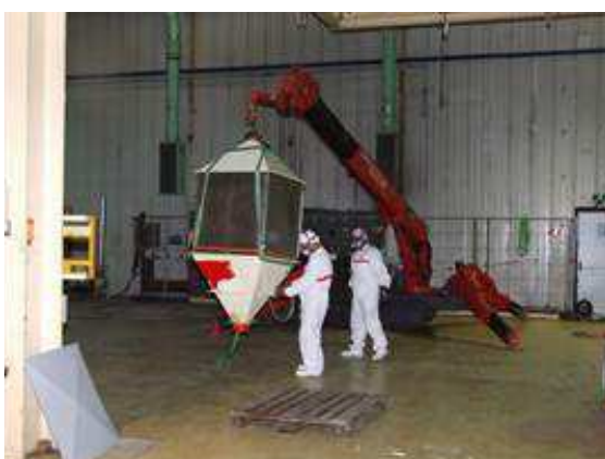
Figura 2-16 – Smontaggio filtri elettrostatici nell'area A124
