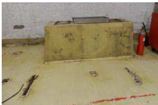
Figura 2-37 – Rimozione del serbatoio SR3
