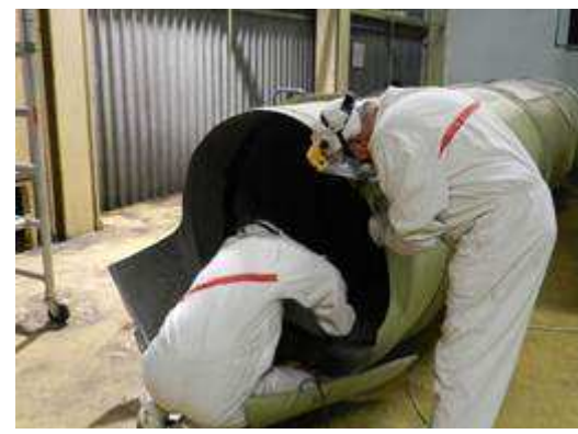
Figura 2-24 – Smantellamento tubazioni nel locale A221 dell'Edificio BLD2
