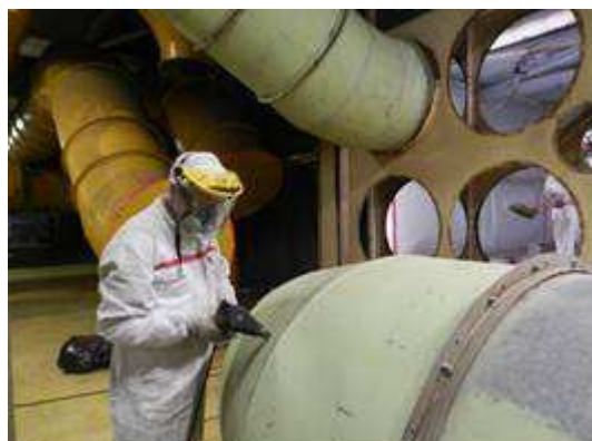
Figura 2-24 – Smantellamento tubazioni nel locale A221 dell'Edificio BLD2
