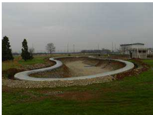
Figura 2-51 – Attività di realizzazione del bacino idrico
