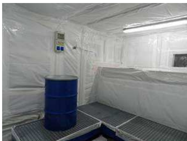
Posizionamento del fusto all'interno della capannina
