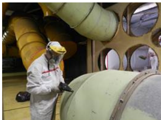
Figura 2-24 – Smantellamento tubazioni nel locale A221 dell'Edificio BLD2
