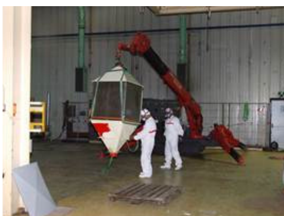
Figura 2-16 – Smontaggio filtri elettrostatici nell'area A124
