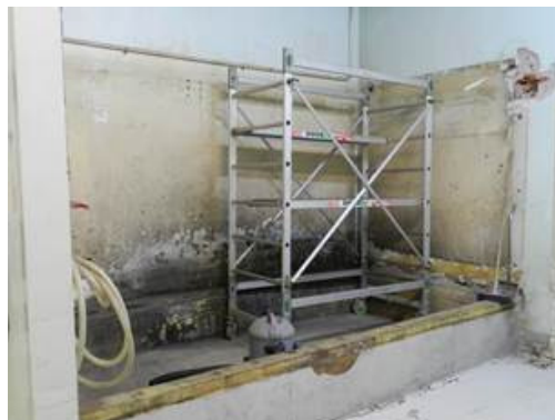
Figura 2-39 – Smantellamento della vasca di decontaminazione
