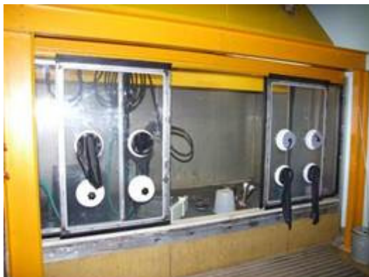
Figura 2-39 – Smantellamento della vasca di decontaminazione
