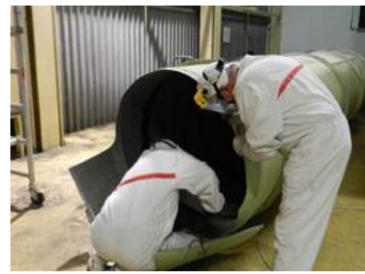
Figura 2-24 – Smantellamento tubazioni nel locale A221 dell'Edificio BLD2
