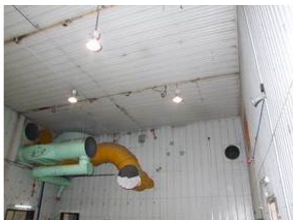
Figura 2-20 – Smantellamento impianto di ventilazione nel locale A108
