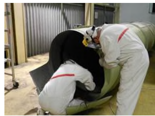
Figura 2-24 – Smantellamento tubazioni nel locale A221 dell'Edificio BLD2
