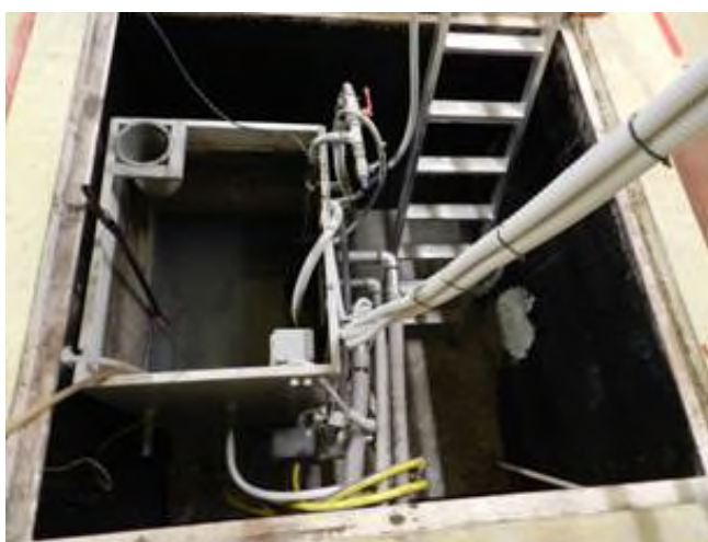
Figura 2-35 – Rimozione del serbatoio SR1 ed inserimento nuovo serbatoio
