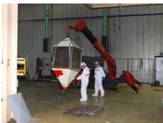
Figura 2-16 – Smontaggio filtri elettrostatici nell'area A124
