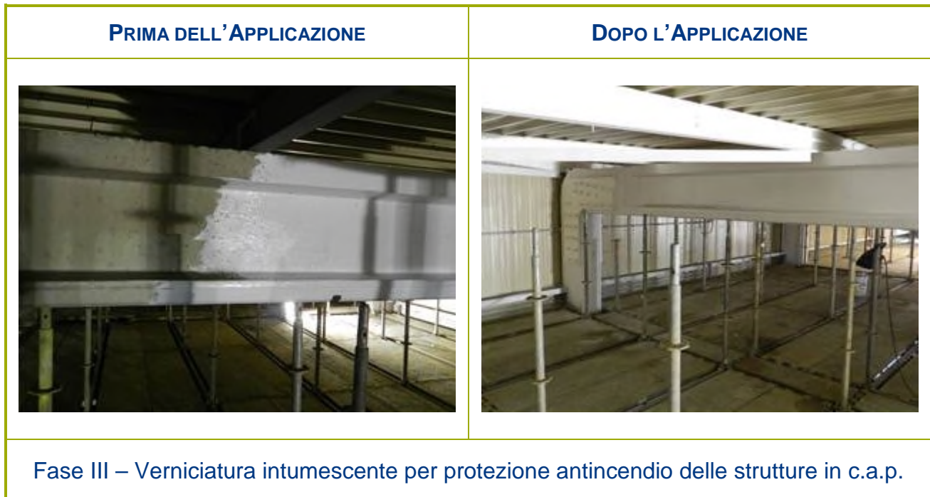
Figura 2-33 – Immagini attività di adeguamento dell’Edificio BLD11 (prima e dopo)
