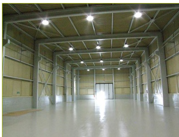
Figura 2-34 – Edificio BLD11 al termine delle attività di adeguamento
