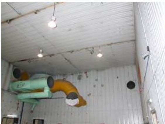
Figura 2-19 – Smantellamento impianto di ventilazione nel locale A108
