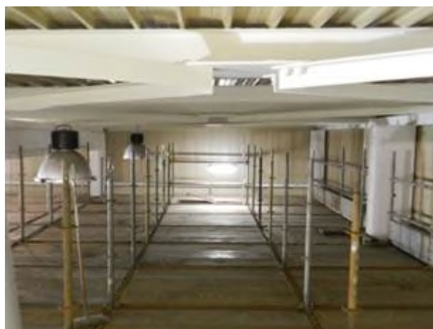
Fase III – Verniciatura intumescente per protezione antincendio delle travature
