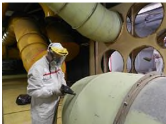
Figura 2-23 – Smantellamento tubazioni nel locale A221 dell'Edificio BLD2
