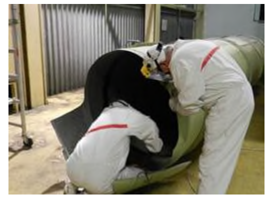
Figura 2-23 – Smantellamento tubazioni nel locale A221 dell'Edificio BLD2
