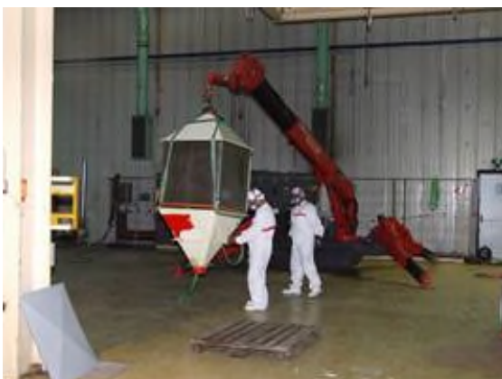
Figura 2-15 – Smontaggio filtri elettrostatici nell'area A124
