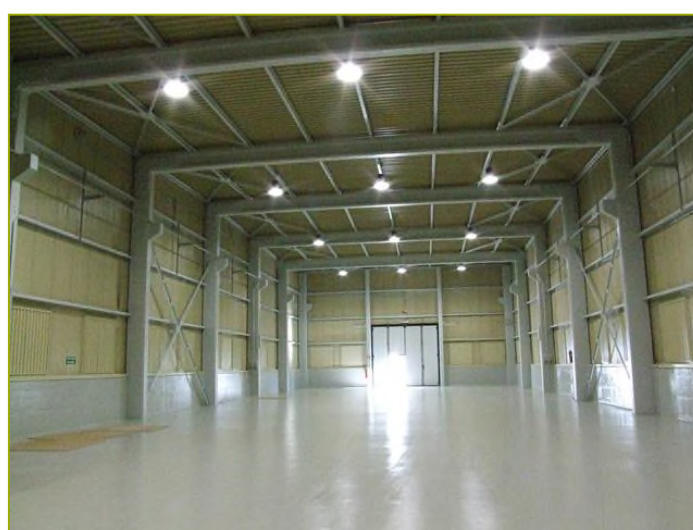
Figura 2-32 – Edificio BLD11 al termine delle attività di adeguamento
