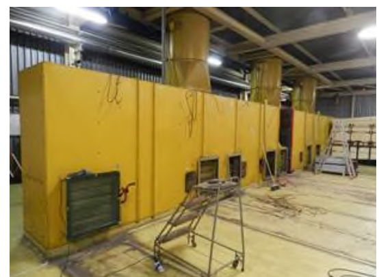
Figura 2-24 – Smantellamento filtrazione nel locale A221 dell'Edificio BLD2
