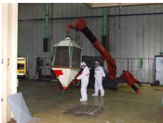
Figura 2-10 – Smontaggio filtri elettrostatici nell'area A124
