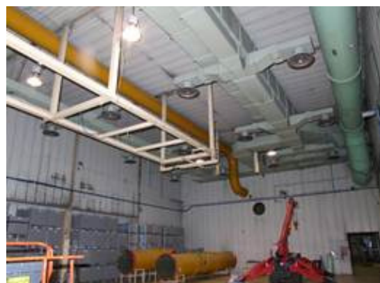
Figura 2-11 – Smantellamento impianto di espulsione nel locale A109 (tubazioni gialle)
