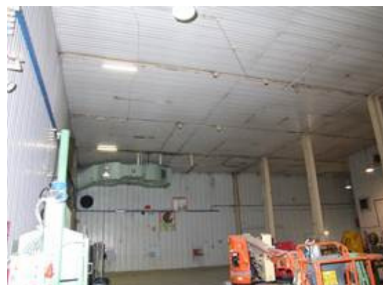
Figura 2-12 – Smantellamento mandata e ricircolo in area A110 (tubazioni verdi e grigie)
