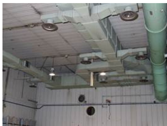
Figura 2-11 – Smantellamento impianto di espulsione nel locale A109 (tubazioni gialle)
