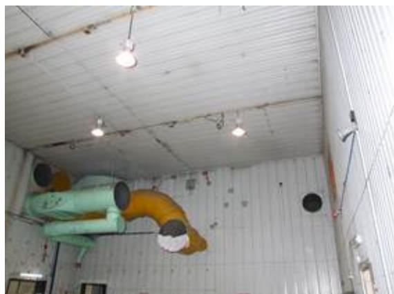
Figura 2-14 – Smantellamento impianto di ventilazione nel locale A108
