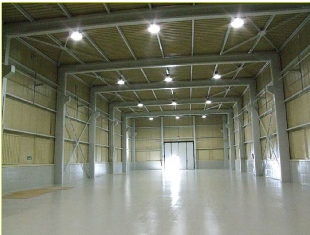
Figura 2-18 – Edificio BLD11 al termine delle attività di adeguamento
